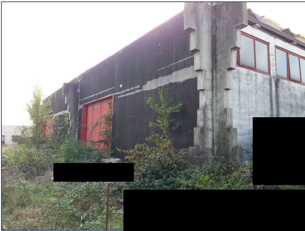
n° 3 - Facciata nord
