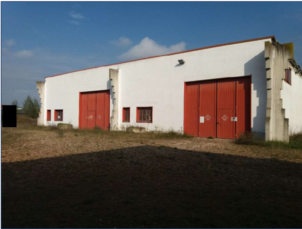
n° 2 - Facciata sud
