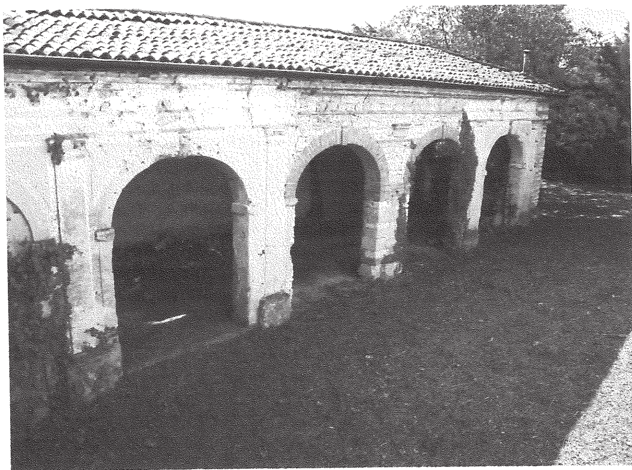
figura n. 12 – prospetto principale del porticato
