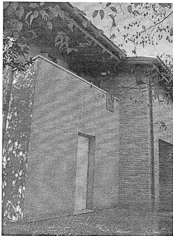
Foto 17 – vista da nord-est
