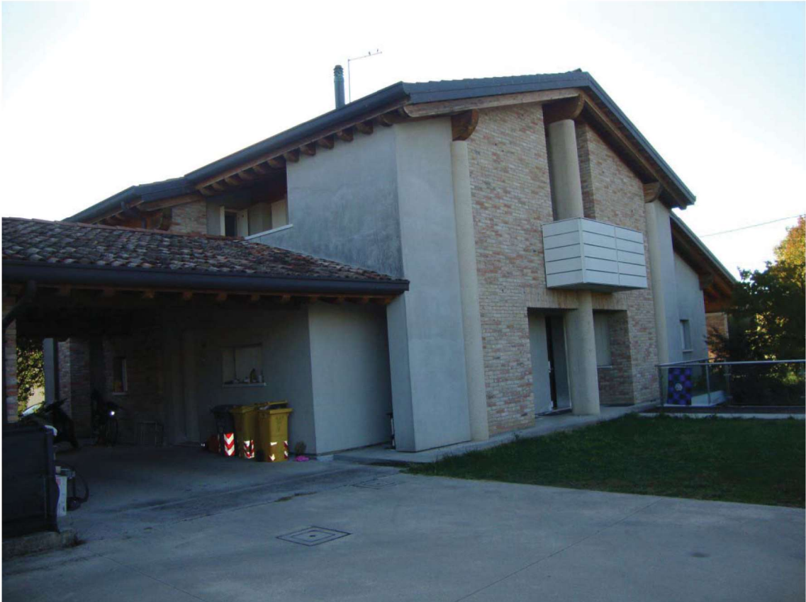
Foto 12 – vista da nord-ovest
