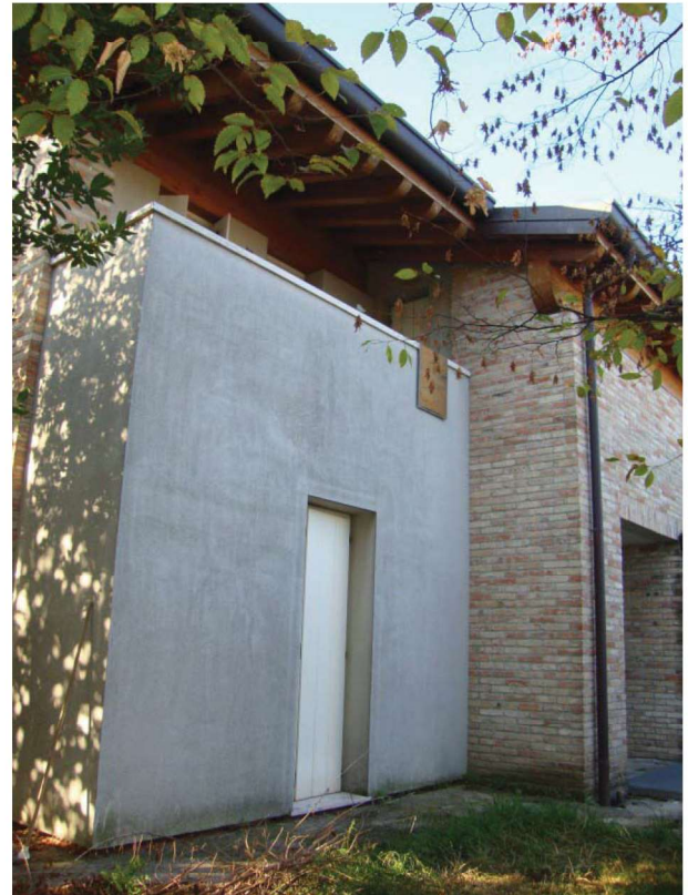
Foto 17 – vista da nord-est
