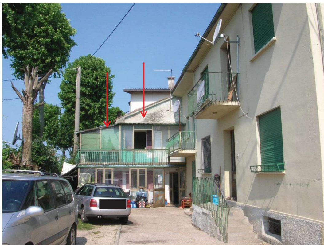
Fronte est – particolare - cortile con diritto di passaggio
