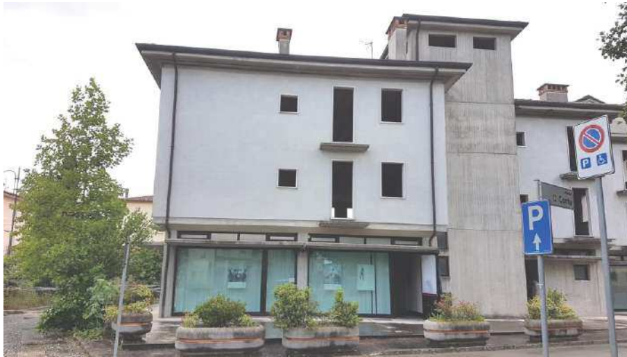
FOTO 7 : vista prospetto esterno lato est
