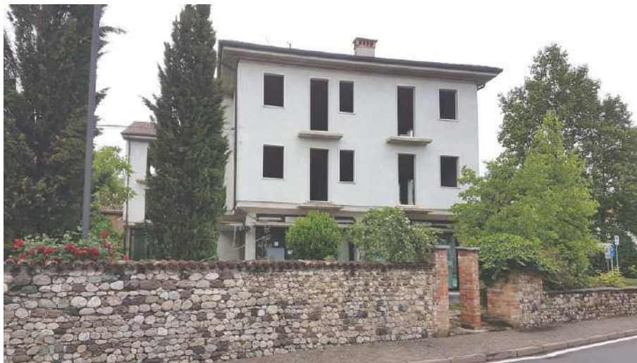
FOTO 8 : vista prospetto esterno lato sud
