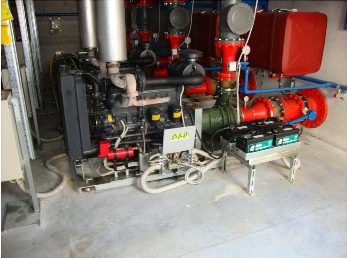
**Fig. 85 – particolare impianto antincendio vano pompe piano interrato**
