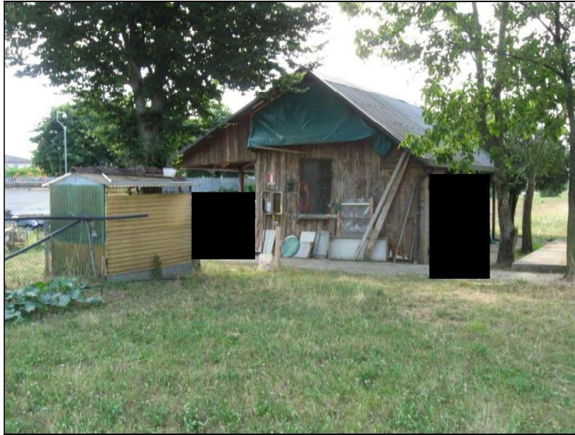
Foto vista da Nord/Ovest fabbricato su mapp. 139 - sub 6
