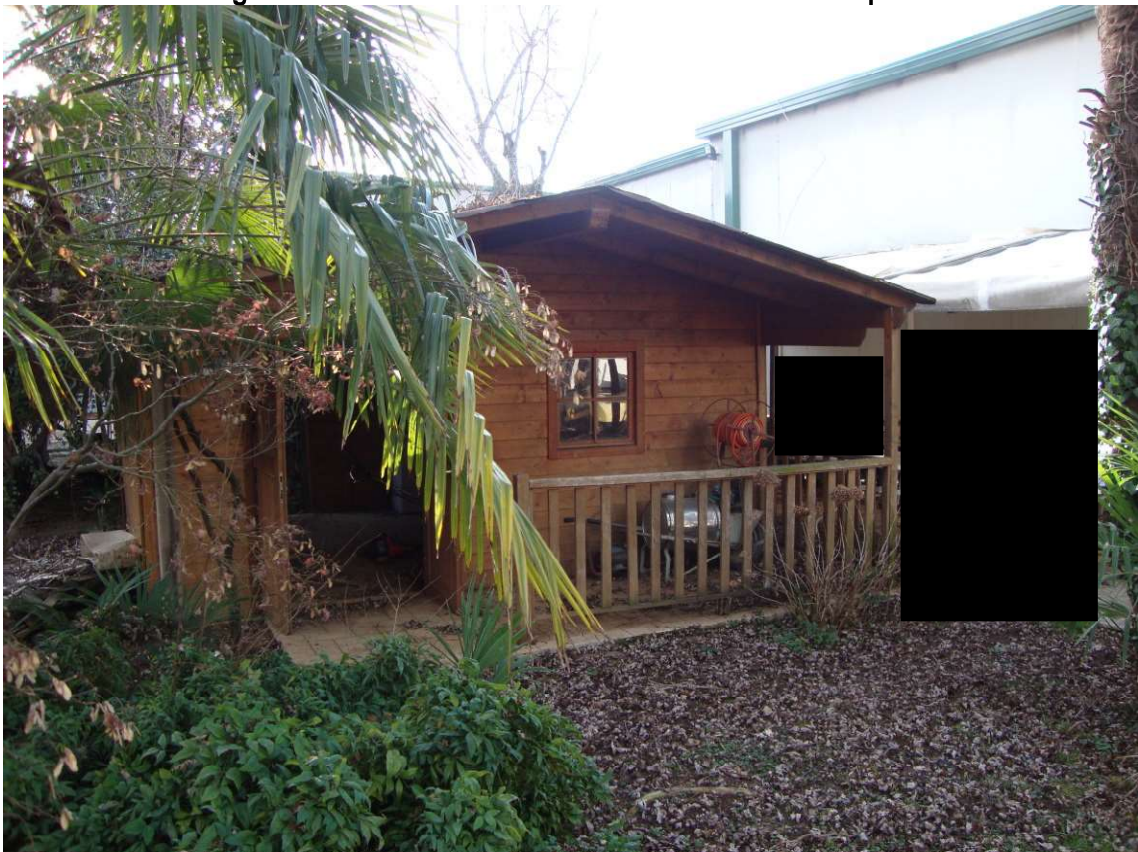
Fig. 2.30 – manufatti da rimuovere esistenti sullo scoperto
