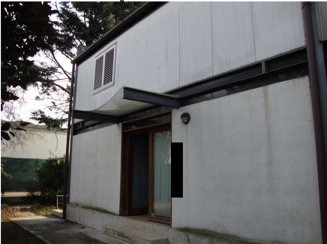
Fig. 2.28 – vista da nord
