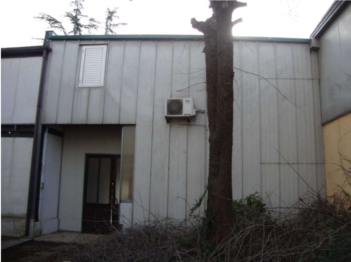
Fig. 2.27 – vista da nord
