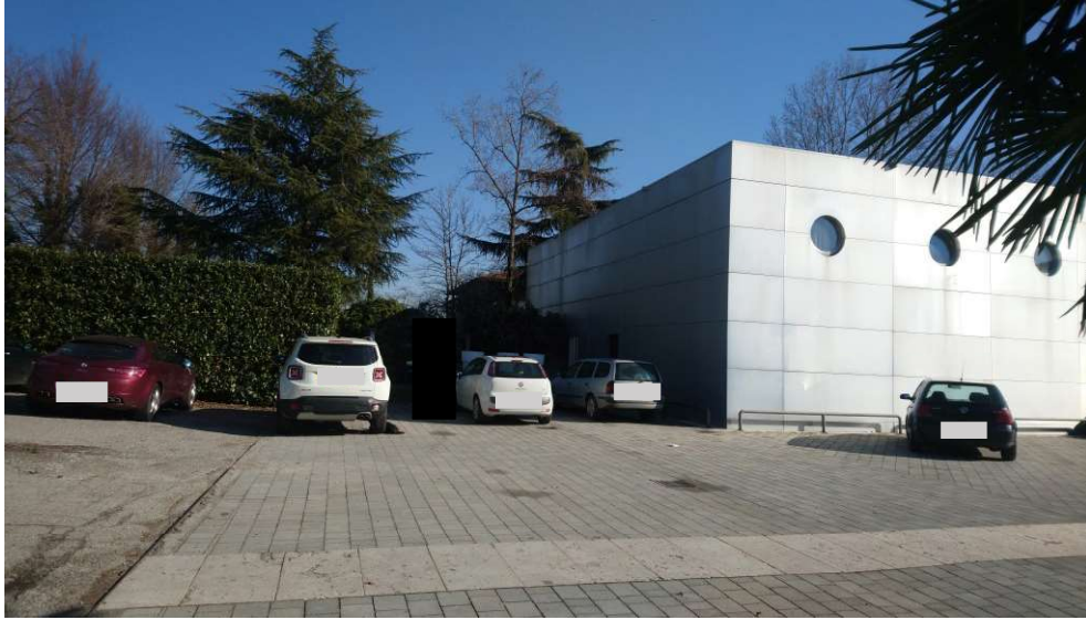
Fig. 2.21 – vista da nord
