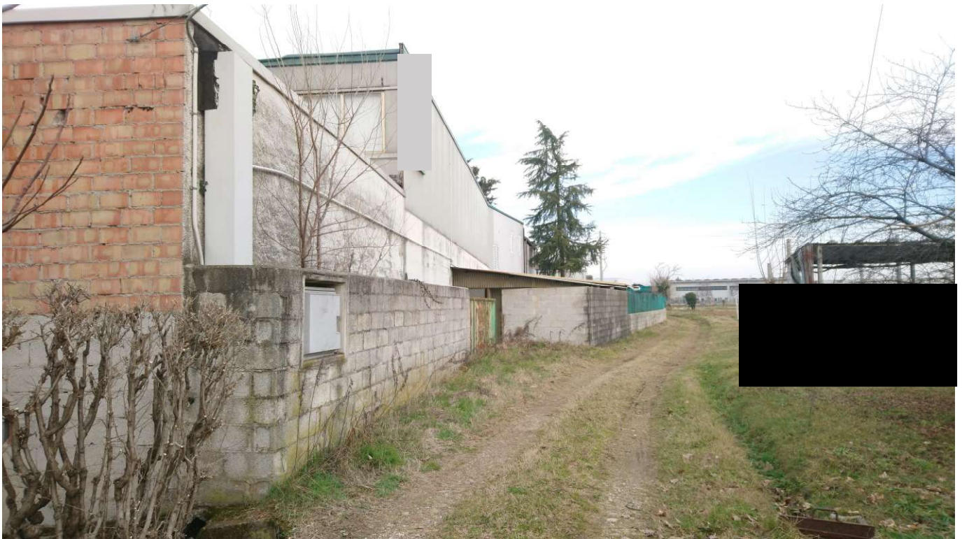
Fig. 2.19 – vista da sud-ovest dell'immobile
