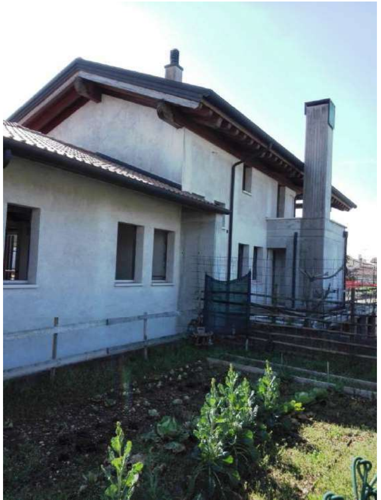
Vista lato Ovest
