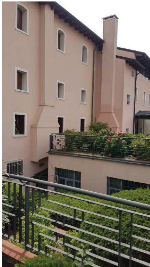
FOTO 4 : vista prospetto esterno lato nord-est
