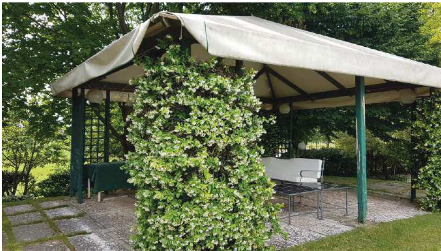
FOTO 10 : vista gazebo lato ovest
