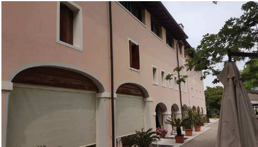
FOTO 2 : vista prospetto esterno, lato sud
