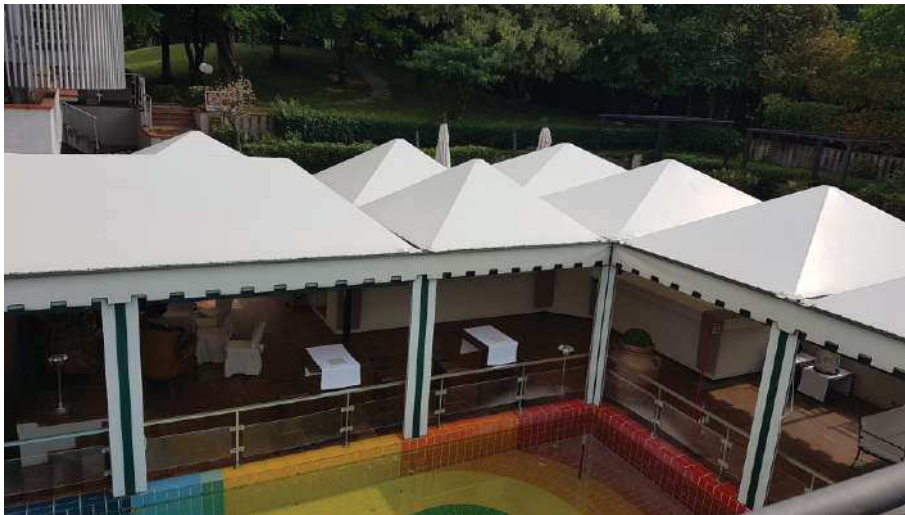
FOTO 6: vista area esterna nord-ovest
