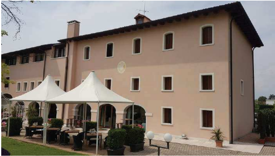
FOTO 3 : vista prospetto esterno lato sud-est
