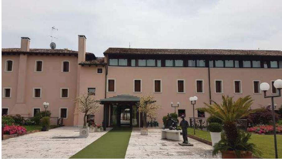
FOTO 1 : vista ingresso principale, prospetto nord
