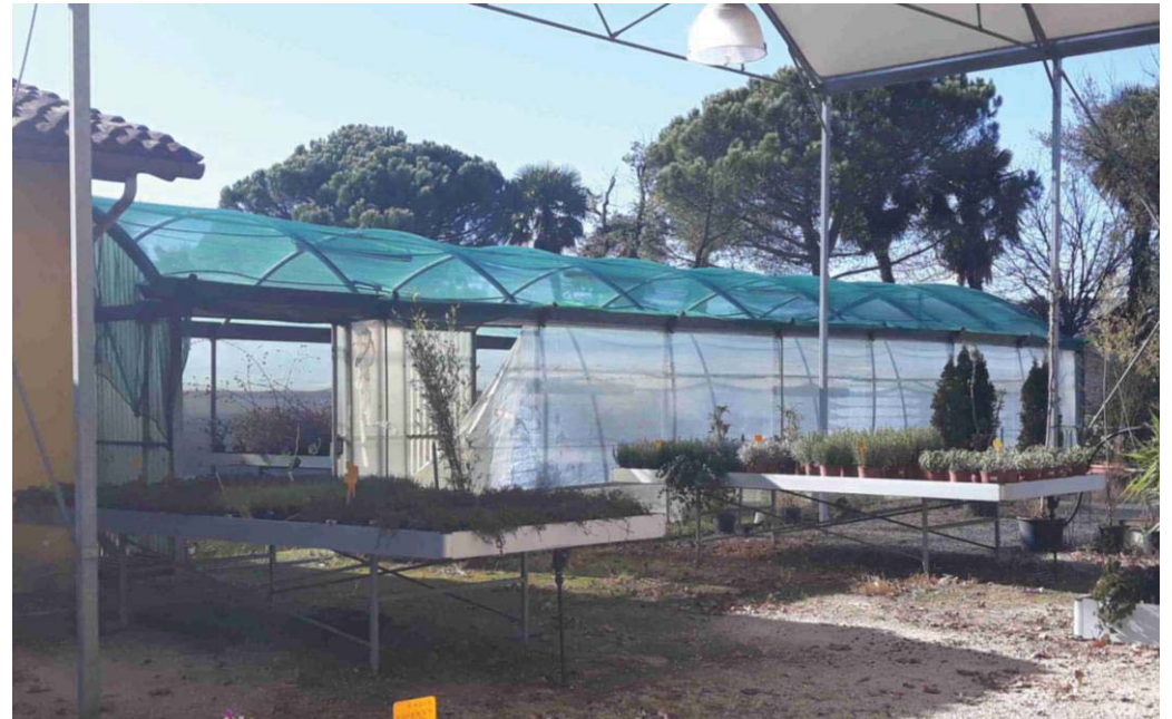
Foto n. 106: Struttura 15 serra – lato nord
