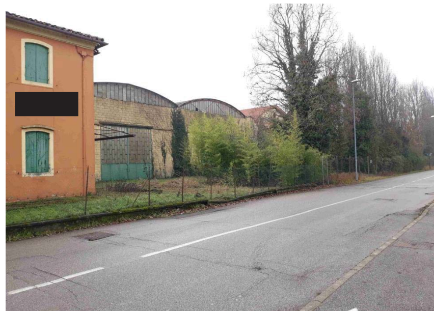
Foto n. 4: lato nord - area lungo via R. Selvatico- ed. 7 e 3
