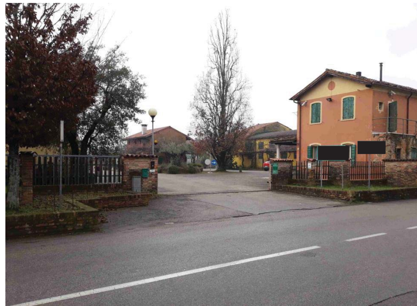
Foto n. 2: lato nord - ingresso area da via R. Selvatico, Ed. 7
