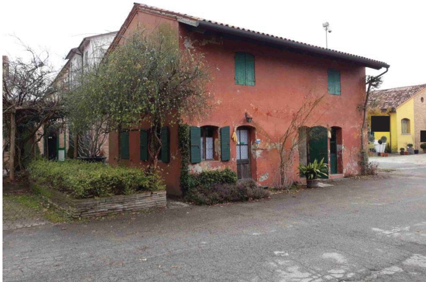
Foto n. 111: Ed. 17 – lati nord ed ovest
