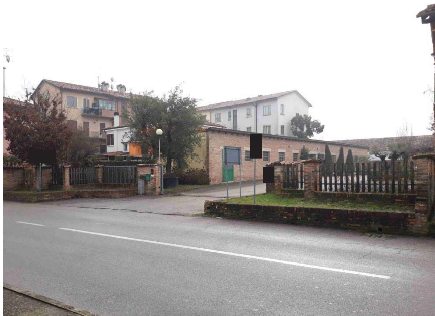
Foto n. 1: lato nord - ingresso area da via R. Selvatico – Ed. 18
