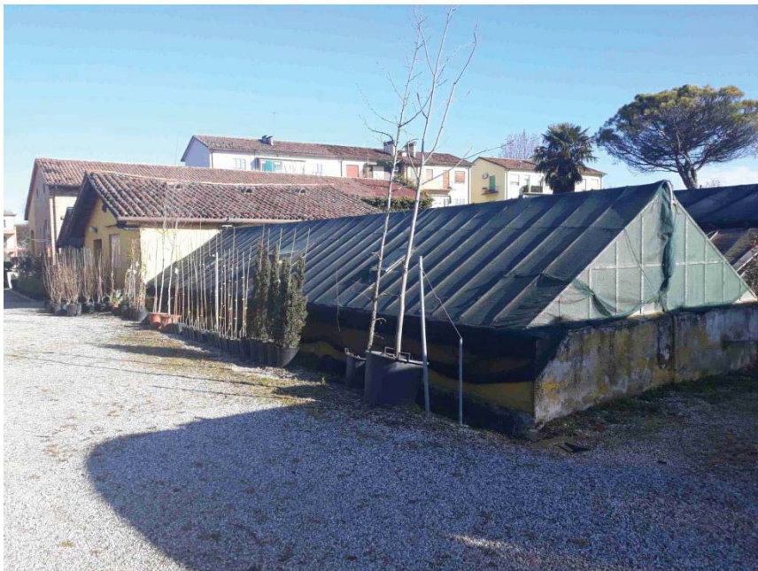
Foto n. 99: Struttura 13 serra – lato ovest
