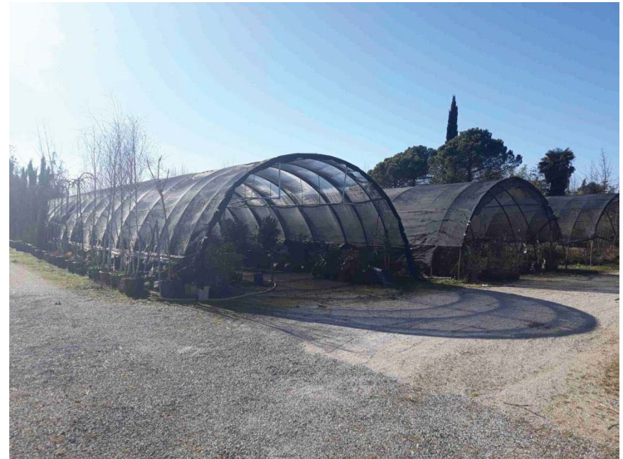
Foto n. 110: Struttura 16 serra – lati nord ed est
