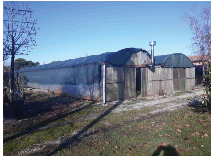
Foto n. 36: Struttura 5 serra – lati sud ed est
