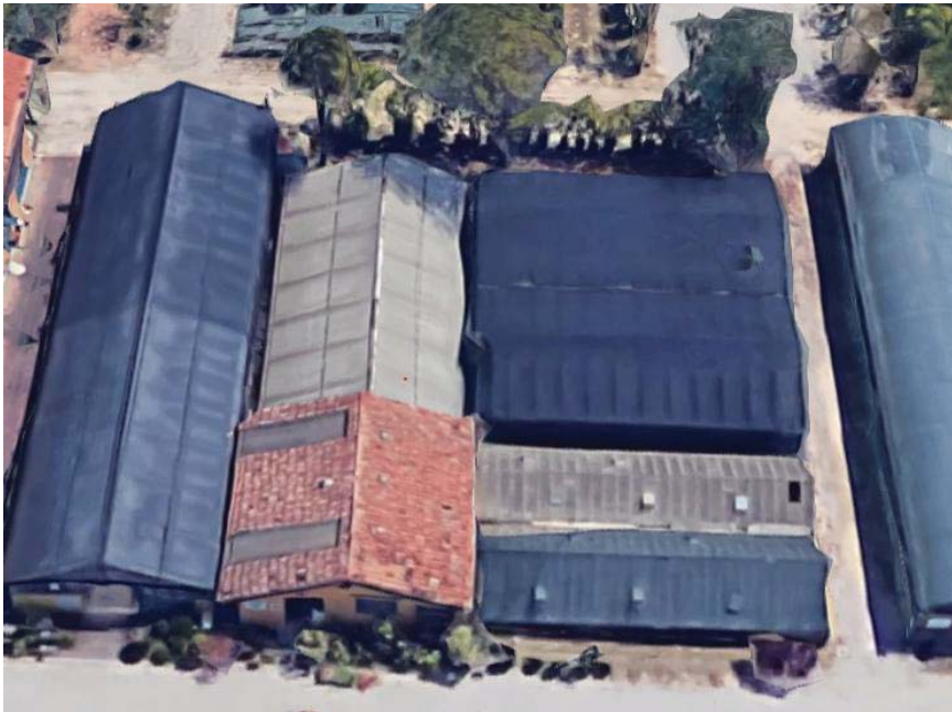
Foto n. 97: Struttura 13 serra - vista
