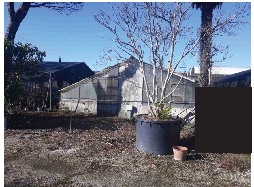
Foto n. 100: Struttura 13 serra – lato est
