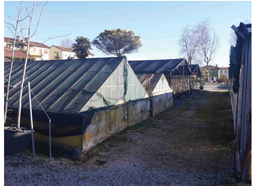
Foto n. 98: Struttura 13 serra – lato sud
