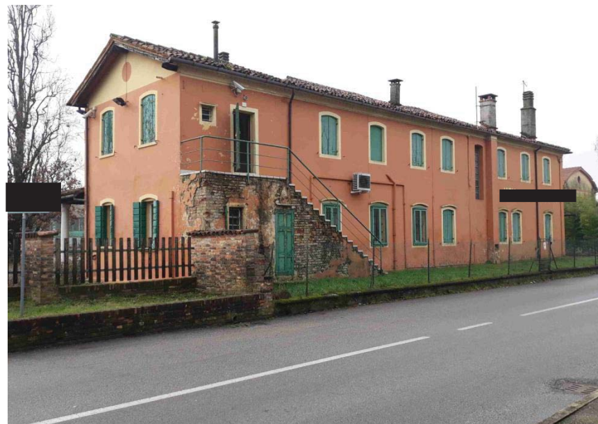
Foto n. 3: lato nord - area lungo via R. Selvatico- Ed. 7
