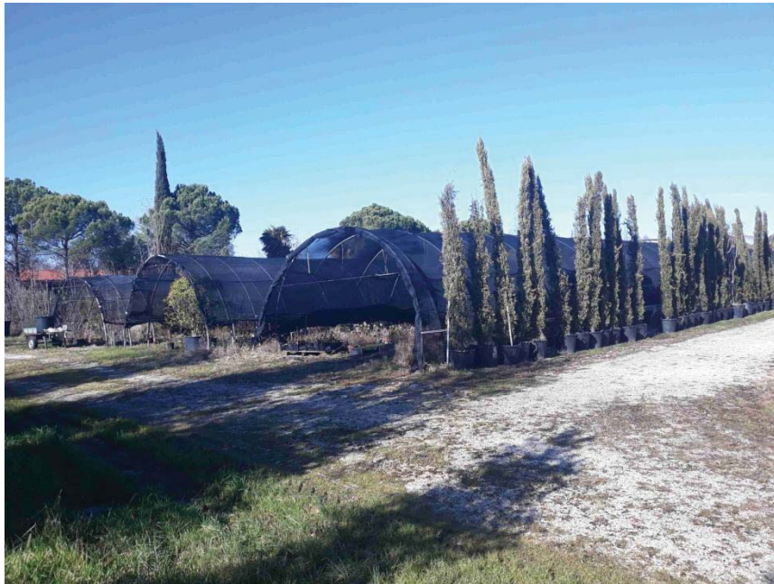
Foto n. 109: Struttura 16 serra – lati sud ed est
