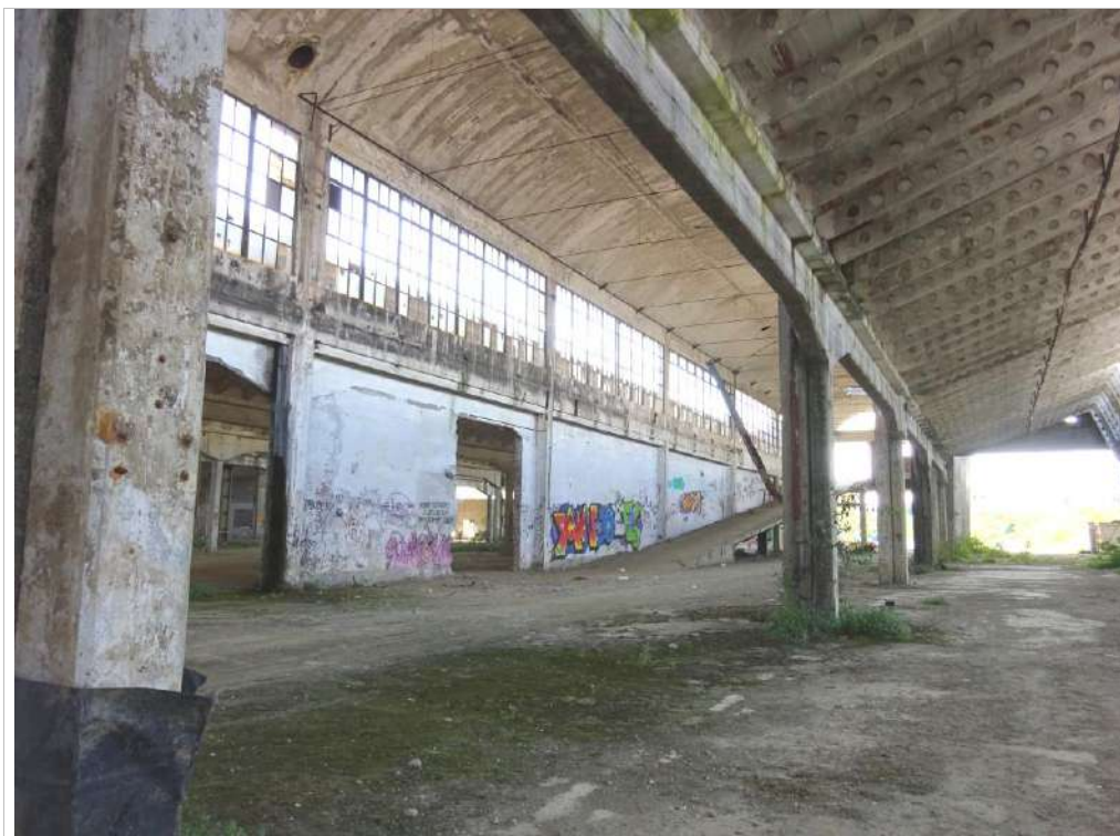
11 Interno fabbricati 4 e 6
