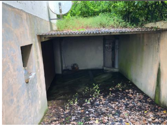
Vista esterna edificio – rampa di accesso al piano interrato
