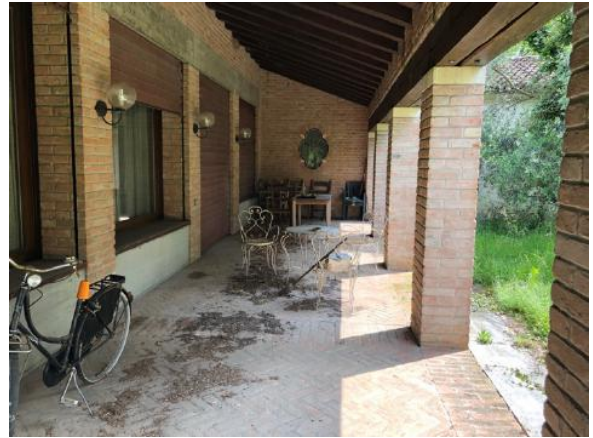
Vista esterna edificio – Portico sud unità destra
