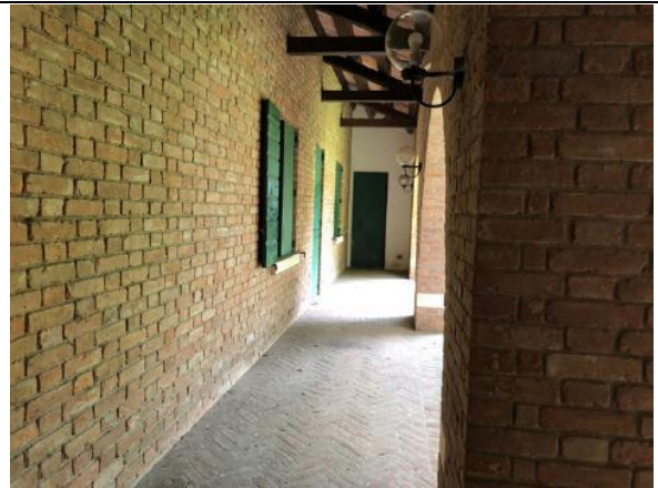
Vista esterna edificio – Portico esterno unità sinistra
