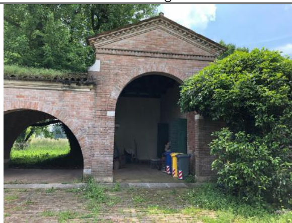
Vista esterna – Prospetto Nord
