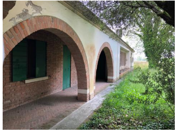
Vista esterna edificio – Prospetto Est unità sinistra
