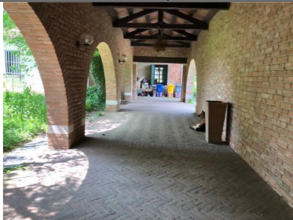
Vista esterna edificio – Portico di collegamento tra le due unità
