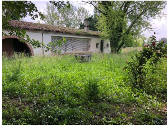
Vista esterna edificio – Prospetto Est unità sinistra
