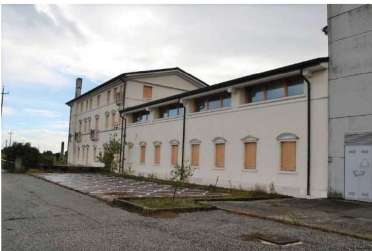
foto n. 71 – m.n. 744: area scoperta a nord dell'opificio
