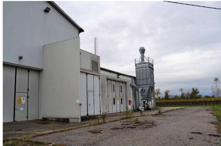
foto n. 70 – m.n. 744: area scoperta a nord dell'opificio
