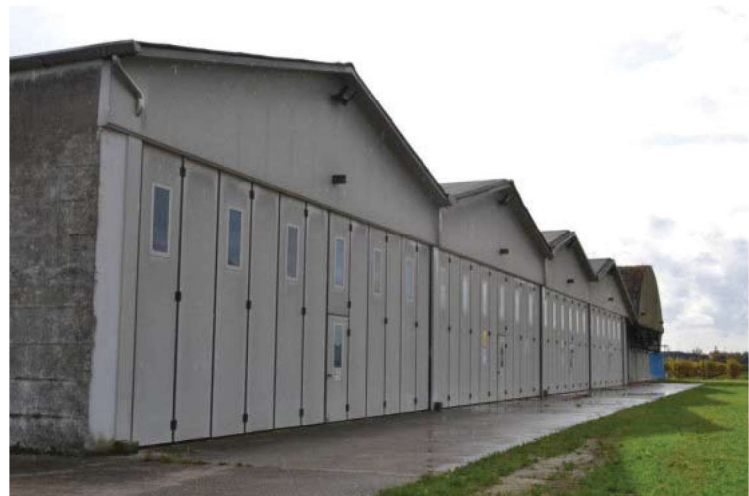
foto n. 6 – prospetto ovest opificio
