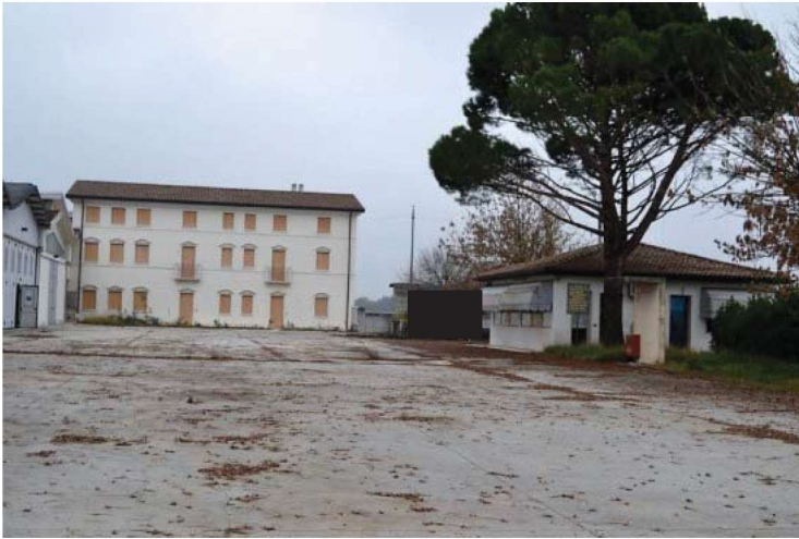
foto n. 67 – area scoperta m.n. 740 sub. 2 a sud
