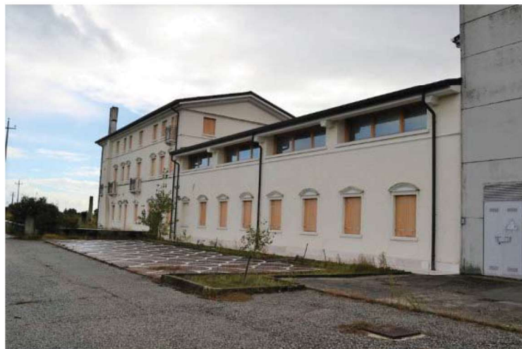
foto n. 8 – prospetto nord zona "A" e palazzina uffici
