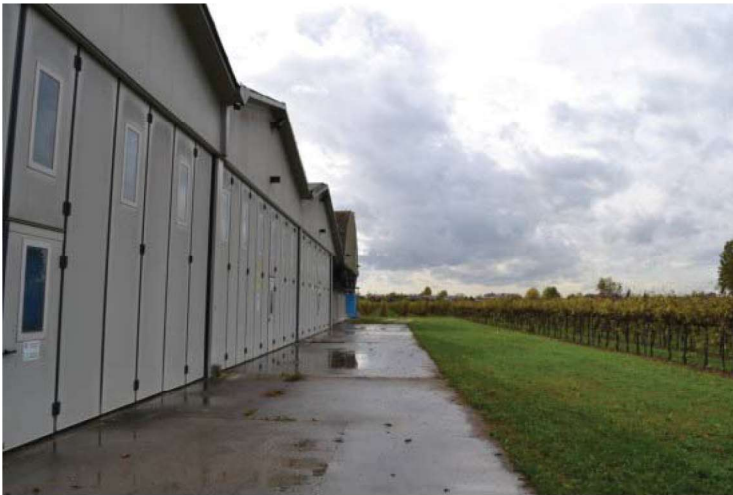
foto n. 69 – m.n. 744: area scoperta pavimentata ad ovest dell'opificio
