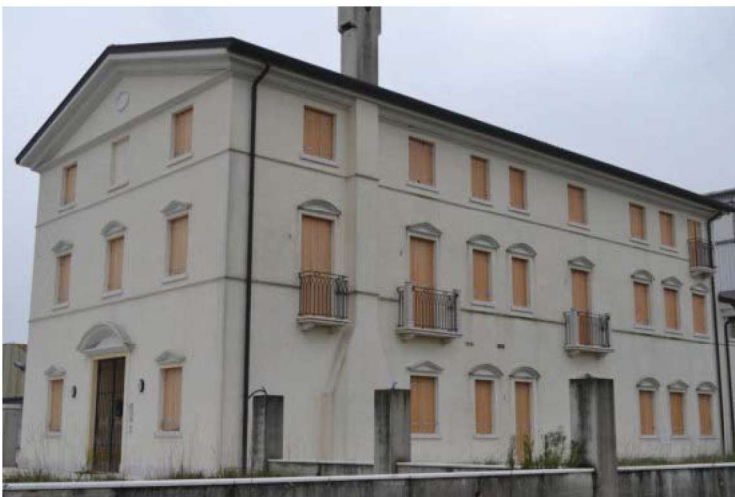
foto n. 41 – palazzina uffici: prospetto nord
