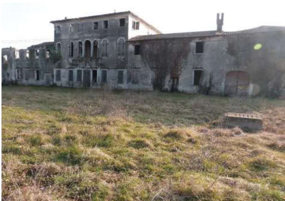
8 Vista del prospetto nord della villa con barchesse
