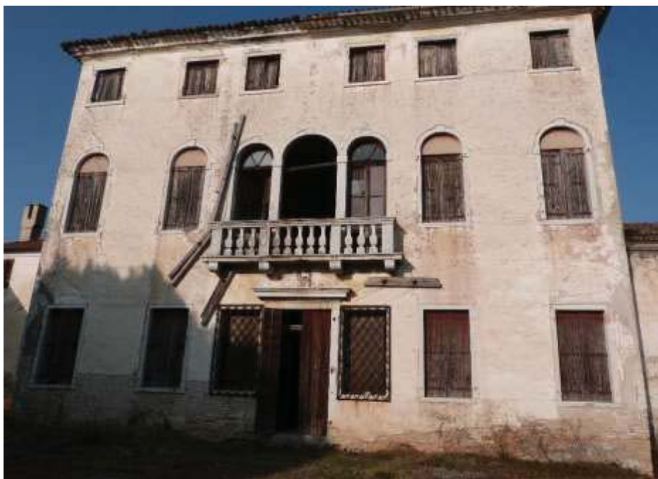
1 Vista del fronte principale della villa (prospetto sud).
