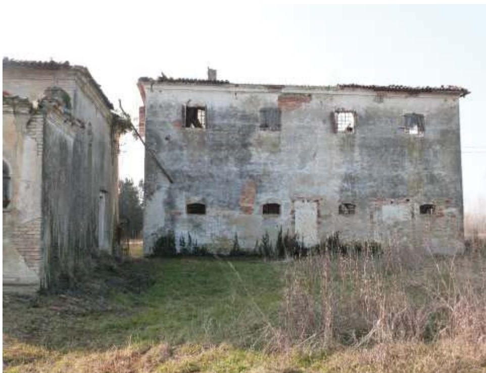
7 Vista del prospetto est della barchessa
