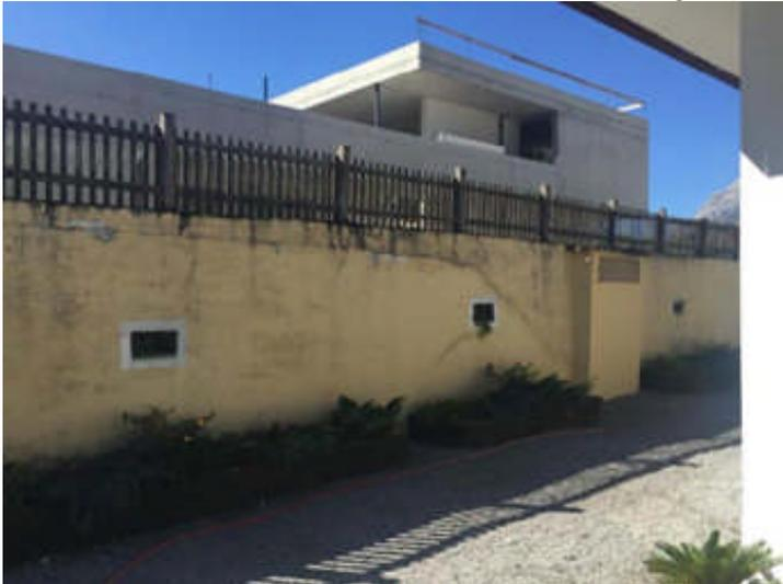
Muro di cinta del terreno in evidente stato di deterioramento lungo il confine sud
