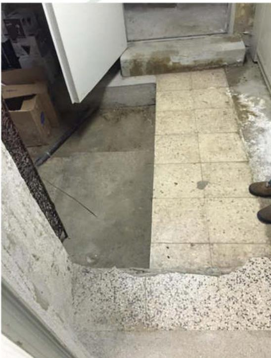
Gradini danneggiati nel locale caldaia
