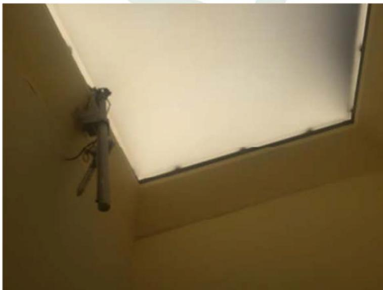
Cappa di estrazione dei fumi d'incendio nella tromba delle scale non conforme al regolamento edilizio del Tirolo
