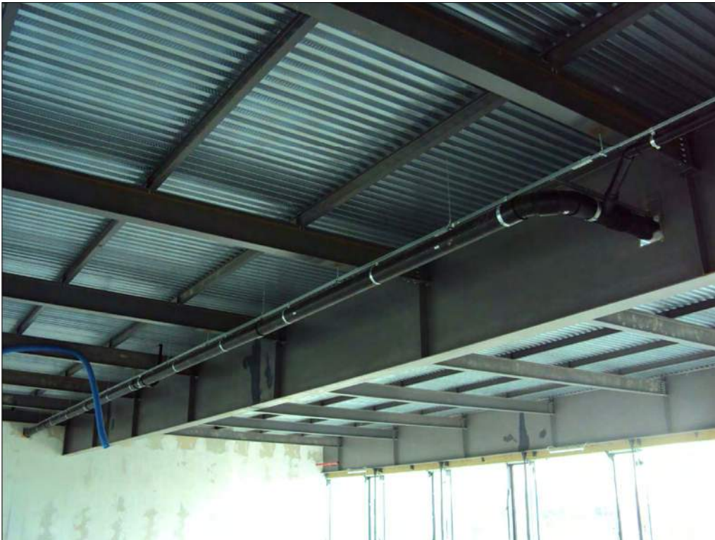
Foto n. 77: Locale ad uso industriale-artigianale al primo piano lato ovest, da completare
