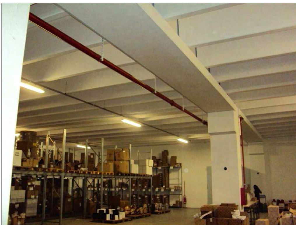
Foto n. 60: Locali ad uso industriale-artigianale al primo piano sottostrada
