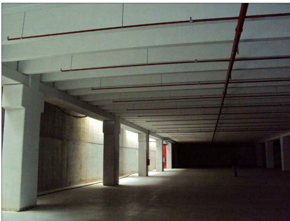
Foto n. 39: Parcheggi pertinenziali al secondo piano sottostrada
