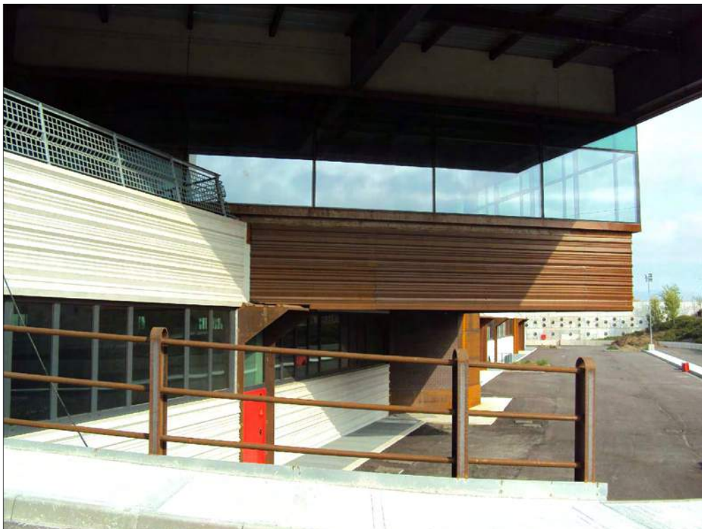
Foto n. 140: prospetto est primo piano sottostrada
