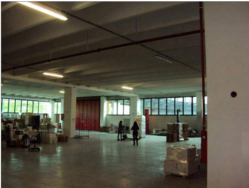
Foto n. 62: Locali ad uso industriale-artigianale al primo piano sottostrada
