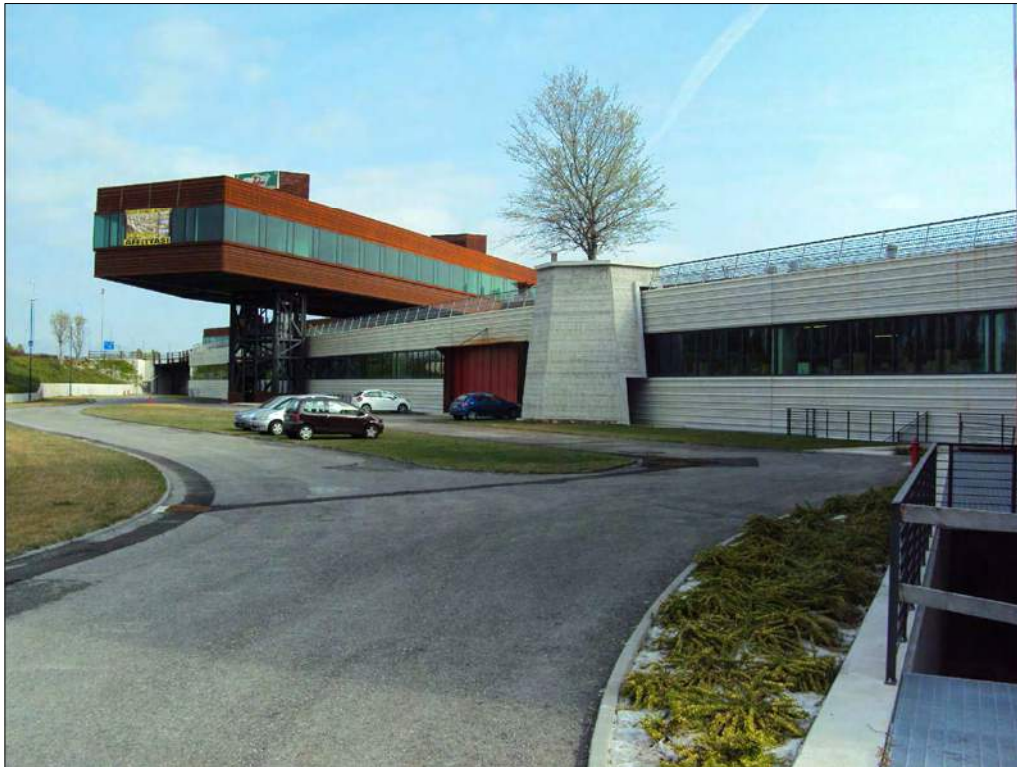
Foto n. 27: Prospetto ovest al primo piano sottostrada
