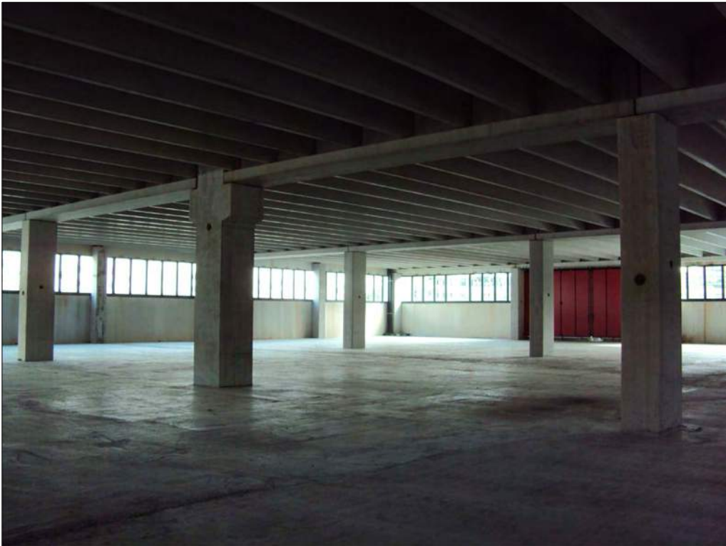
Foto n. 152: Interno primo piano sottostrada
