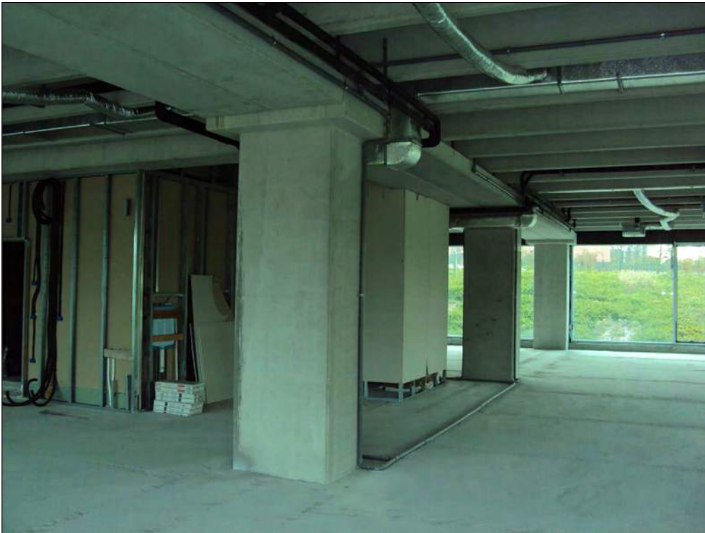
Foto n. 107: Interno primo piano sottostrada, da completare
