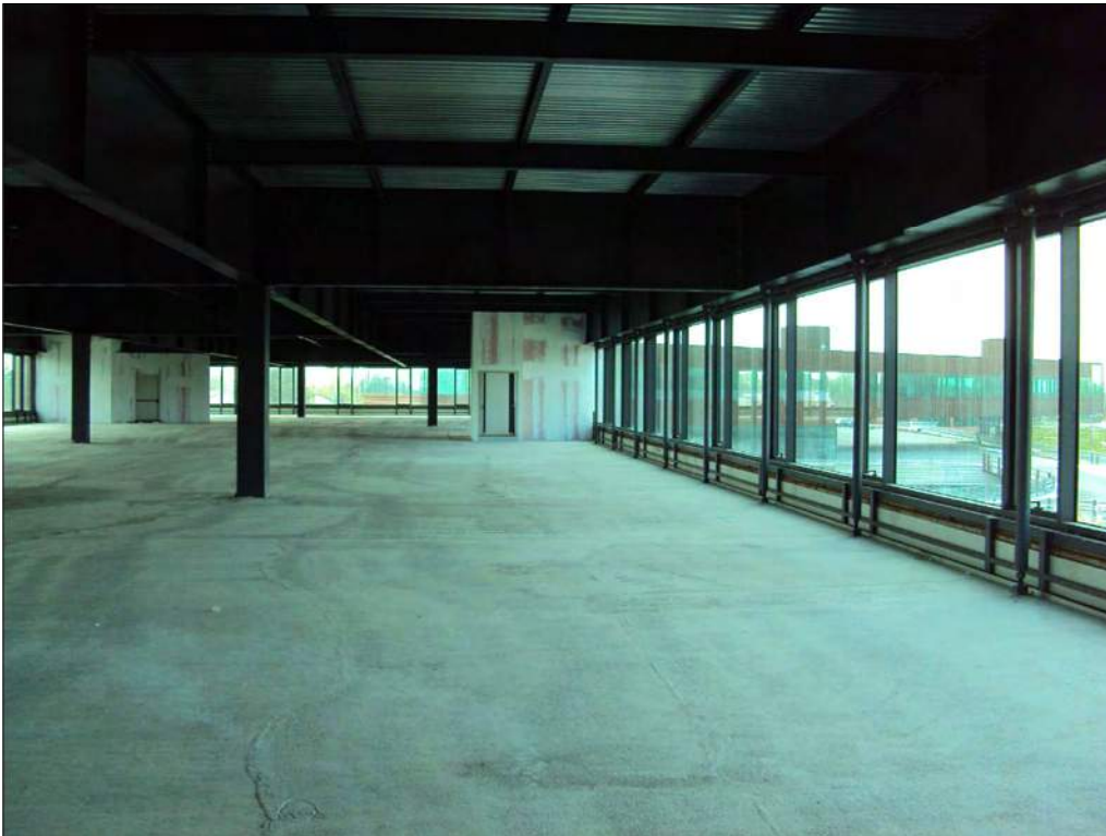
Foto n. 163: Interno primo piano, da completare
