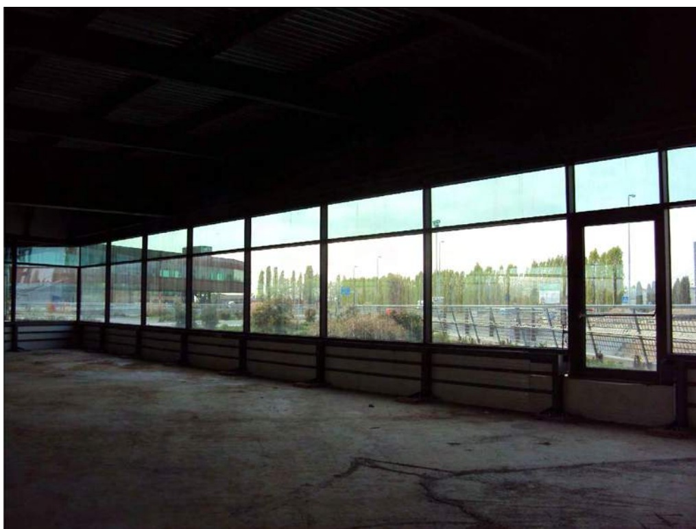
Foto n. 159: Interno locale ad uso commerciale al piano terra, da completare
