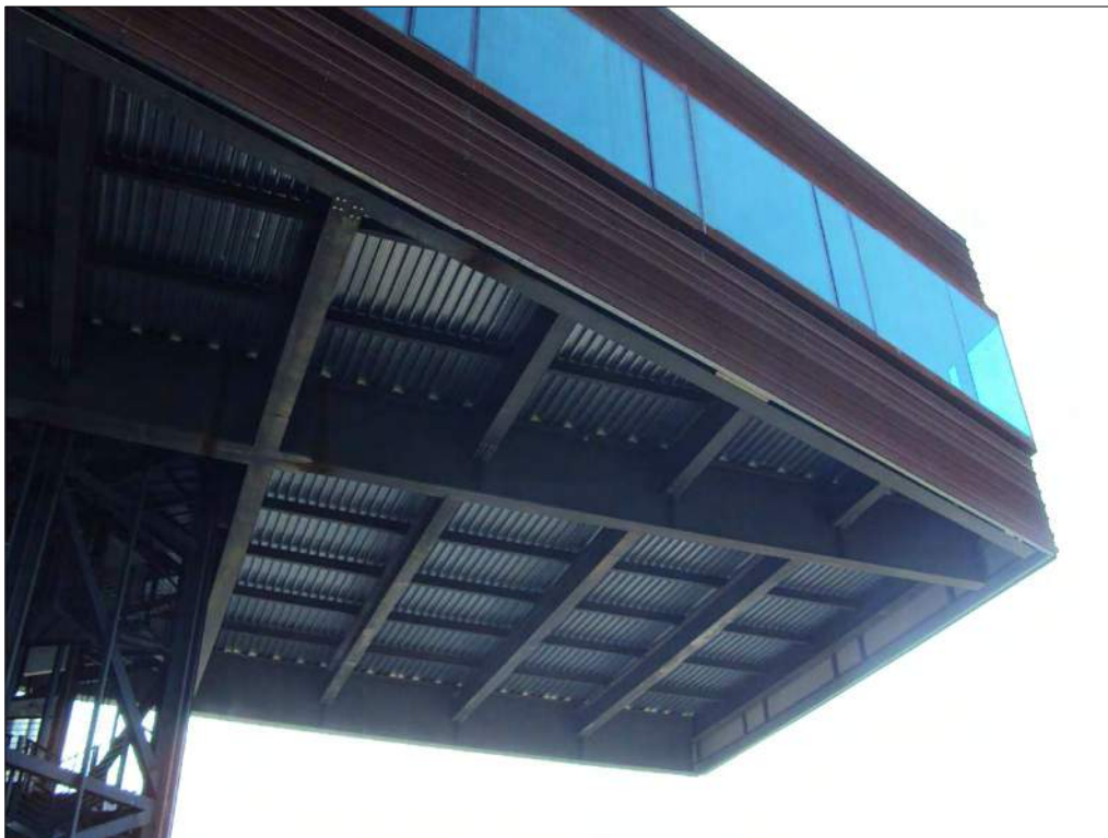
Foto n. 25: Il volume aggettante
