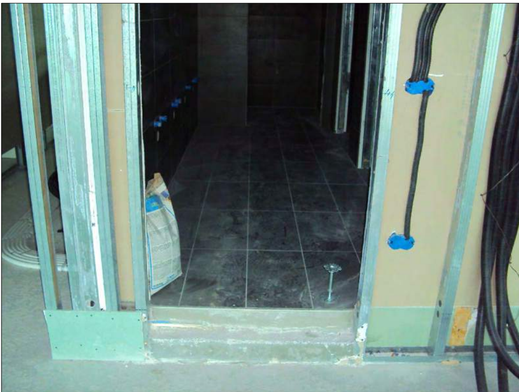
Foto n. 106: Interno primo piano sottostrada, da completare
