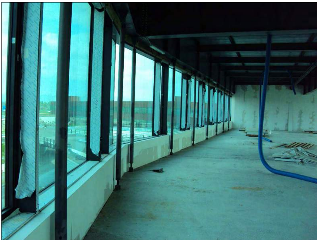
Foto n. 75: Locale ad uso industriale-artigianale al primo piano lato ovest, da completare
