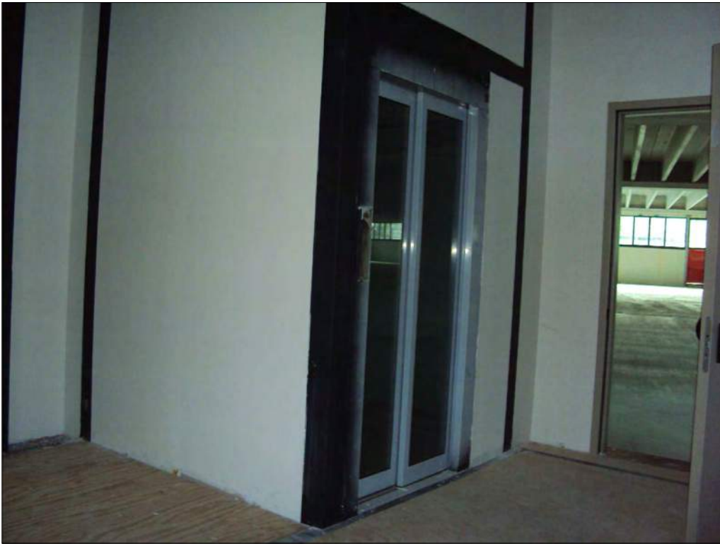
Foto n. 151: Vano scale e ascensore al primo piano sottostrada
