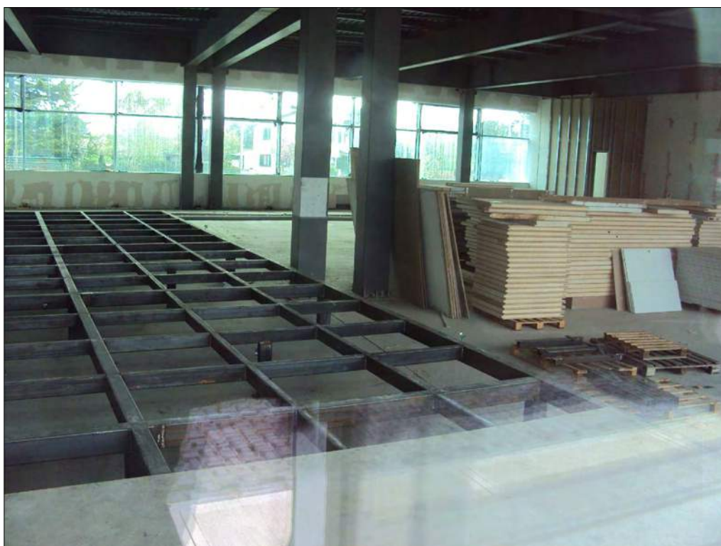
Foto n. 71: Locali ad uso industriale-artigianale al piano terra, da completare
