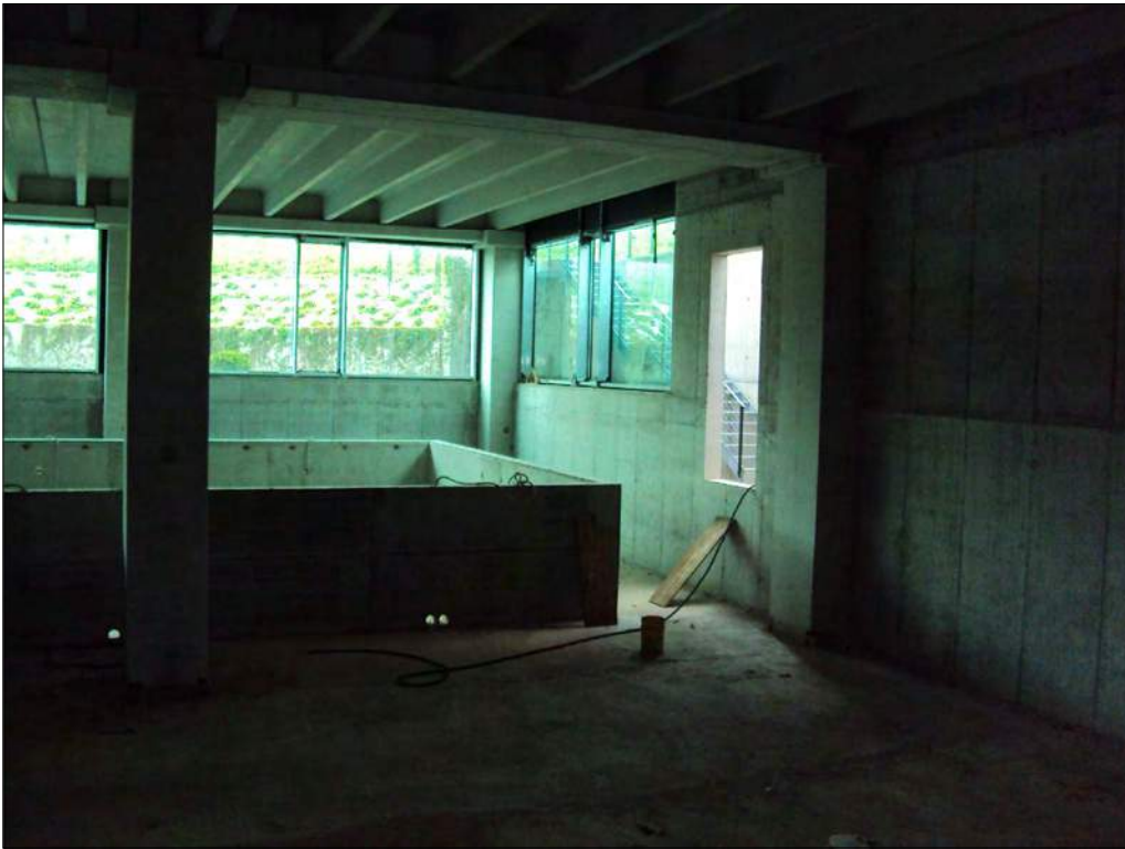
Foto n. 99: Interno secondo piano sottostrada, al grezzo
