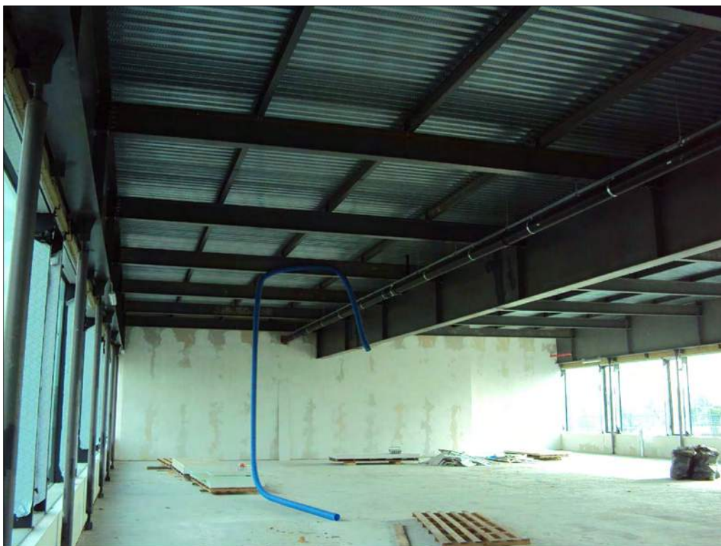
Foto n. 76: Locale ad uso industriale-artigianale al primo piano lato ovest, da completare
