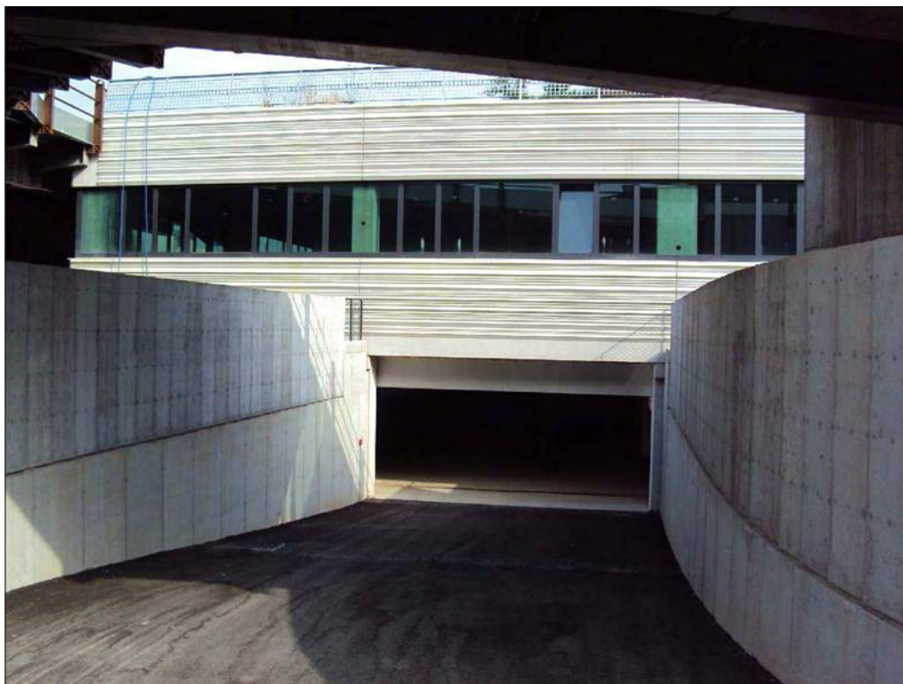
Foto n. 143: Rampa di accesso al secondo piano sottostrada
