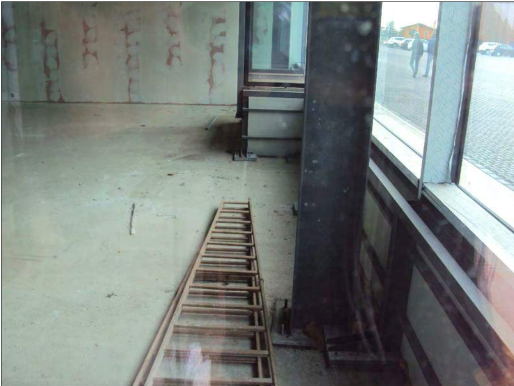
Foto n. 68: Locali ad uso industriale-artigianale al piano terra, da completare
