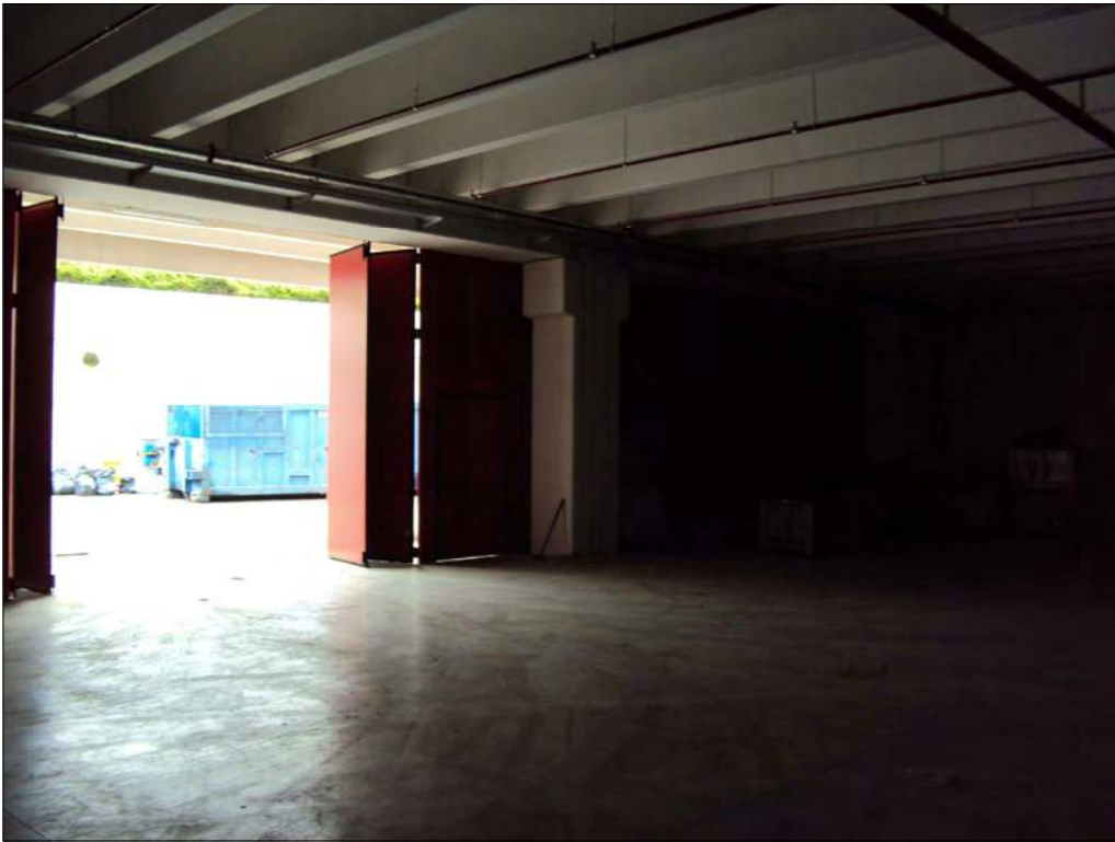
Foto n. 33: Parcheggi pertinenziali al secondo piano sottostrada
