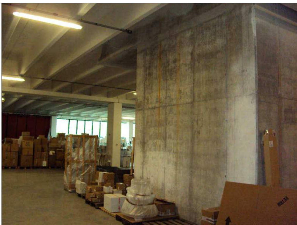
Foto n. 59: Locali ad uso industriale-artigianale al primo piano sottostrada
