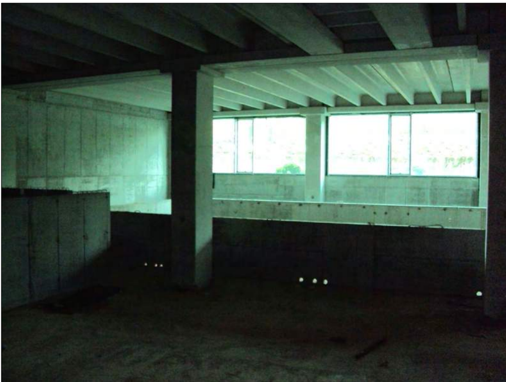
Foto n. 100: Interno secondo piano sottostrada, al grezzo
