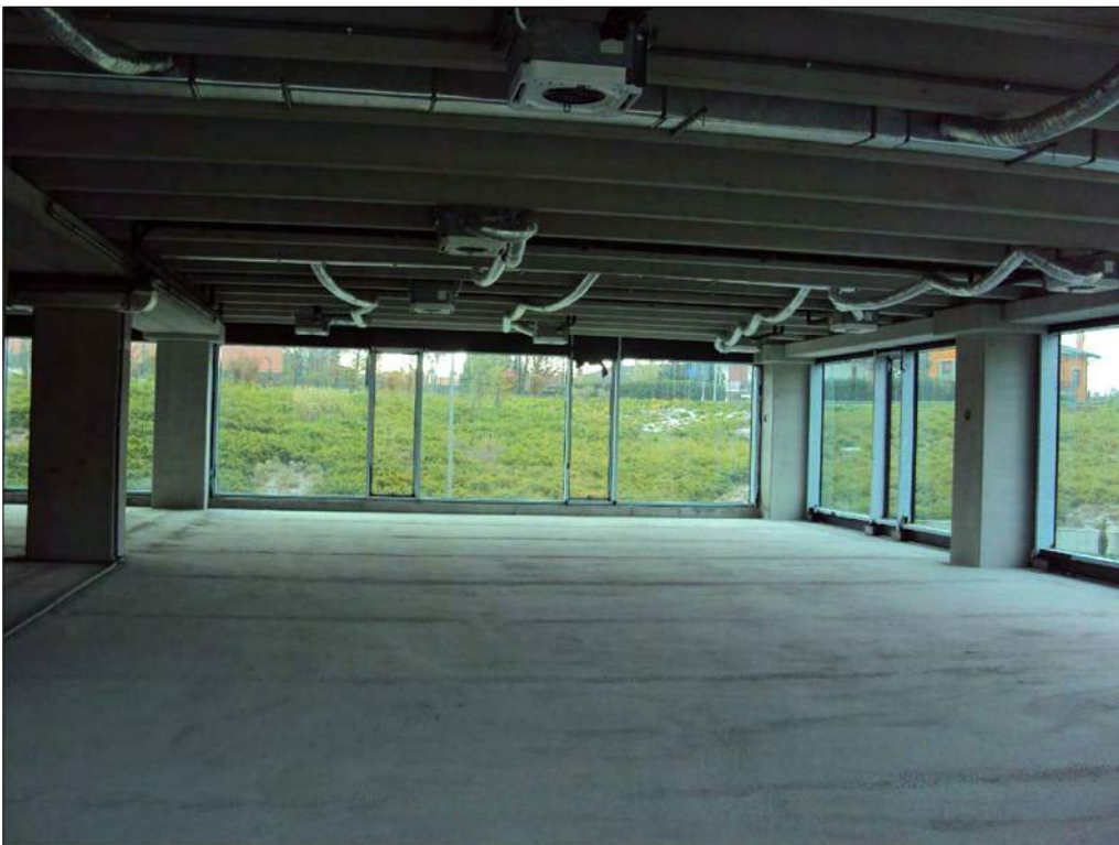
Foto n. 108: Interno primo piano sottostrada, da completare
