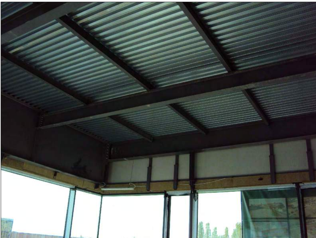
Foto n. 74: Locale ad uso industriale-artigianale al primo piano lato ovest, da completare
