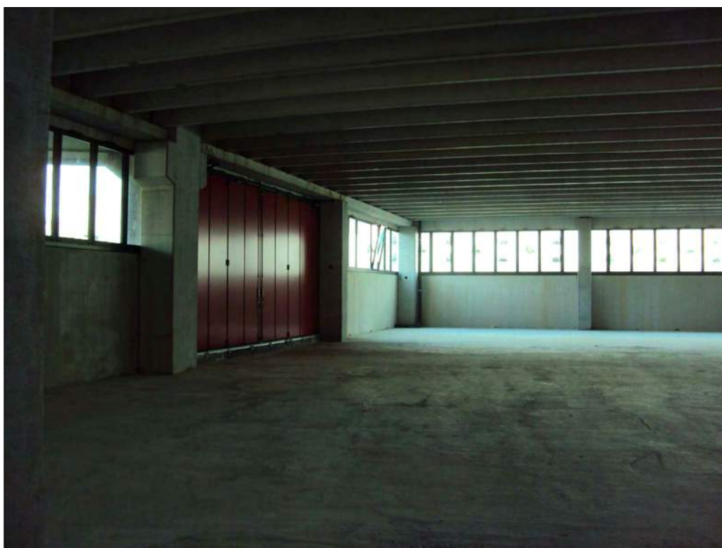
Foto n. 155: Interno primo piano sottostrada
