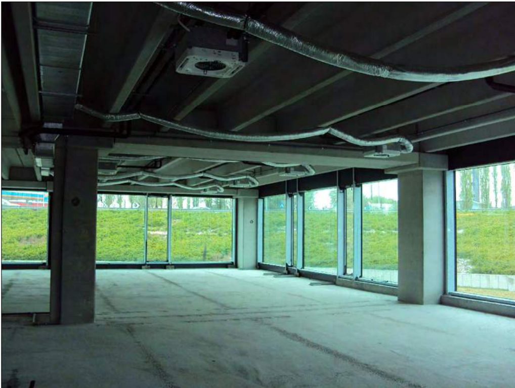
Foto n. 103: Interno primo piano sottostrada, da completare
