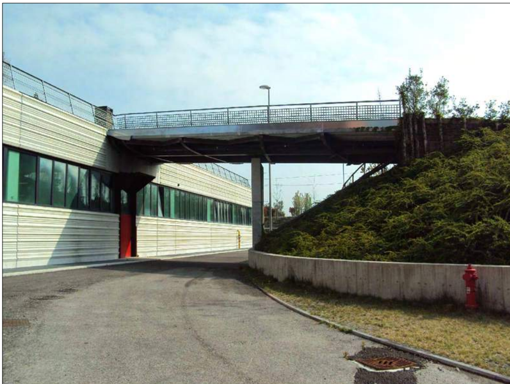
Foto n. 12: Prospetto sud al primo piano sottostrada
