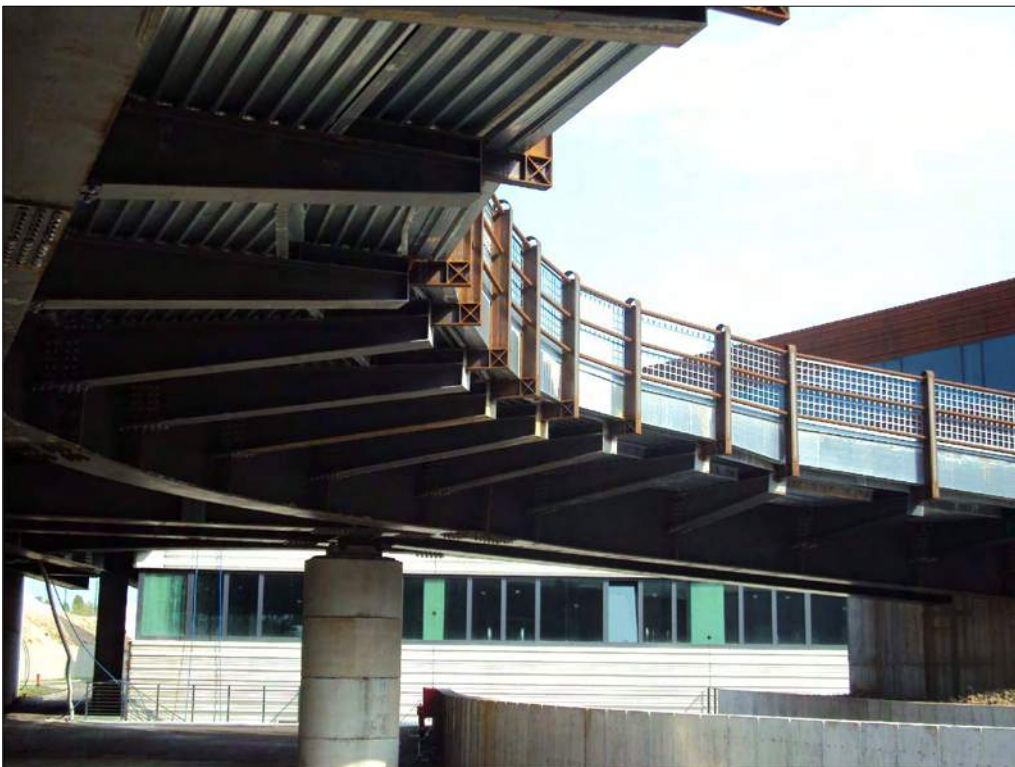
Foto n. 22: Il ponte vista dal primo piano sottostrada
