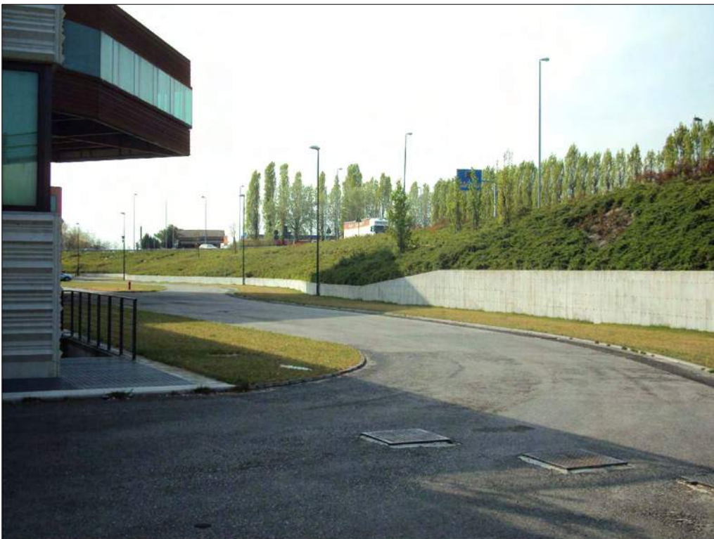
Foto n. 24: Piazzale lato ovest al primo piano sottostrada
