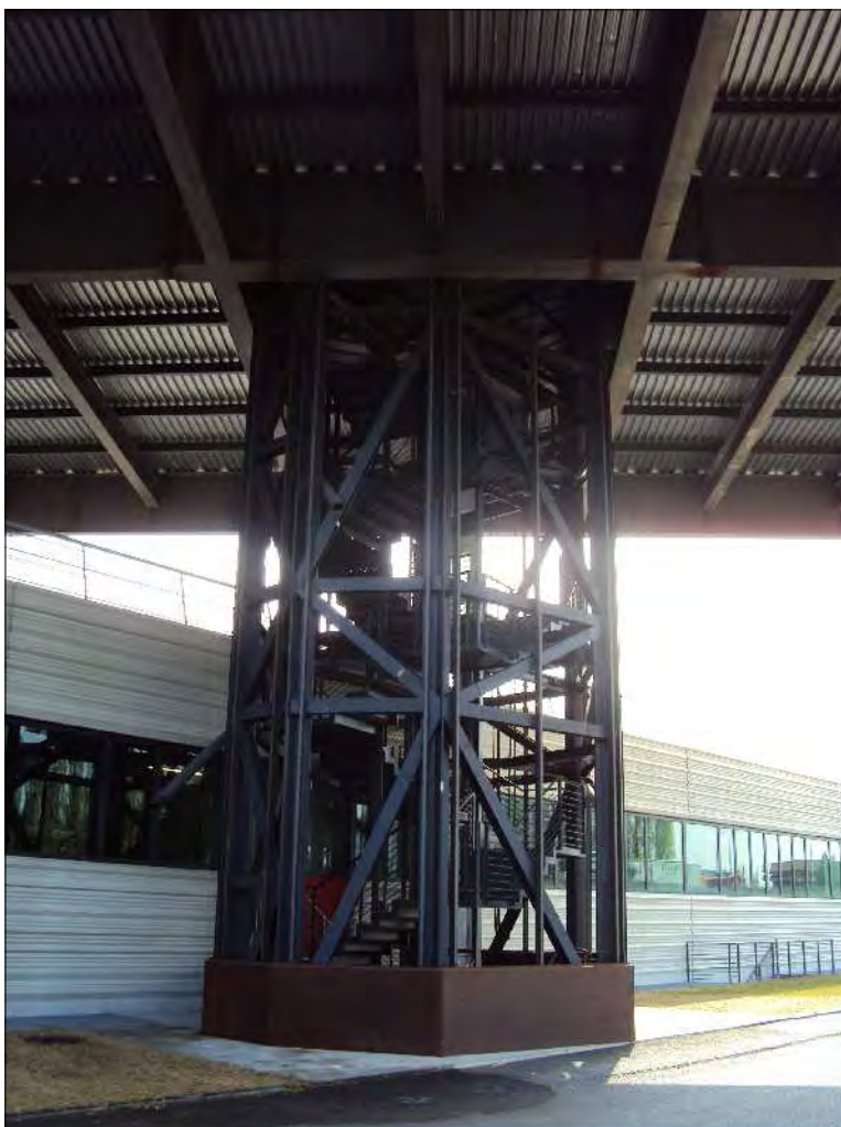
Foto n. 26: La torre di acciaio che sorregge il corpo di fabbrica più alto
