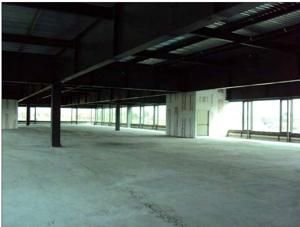
Foto n. 165: Interno primo piano, da completare
