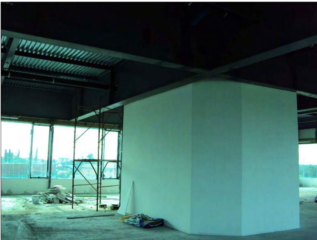
Foto n. 78: Locale ad uso industriale-artigianale al primo piano lato est, da completare
