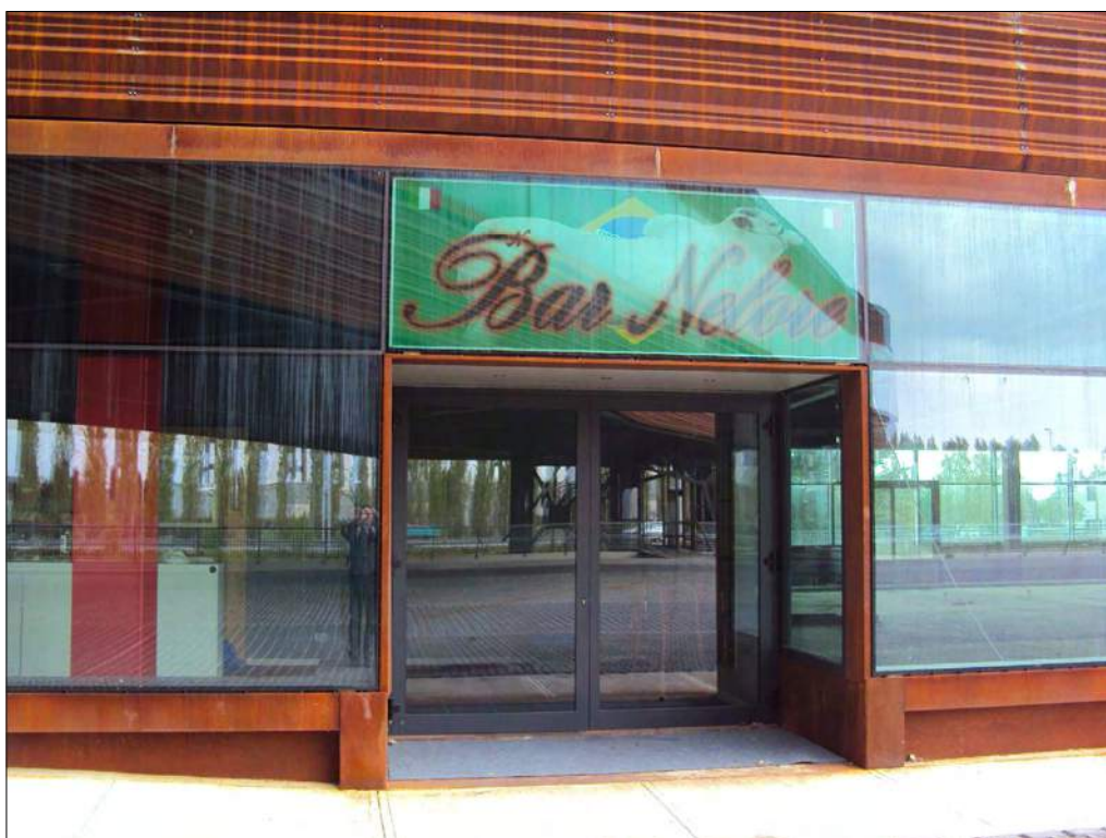
Foto n. 65: Ingresso dal piazzale ovest, del locale ad uso commerciale (bar)
