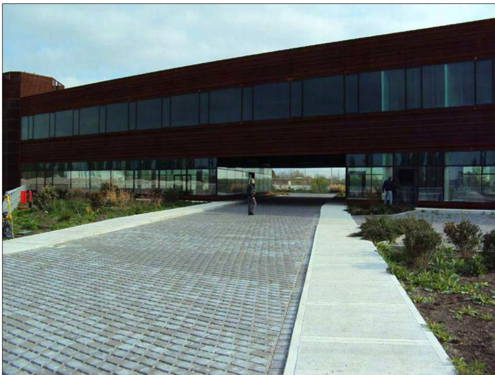
Foto n. 129: Prospetto ovest, viale di ingresso al piano terra
