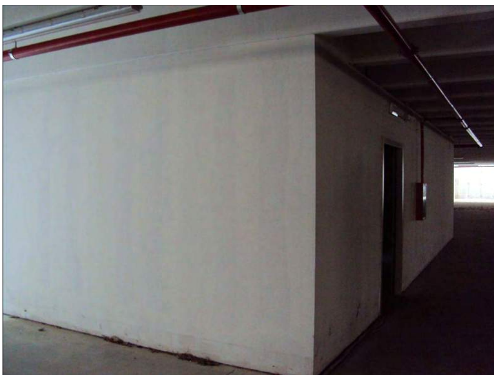
Foto n. 149: Vano scale e ascensore
