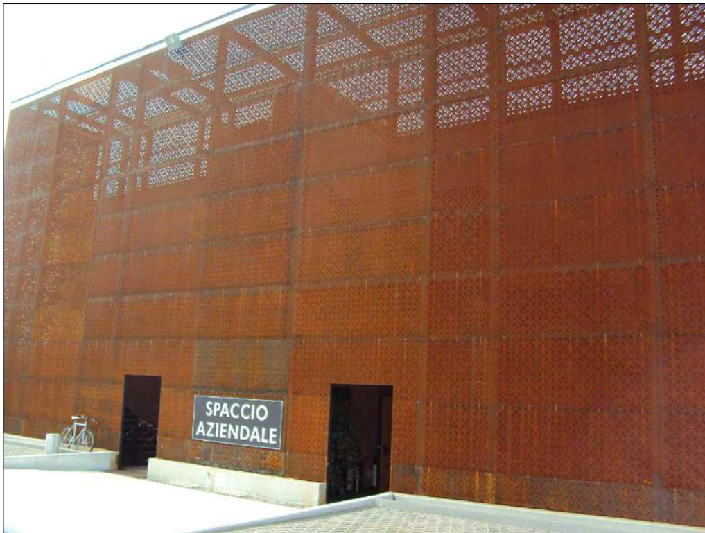
Foto n. 93: Ingresso principale prospetto nord-est
