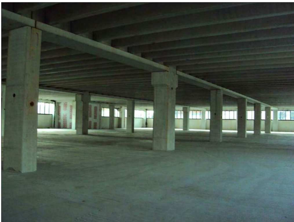
Foto n. 154: Interno primo piano sottostrada
