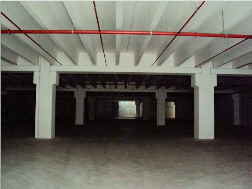
Foto n. 34: Parcheggi pertinenziali al secondo piano sottostrada
