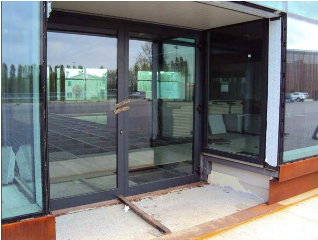
Foto n. 69: Uno degli ingressi dei locali ad uso industriale-artigianale al piano terra
