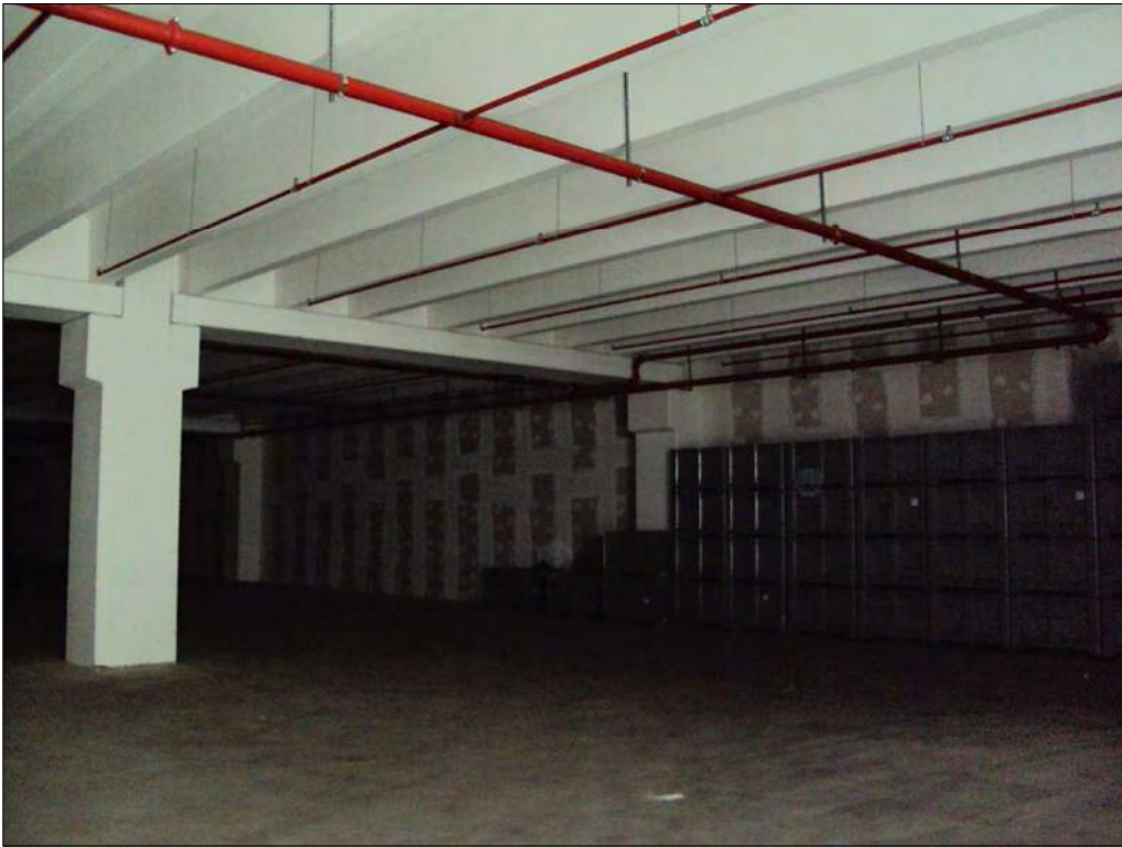
Foto n. 35: Parcheggi pertinenziali al secondo piano sottostrada
