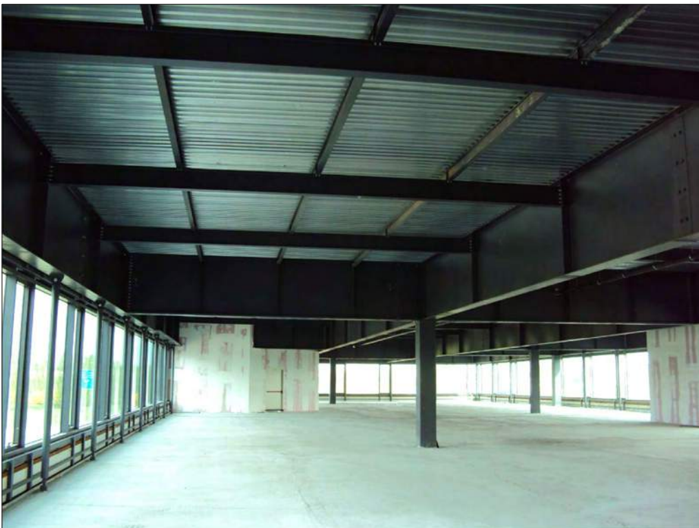
Foto n. 164: Interno primo piano, da completare
