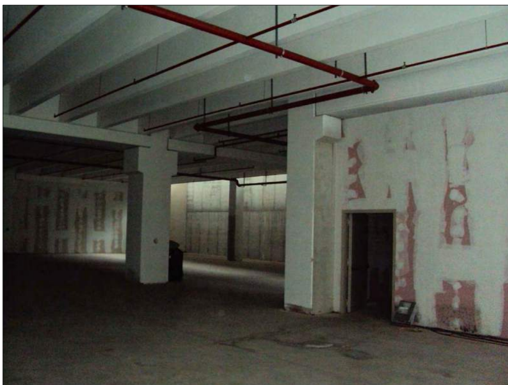
Foto n. 40: Parcheggi pertinenziali al secondo piano sottostrada
