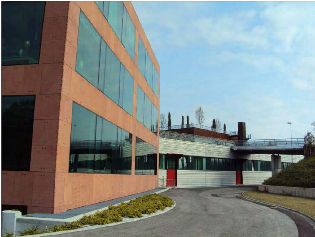
Foto n. 11: Prospetto sud al primo piano sottostrada
