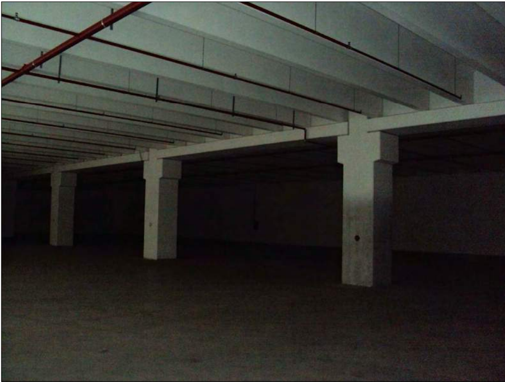
Foto n. 41: Parcheggi pertinenziali al secondo piano sottostrada
