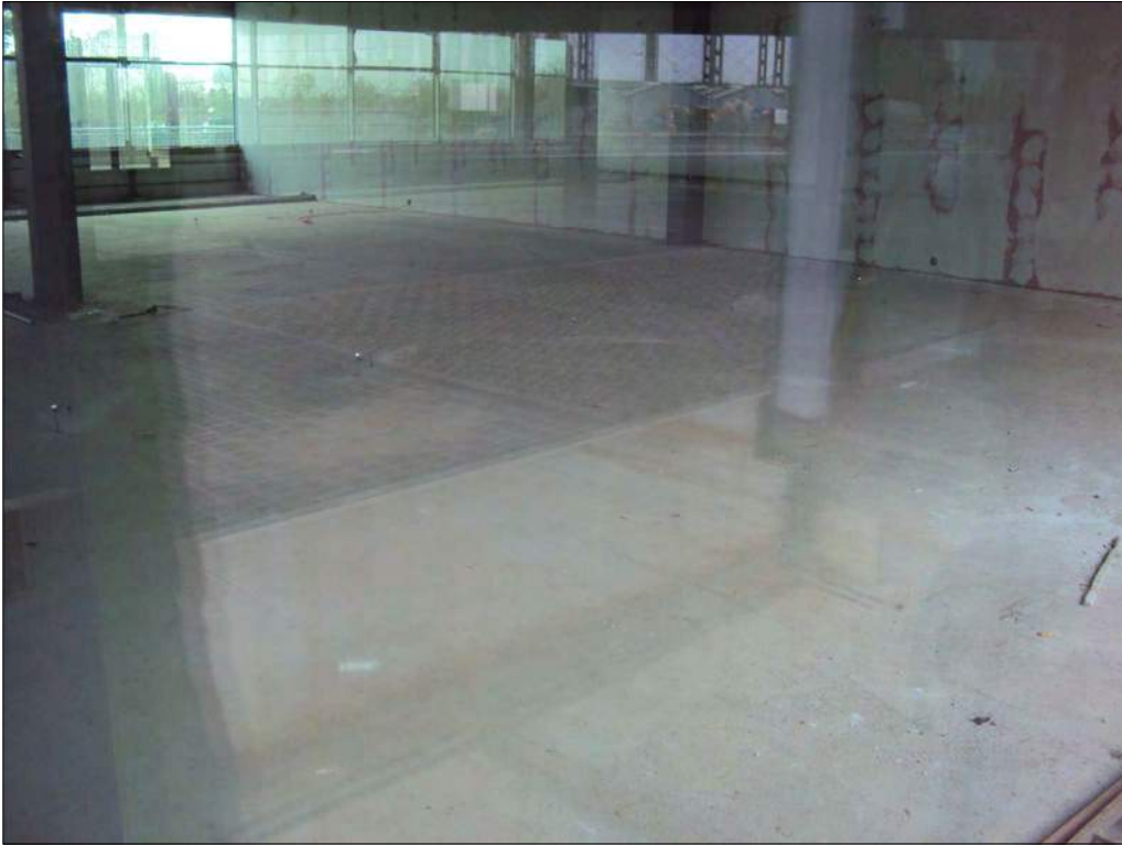
Foto n. 67: Locali ad uso industriale-artigianale al piano terra, da completare
