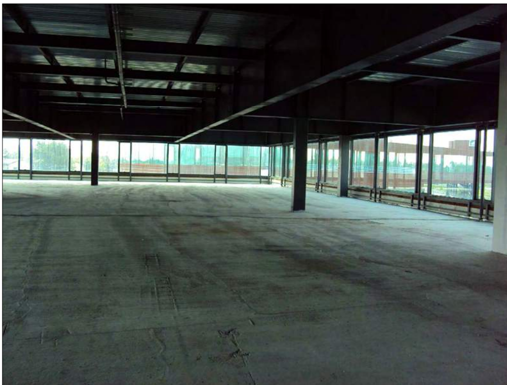
Foto n. 167: Interno primo piano, da completare
