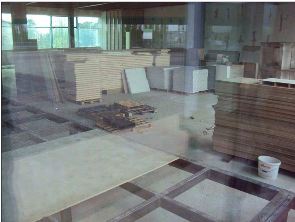
Foto n. 70: Locali ad uso industriale-artigianale al piano terra, da completare
