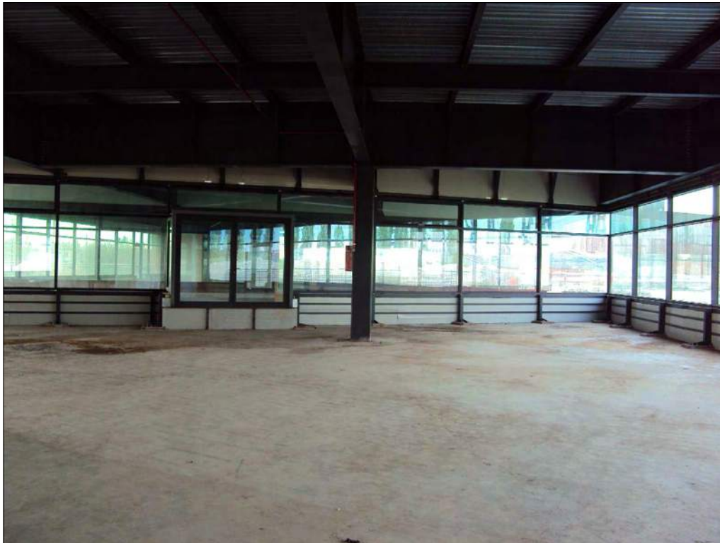
Foto n. 157: Interno locale ad uso commerciale al piano terra, da completare
