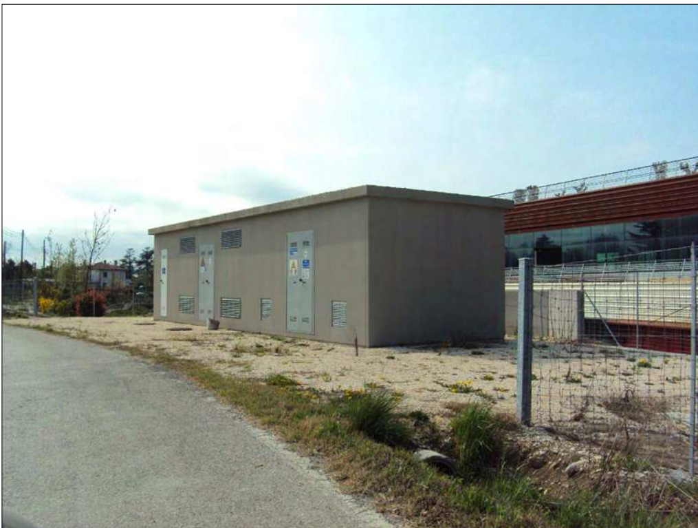
Foto n. 30: La cabina elettrica vista da Via Talpon
