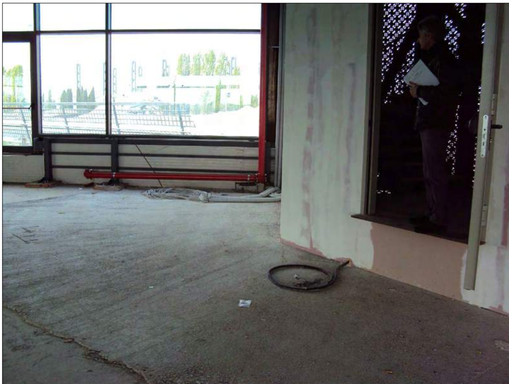
Foto n. 158: Interno locale ad uso commerciale al piano terra, da completare
