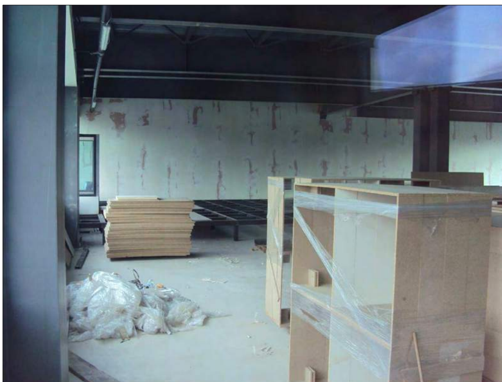
Foto n. 72: Locali ad uso industriale-artigianale al piano terra, da completare
