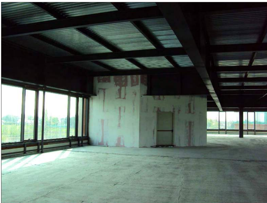
Foto n. 168: Interno primo piano, da completare
