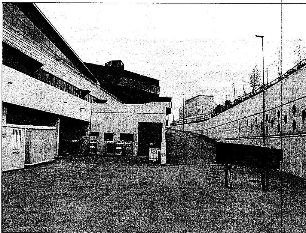
Foto n. 18: Il piazzale lato est al secondo piano sottostrada
