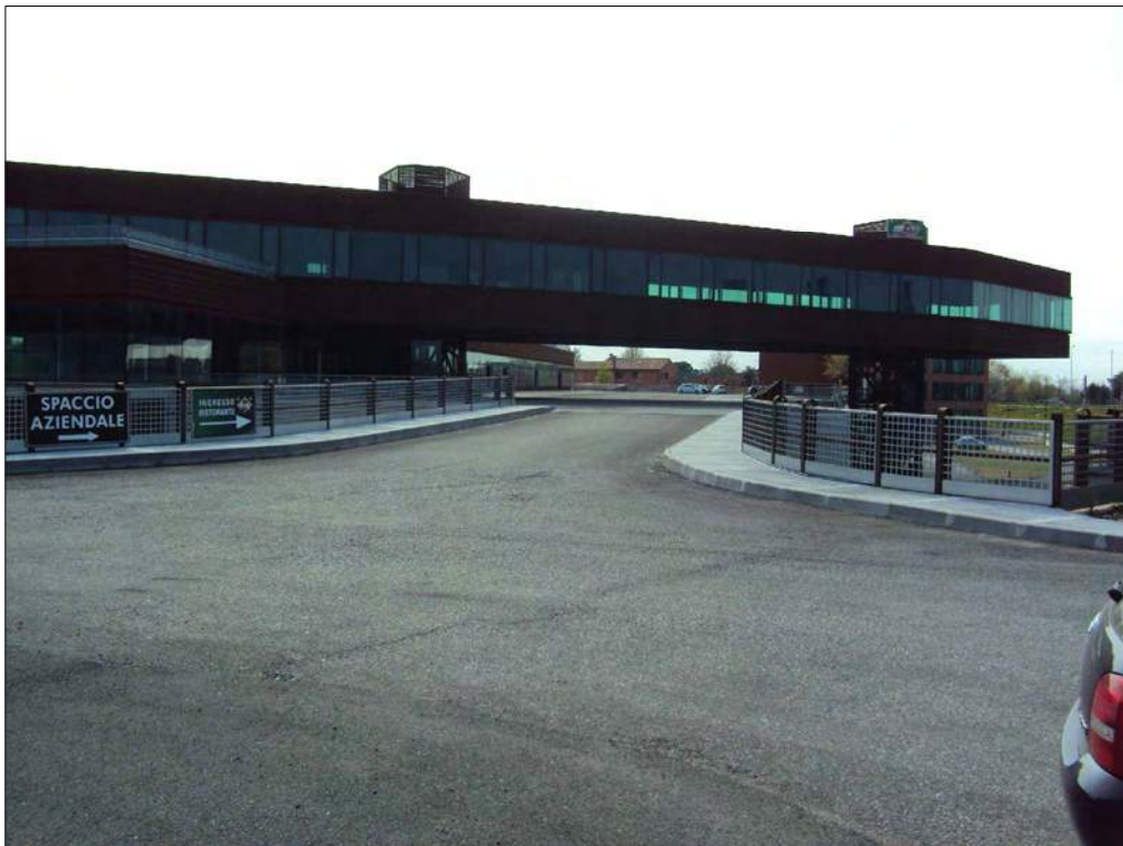
Foto n. 1: Prospetto nord visto dall'ingresso da Via della Cartiera
