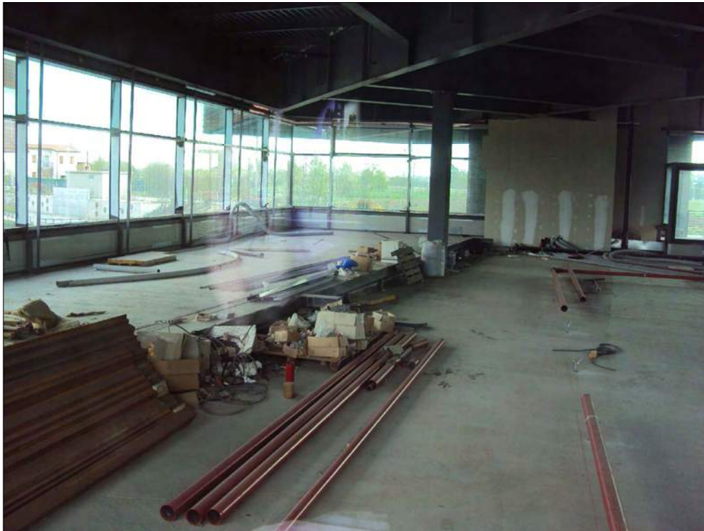
Foto n. 63: Locali ad uso industriale-artigianale al piano terra, da completare
