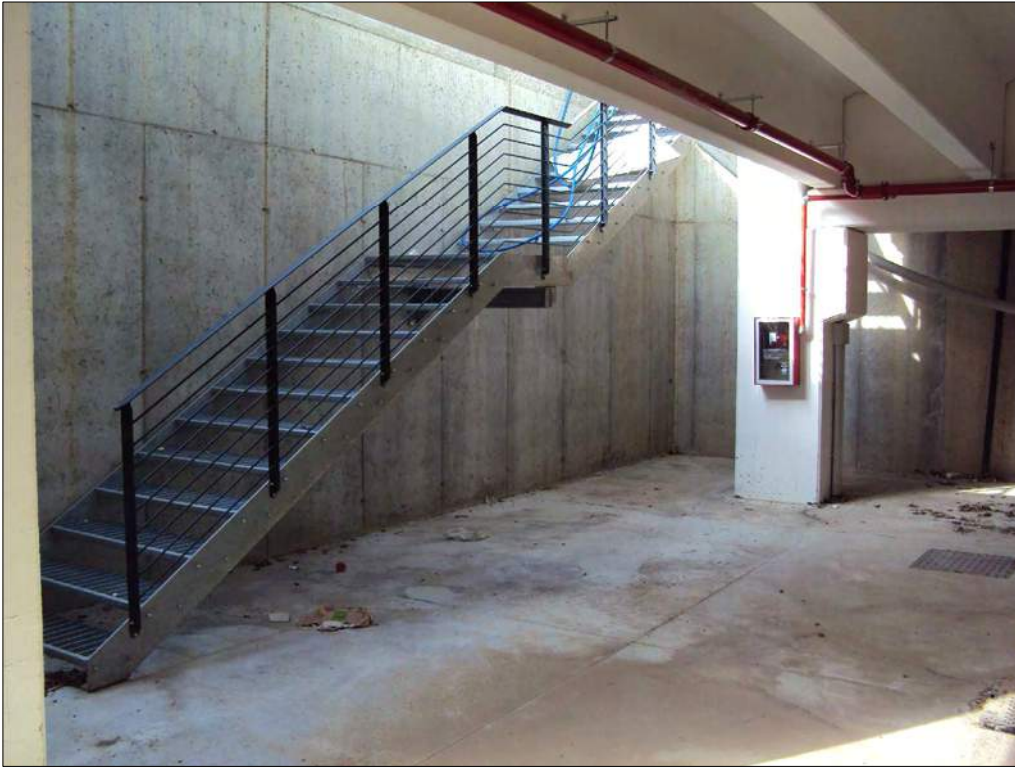
Foto n. 147: Scala di emergenza
