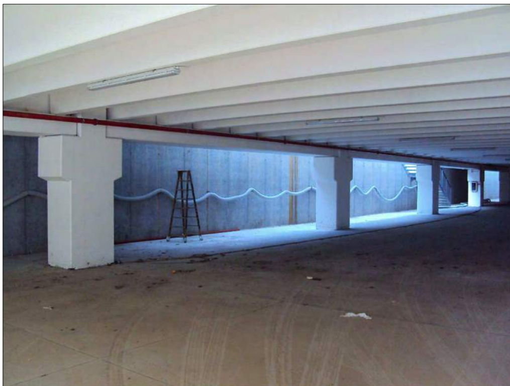
Foto n. 144: Parcheggi pertinenziali al secondo piano sottostrada
