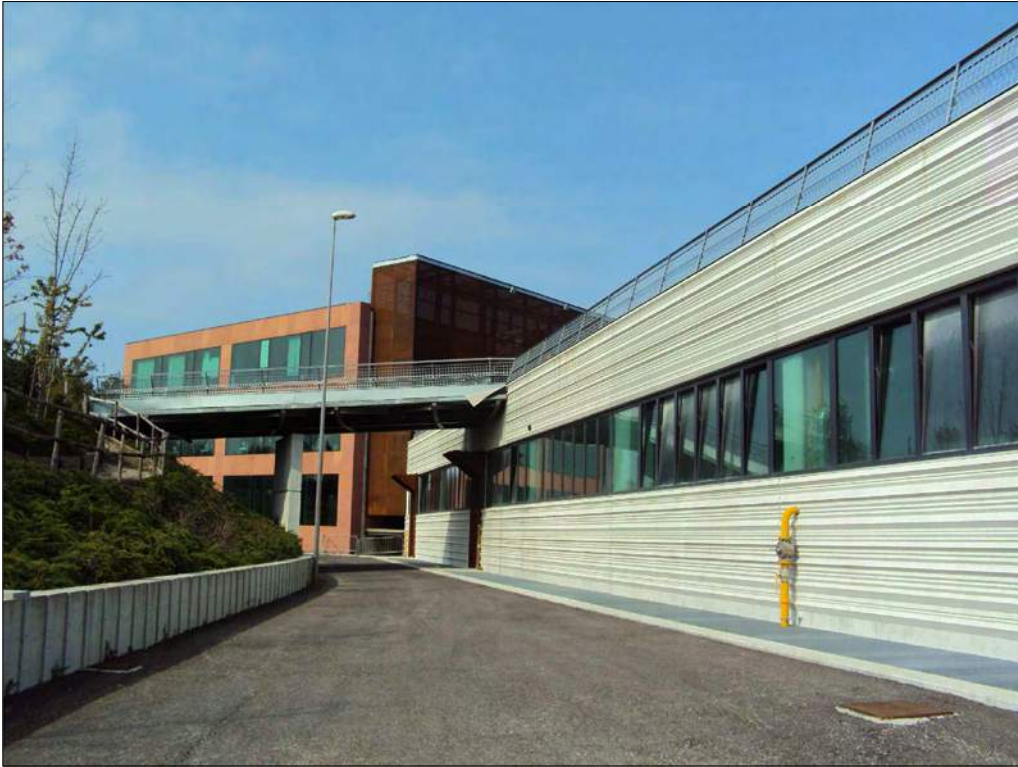
Foto n. 13: Prospetto sud al primo piano sottostrada
