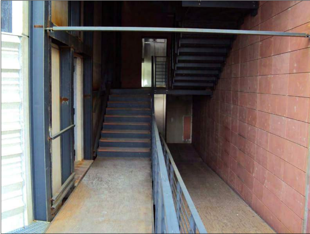
Foto n. 109: Vano scala e ascensore al primo piano sottostrada
