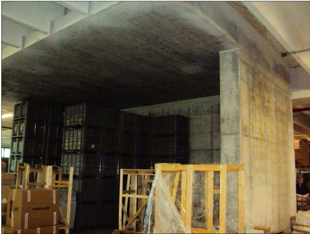
Foto n. 61: Locali ad uso industriale-artigianale al primo piano sottostrada.
