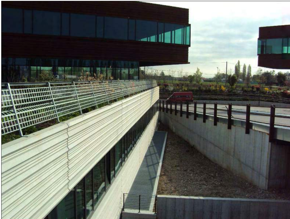
Foto n. 139: Prospetto sud primo piano sottostrada
