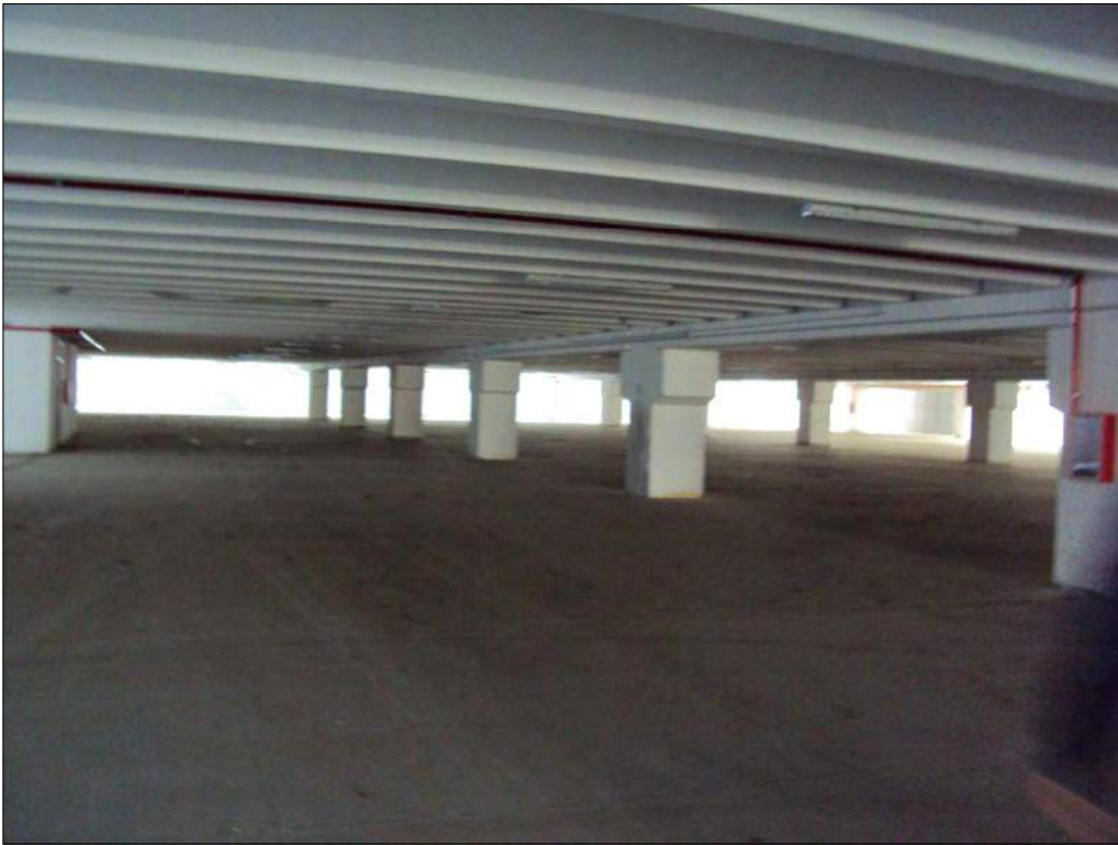
Foto n. 145: Parcheggi pertinenziali al secondo piano sottostrada
