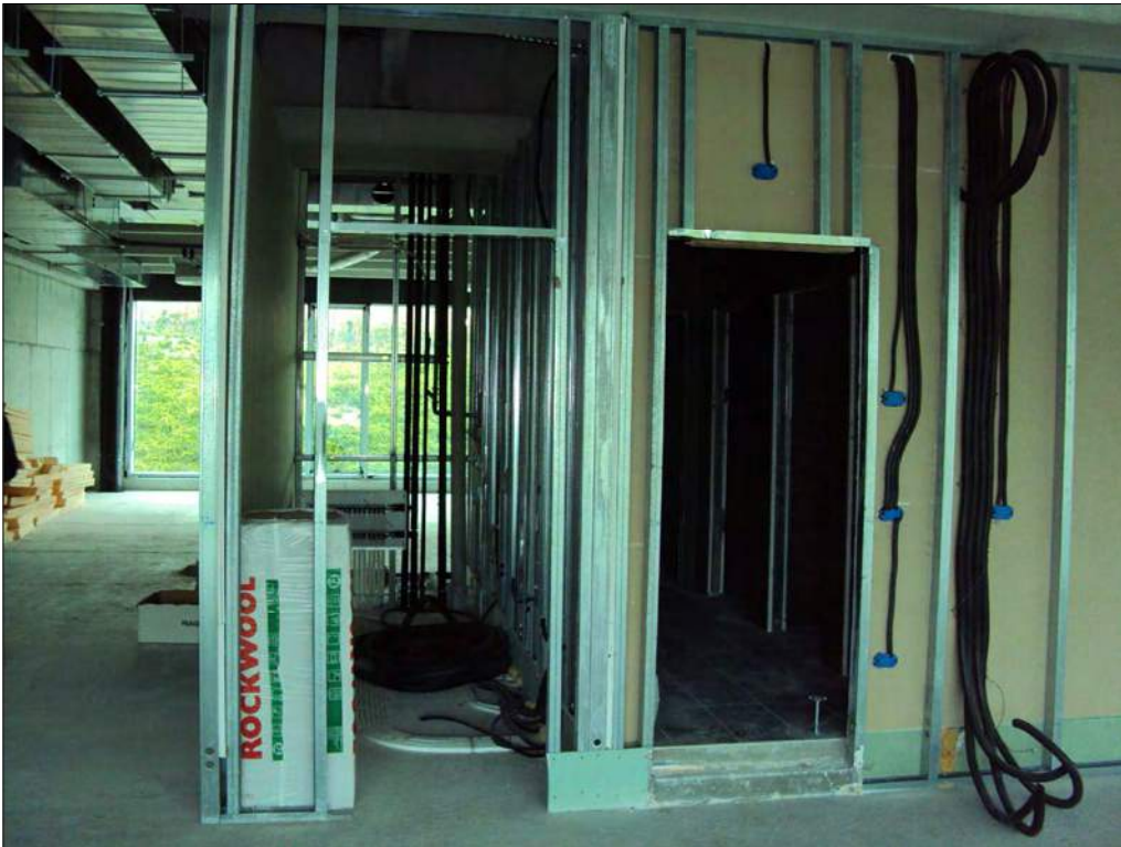
Foto n. 105: Interno primo piano sottostrada, da completare
