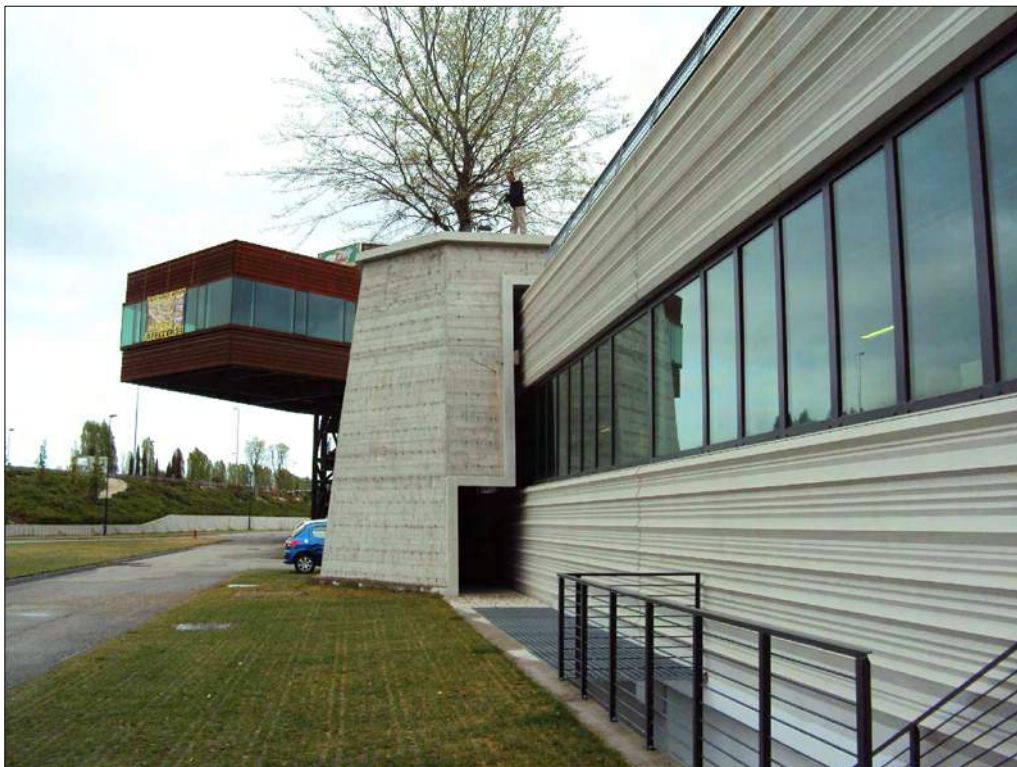
Foto n. 28: prospetto ovest al primo piano sottostrada
