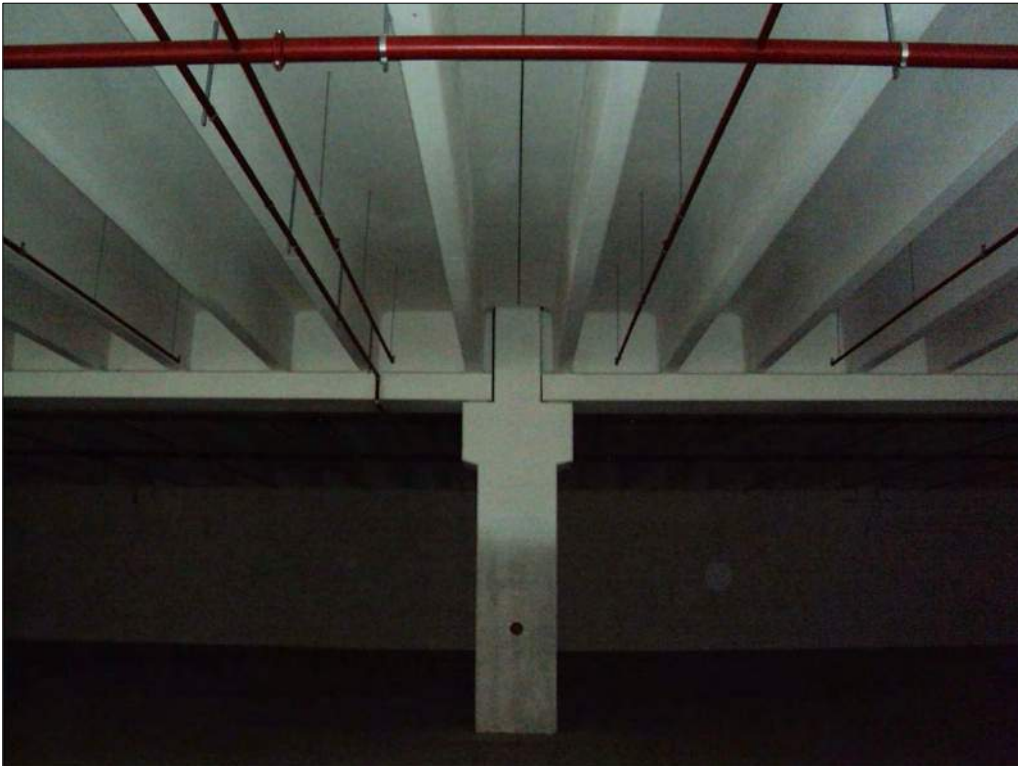
Foto n. 42: Parcheggi pertinenziali al secondo piano sottostrada
