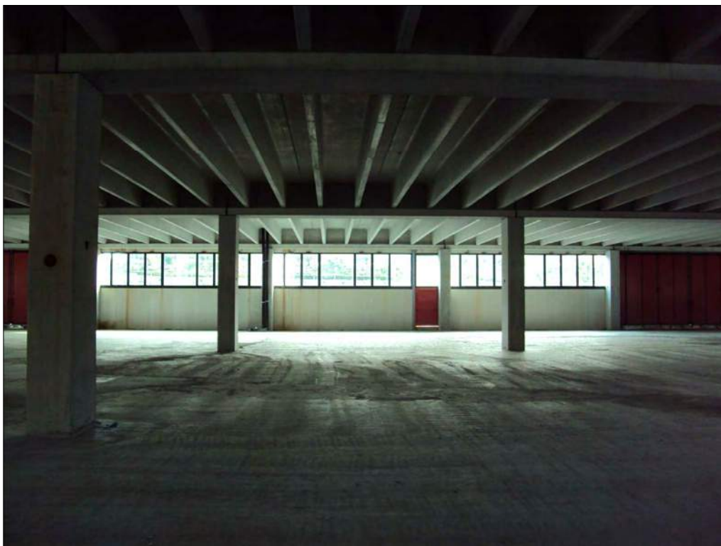
Foto n. 153: Interno primo piano sottostrada
