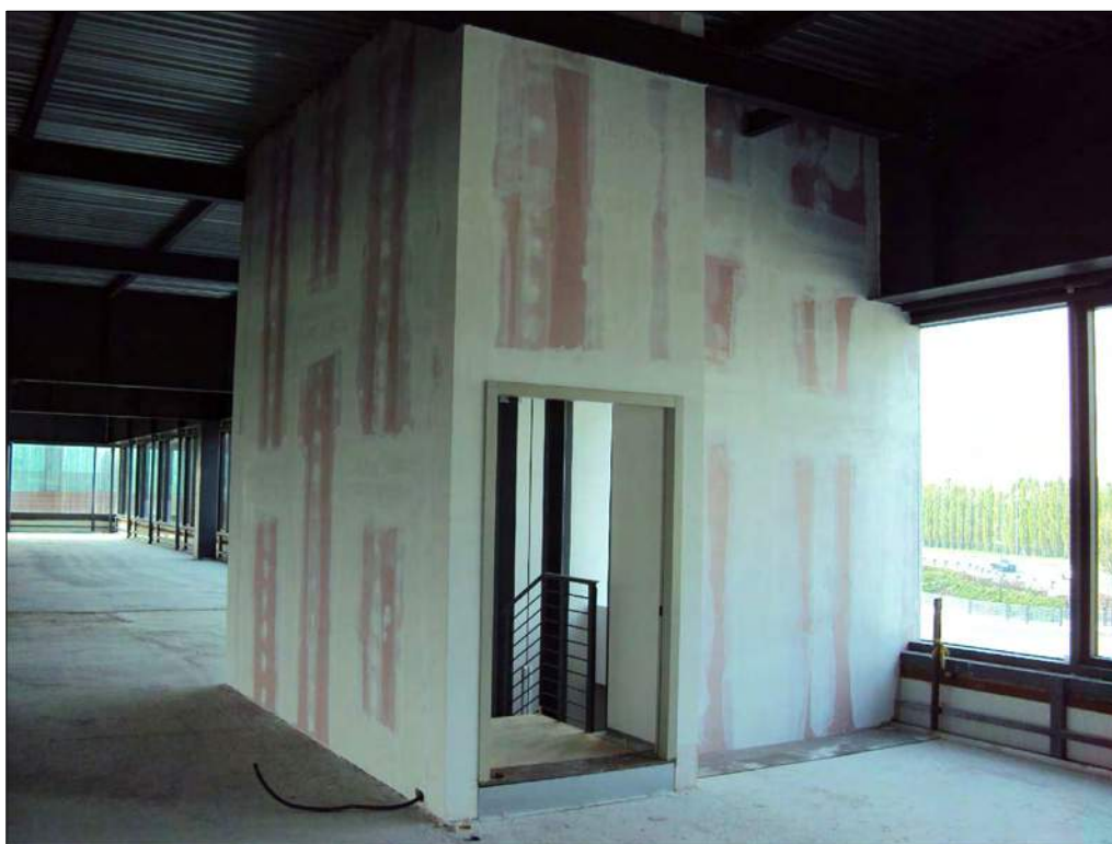
Foto n. 166: Vano scala e ascensore
