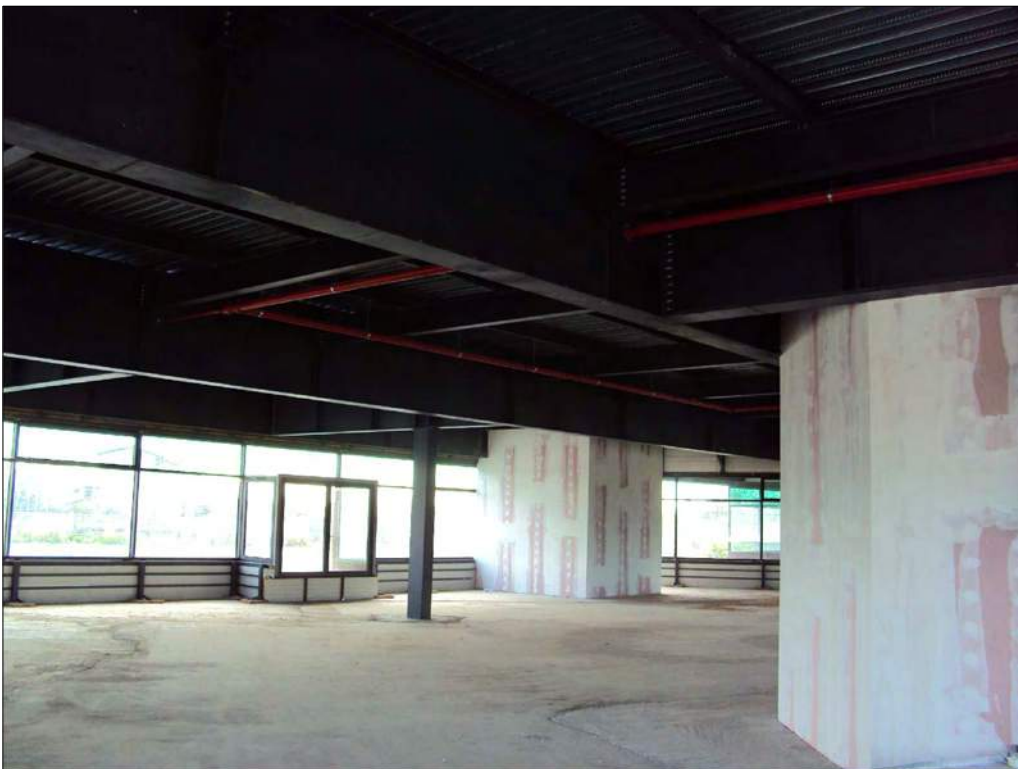
Foto n. 162: Interno locale ad uso commerciale al piano terra, da completare
