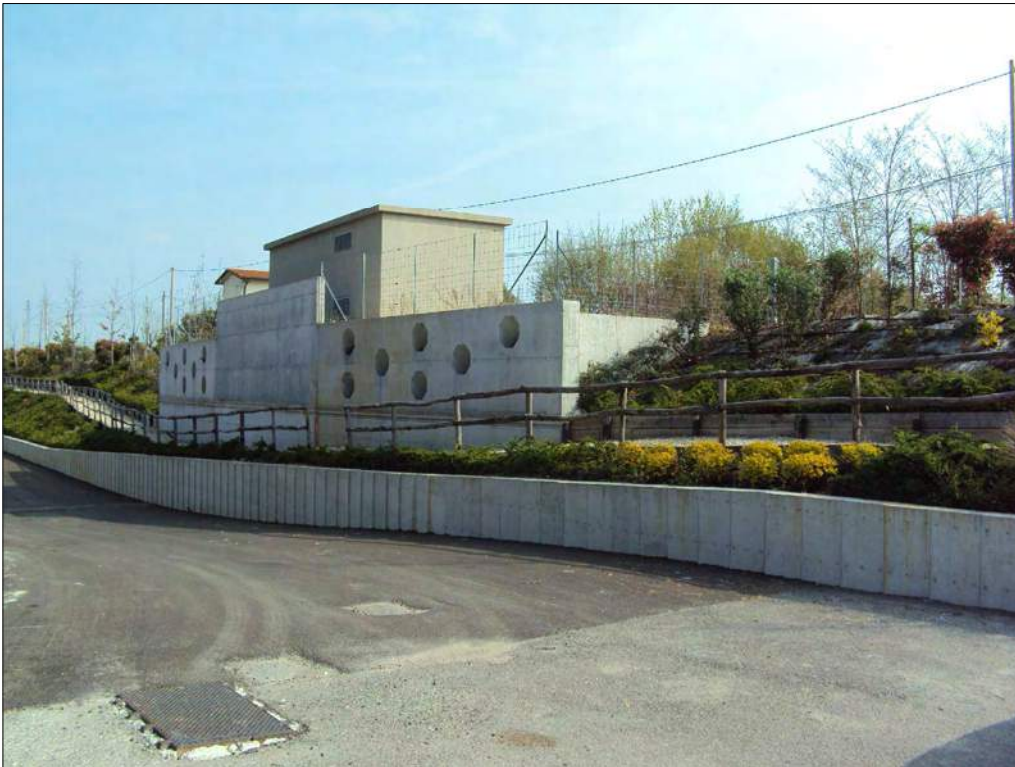
Foto n. 29: La cabina elettrica
