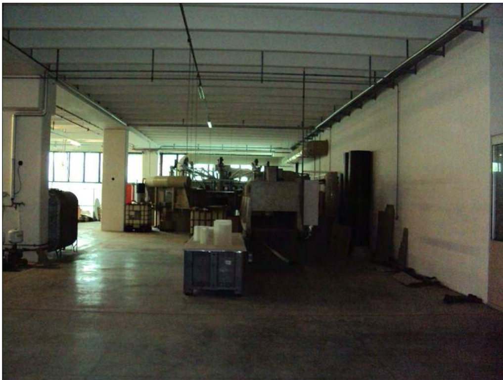
Foto n. 46: Locali ad uso industriale-artigianale al primo piano sottostrada
