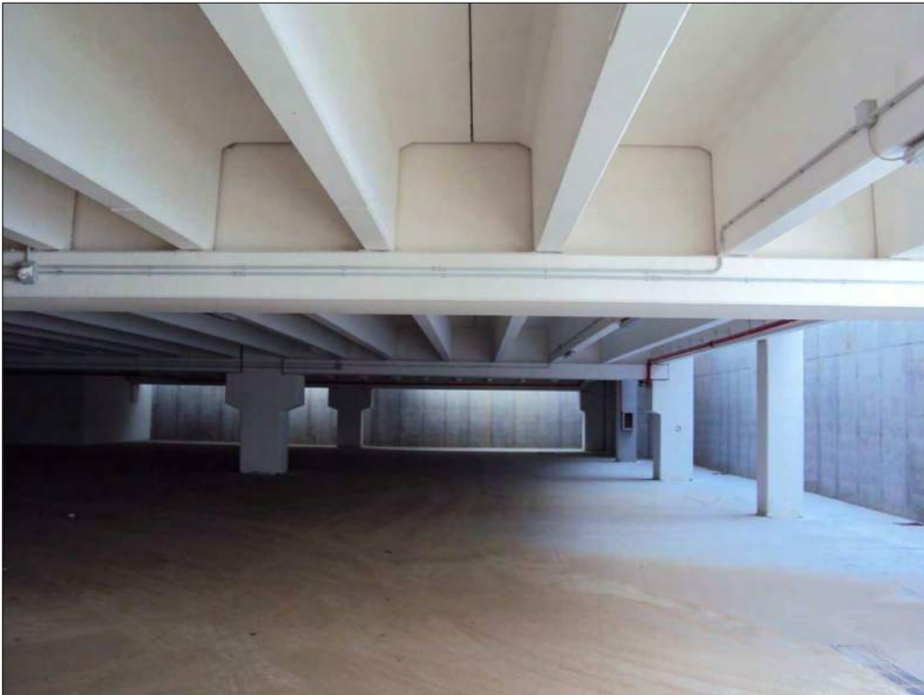
Foto n. 146: Parcheggi pertinenziali al secondo piano sottostrada
