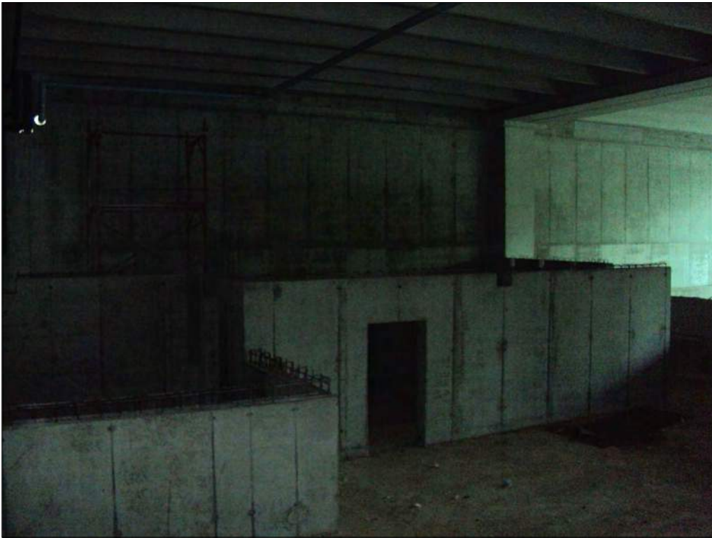
Foto n. 101: Interno secondo piano sottostrada, al grezzo
