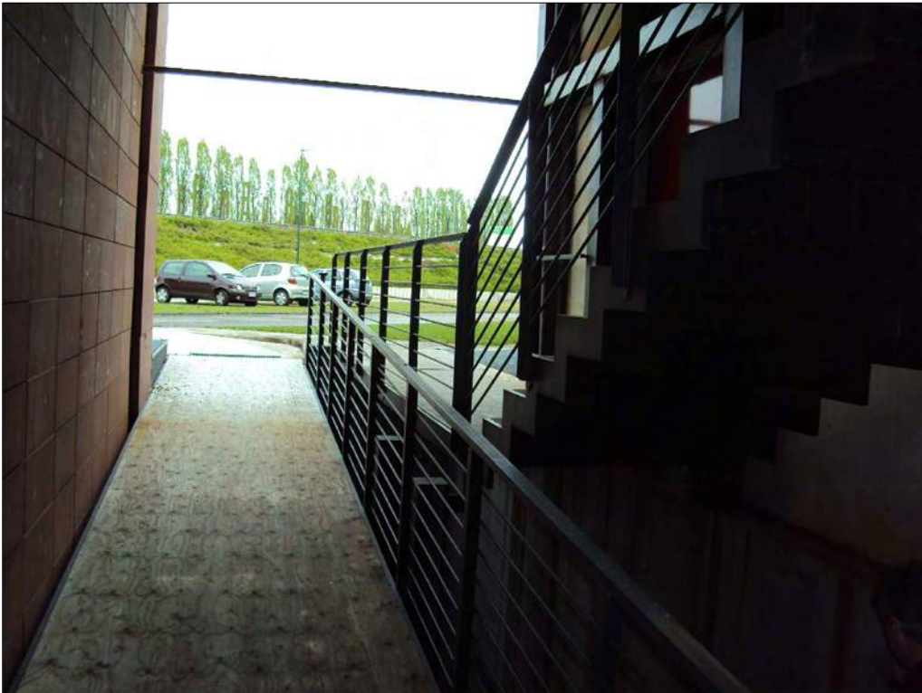
Foto n. 110: Vano scale e ascensore al primo piano sottostrada
