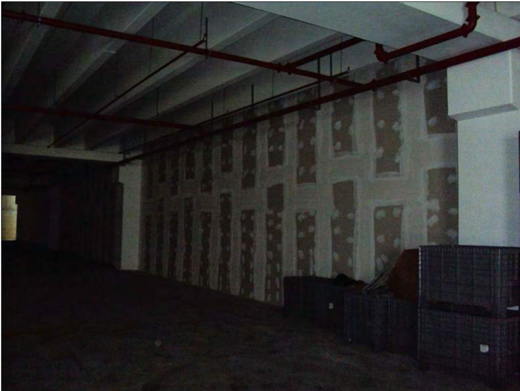
Foto n. 36: Parcheggi pertinenziali al secondo piano sottostrada
