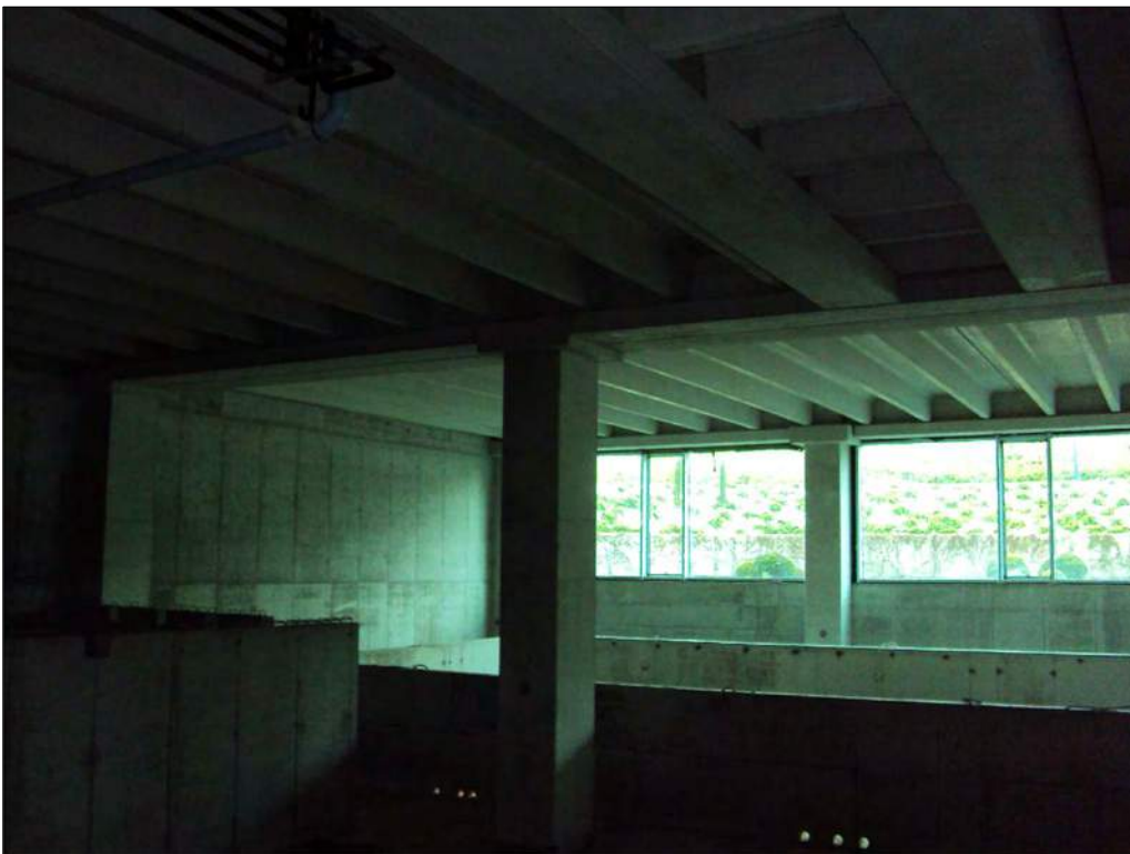
Foto n. 102: Interno secondo piano sottostrada, al grezzo
