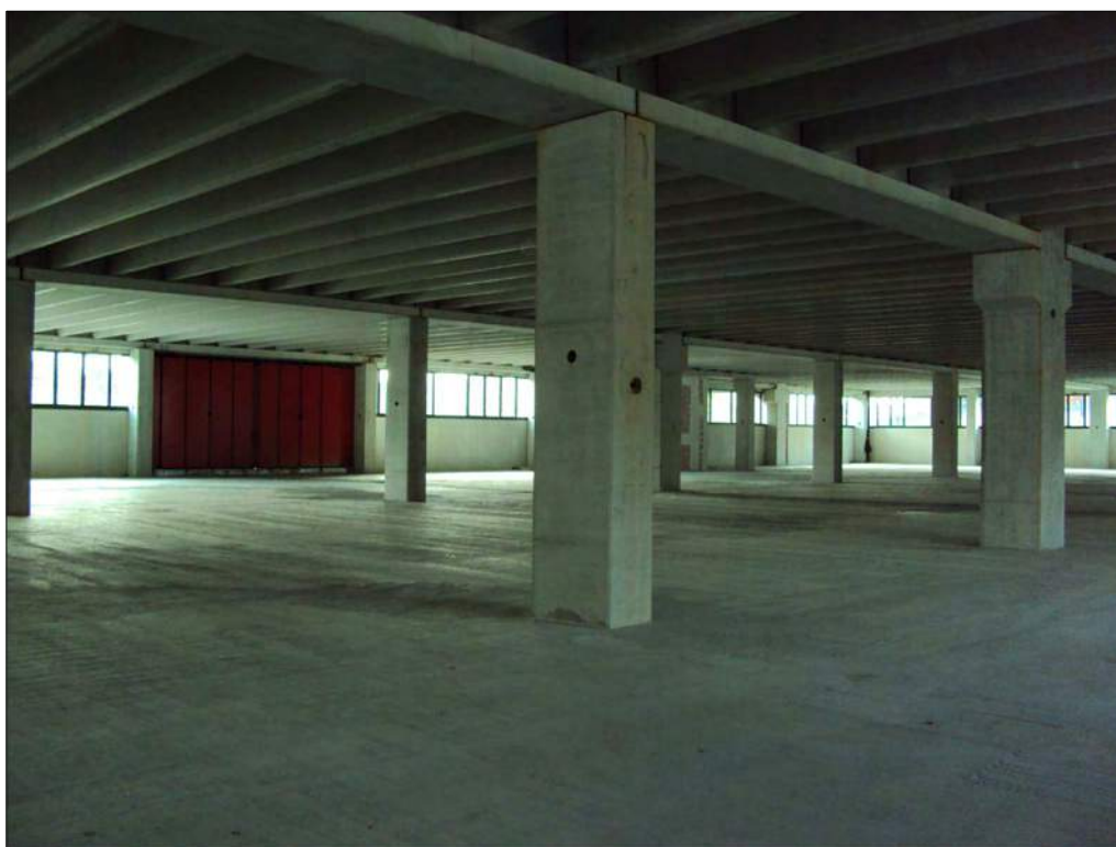
Foto n. 156: Interno primo piano sottostrada
