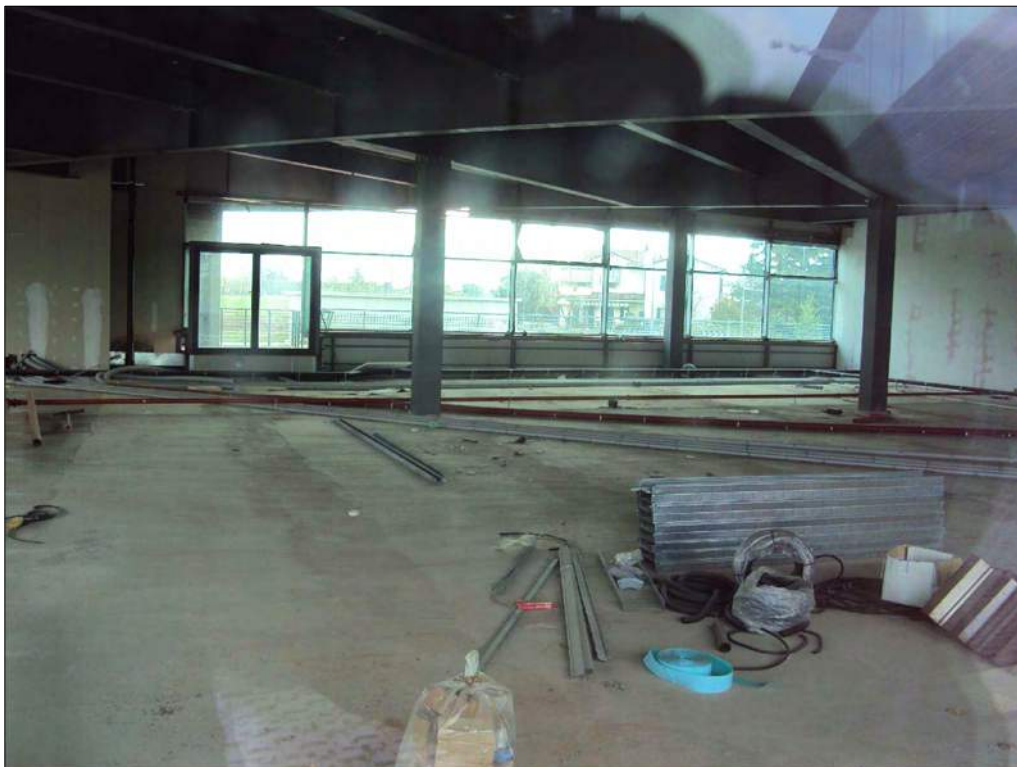
Foto n. 64: Locali ad uso industriale-artigianale al piano terra, da completare
