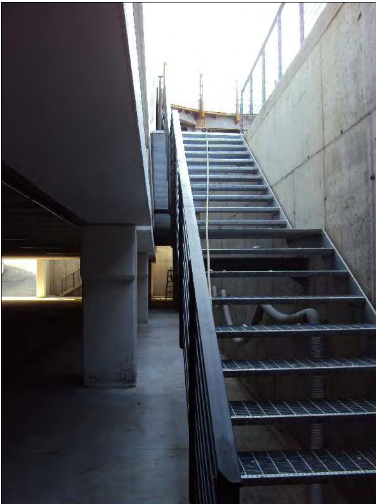
Foto n. 148: Scala di emergenza
