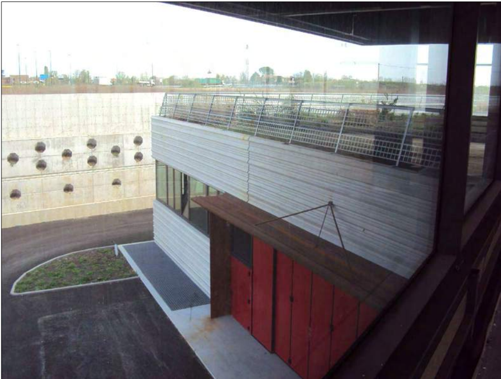
Foto n. 141: Prospetto ovest primo piano sottostrada
