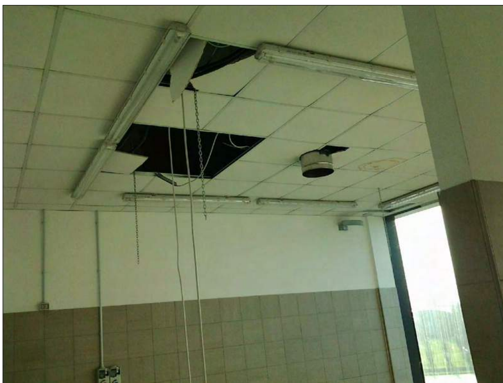
Foto n. 83: Locali ad uso commerciale al primo piano, oggetto di atti vandalici
