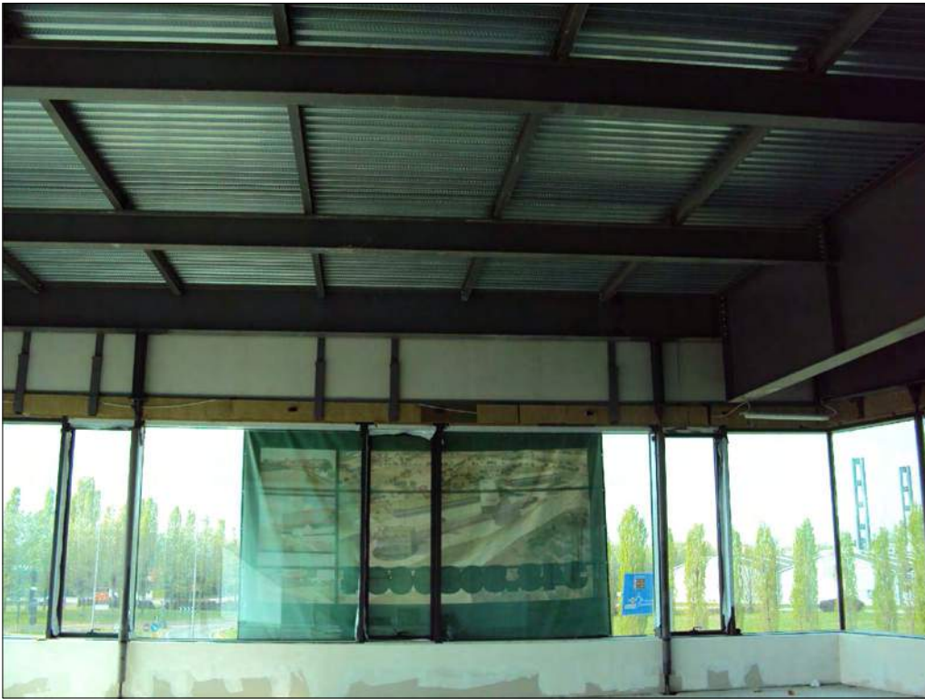
Foto n. 73: Locale ad uso industriale-artigianale al primo piano lato ovest, da completare
