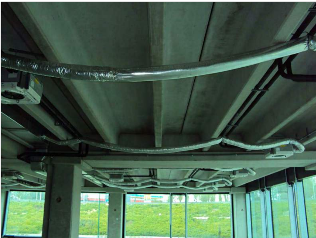
Foto n. 104: Interno primo piano sottostrada, da completare
