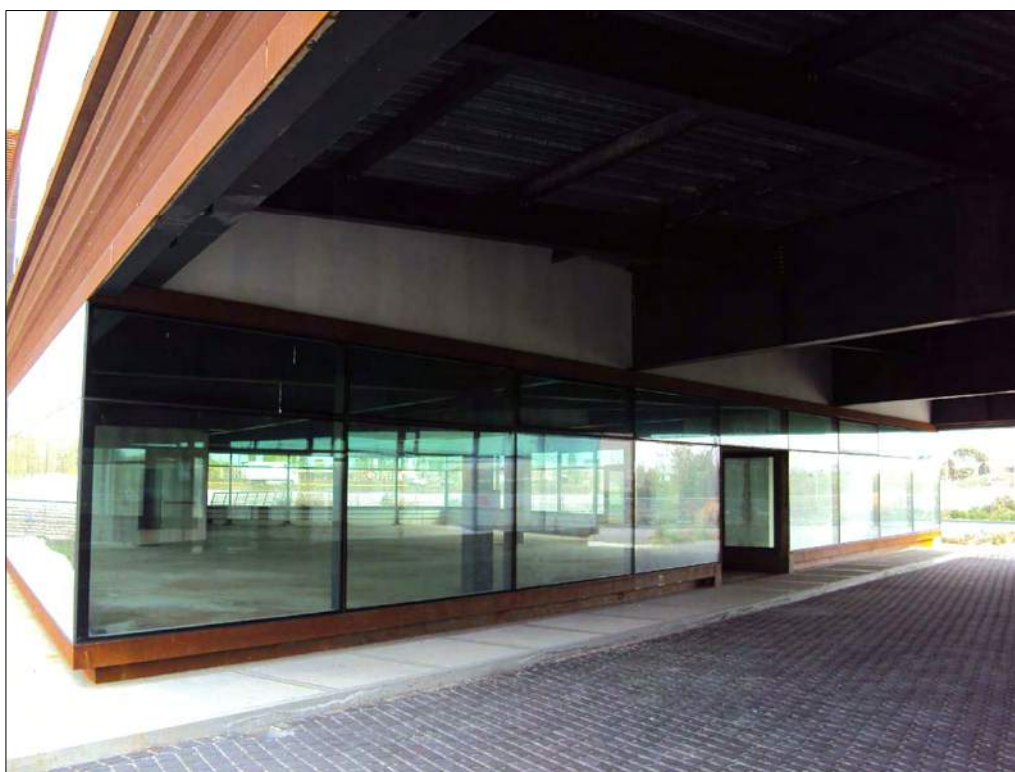
Foto n. 131: Zona porticata centrale
