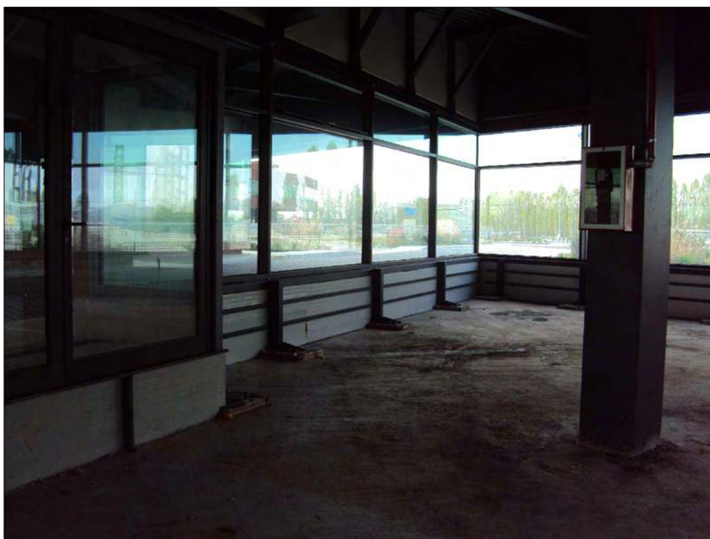
Foto n. 160: Interno locale ad uso commerciale al piano terra, da completare
