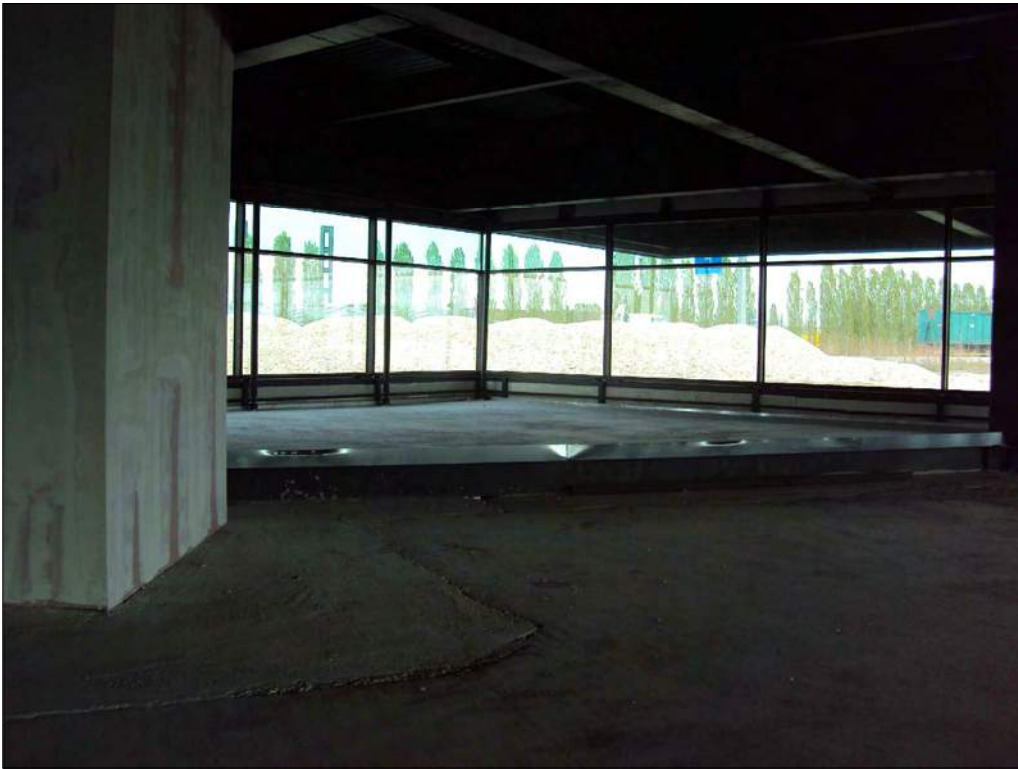
Foto n. 161: Interno locale ad uso commerciale al piano terra, da completare
