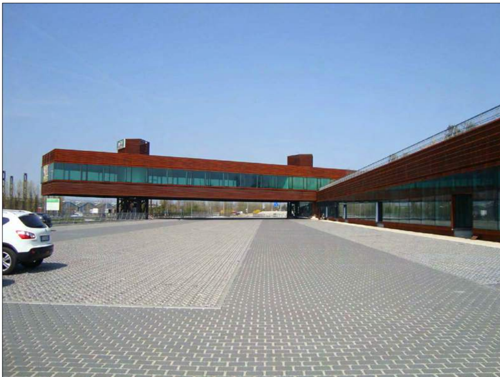
Foto n. 4: Il piazzale lato ovest
