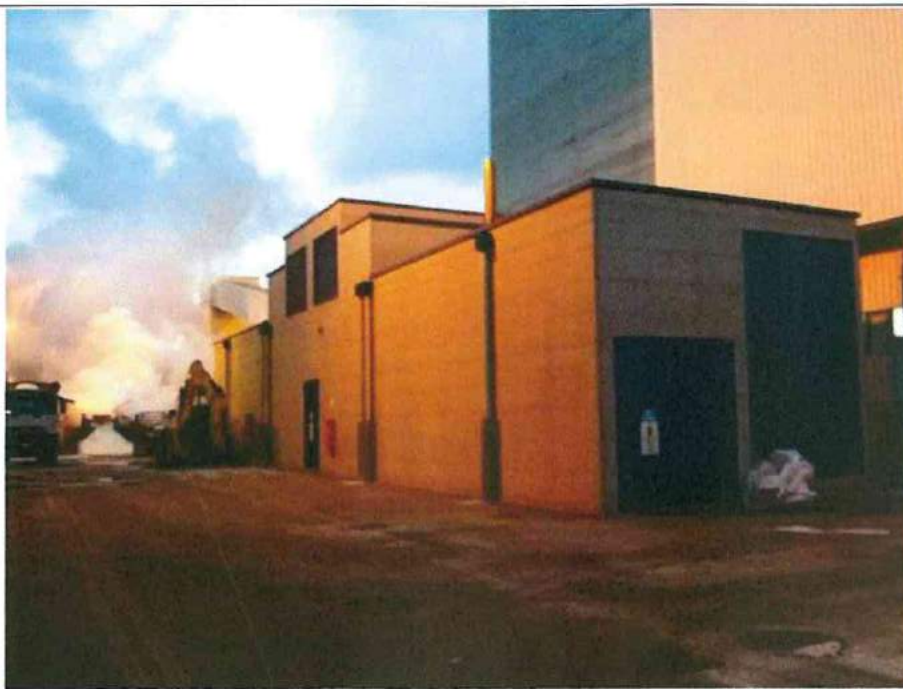
LOCALE GRUPPI ELETTOGENI
