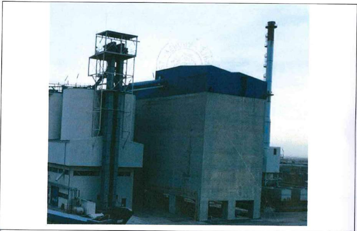
STOCCAGGIO SABBIA SILOS
