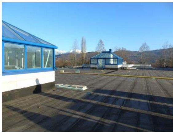
Vista tetto verso sud
