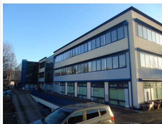
Vista parte posteriore fabbricato
