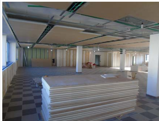
Vista verso zona servizi
