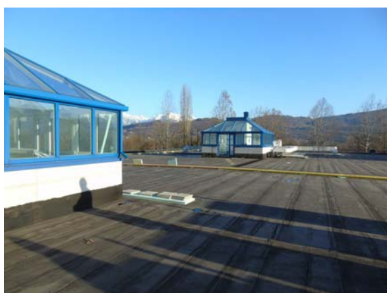
Vista tetto verso sud
