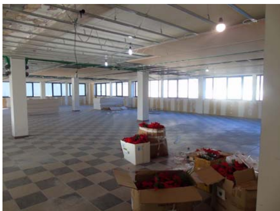
Vista vano sub 20
