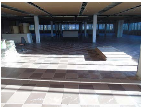
Vista verso sud sub 4
