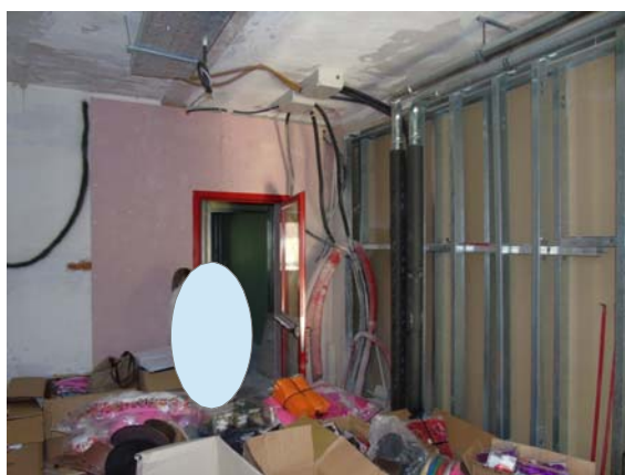
Vista ingresso verso servizi
