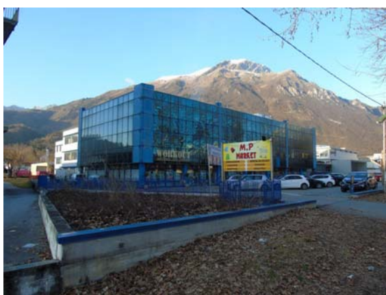
Vista fronte principale fabbricato
