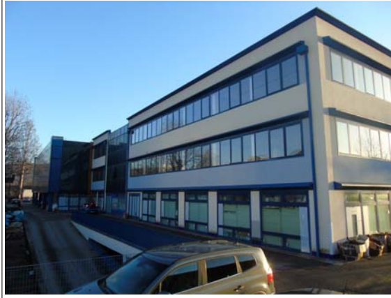
Vista parte posteriore fabbricato
