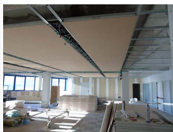
Vista locale in costruzione
