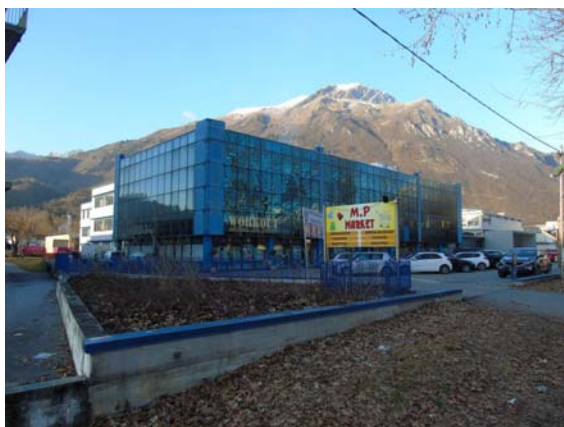
Vista fronte principale fabbricato
