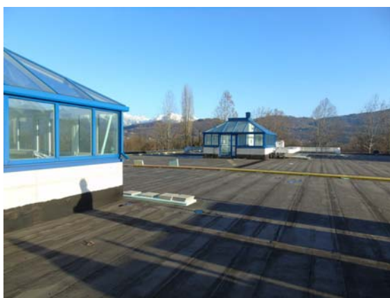
Vista tetto verso sud
