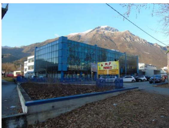
Vista fronte principale fabbricato
