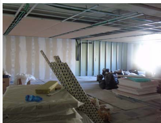
Vista vano sub 21 in costruzione
