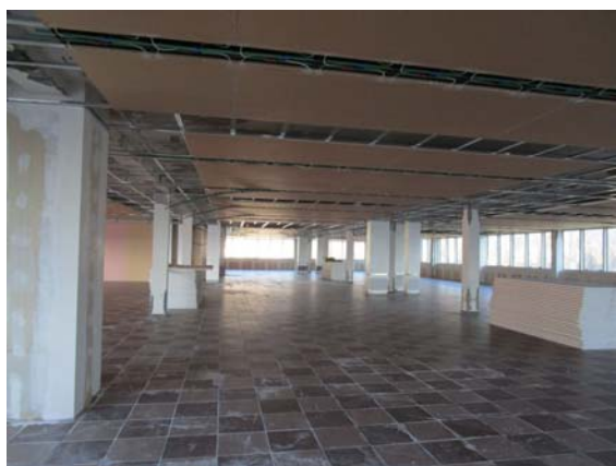
Vista verso sud-est
