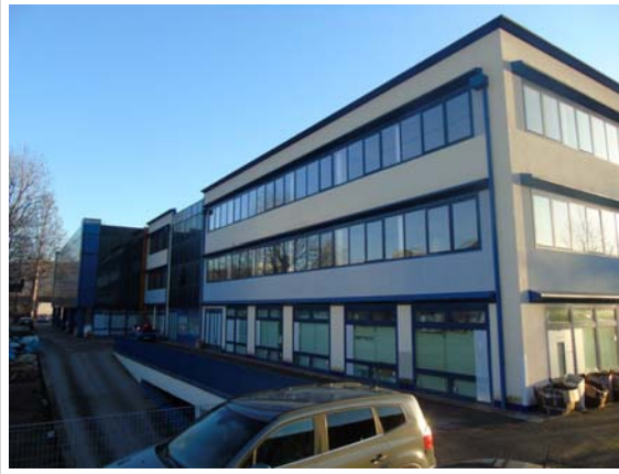
Vista parte posteriore fabbricato
