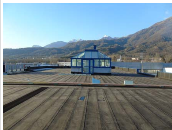
Vista tetto verso nord
