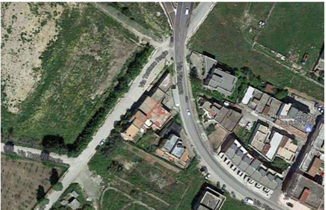
FOTO 2 -PARTICOLARE DEL FABBRICATO (vista dall'alto)
