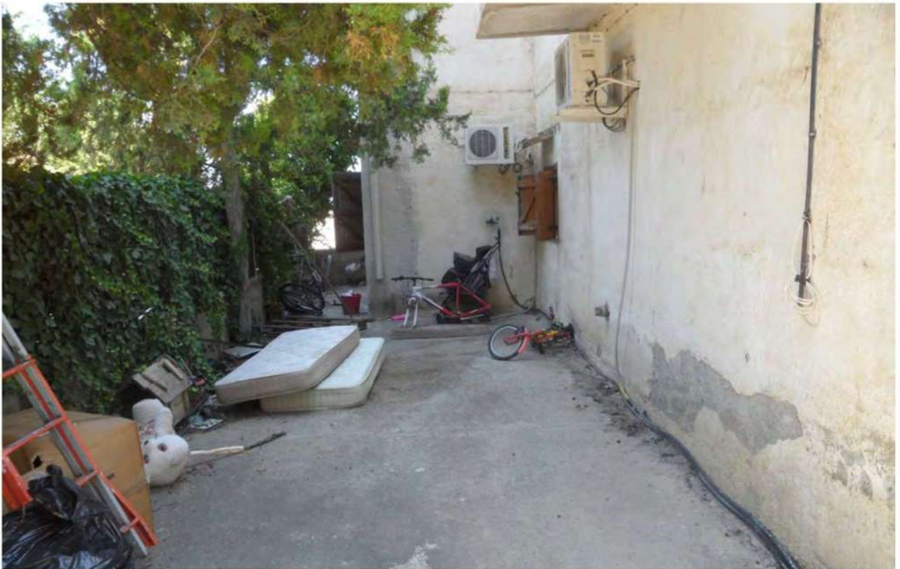
FOTO 8 - VISTA ESTERNA (cortile interno)
