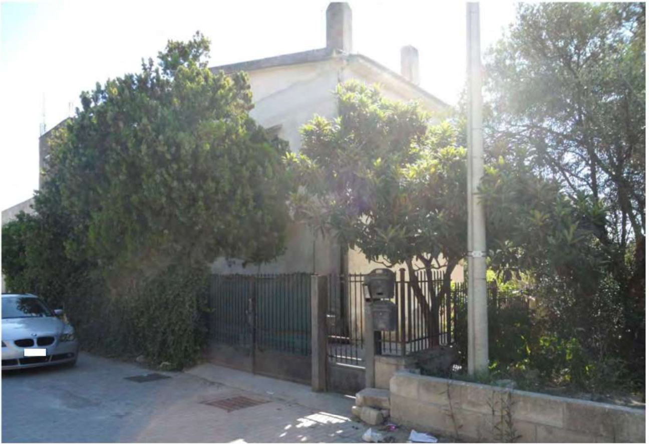
FOTO 5 -VISTA ESTERNA DEL FABBRICATO
