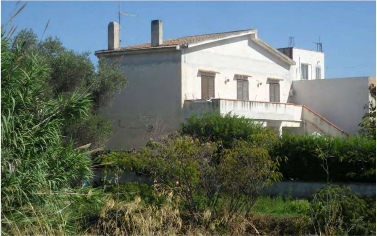
FOTO 3 - VISTA ESTERNA DEL FABBRICATO
