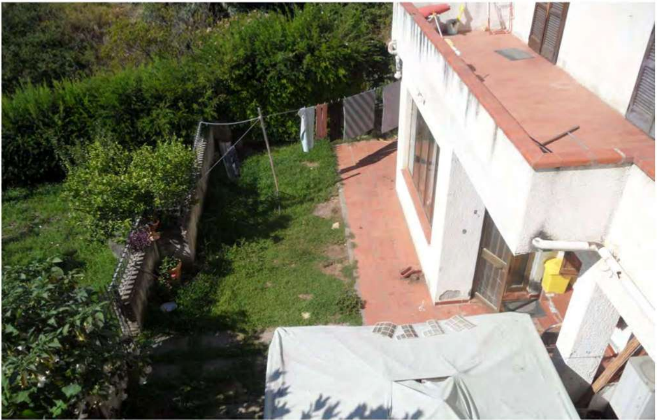
FOTO 9 - PARTICOLARE DEL FABBRICATO (cortile antistante alloggio)
