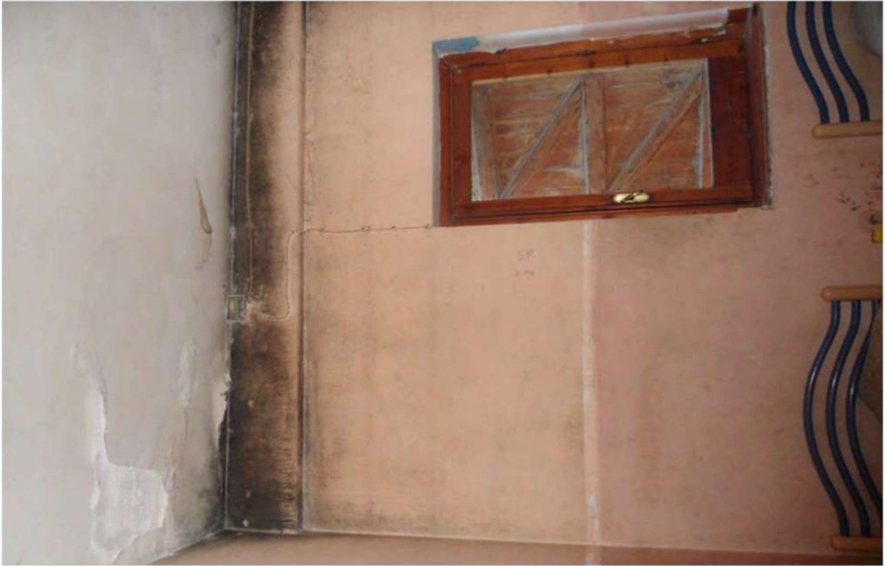
FOTO 19 - VISTA INTERNA (camera da letto doppia)
