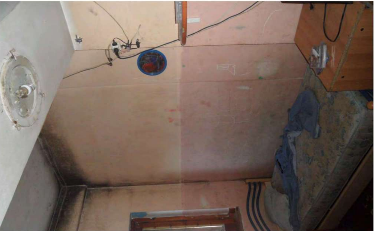
FOTO 18 - VISTA INTERNA (camera da letto matrimoniale)
