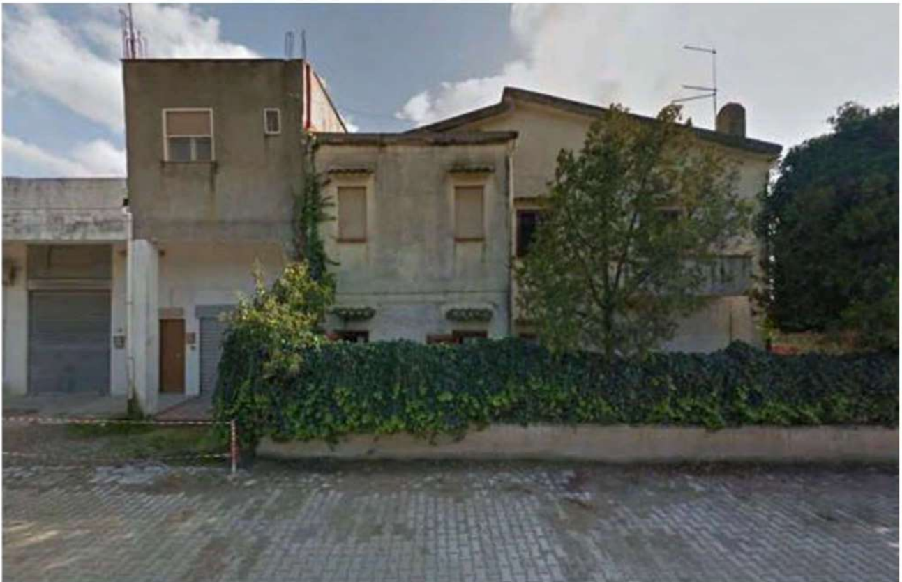
FOTO 4 -VISTA ESTERNA DEL FABBRICATO
