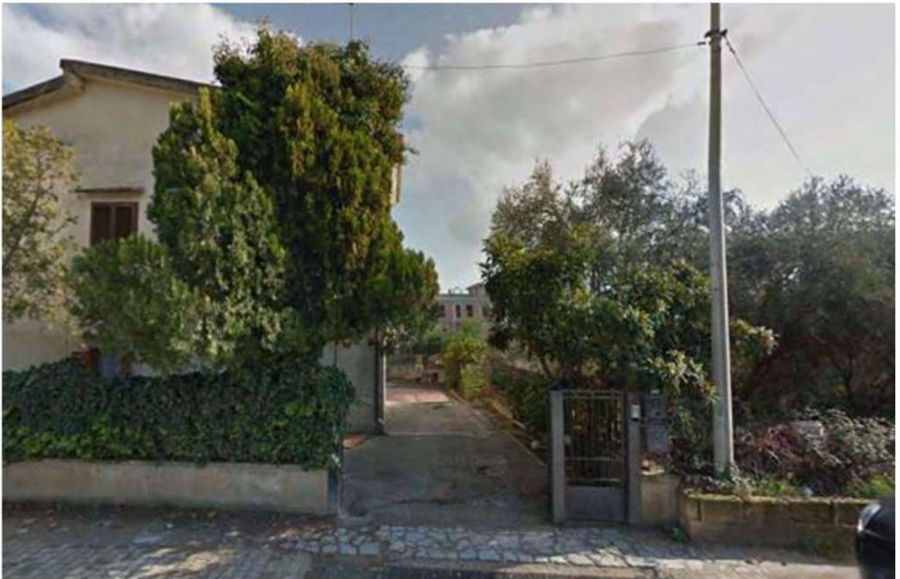
FOTO 6 - VISTA ESTERNA DEL FABBRICATO
