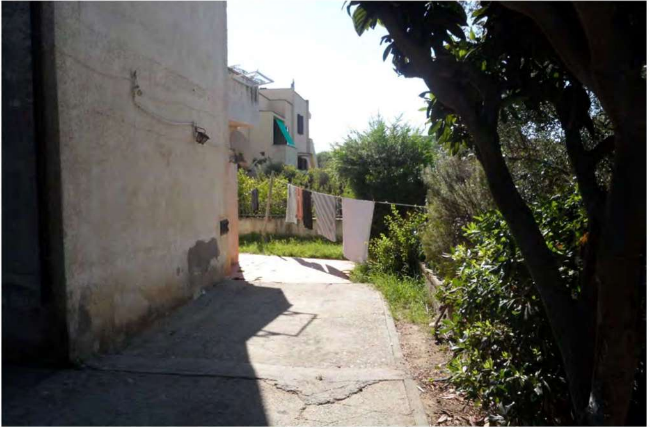
FOTO 7 - VISTA ESTERNA (cortile interno)
