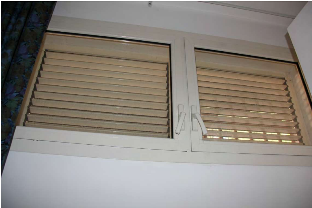
foto 9. particolare infissi camera da letto
