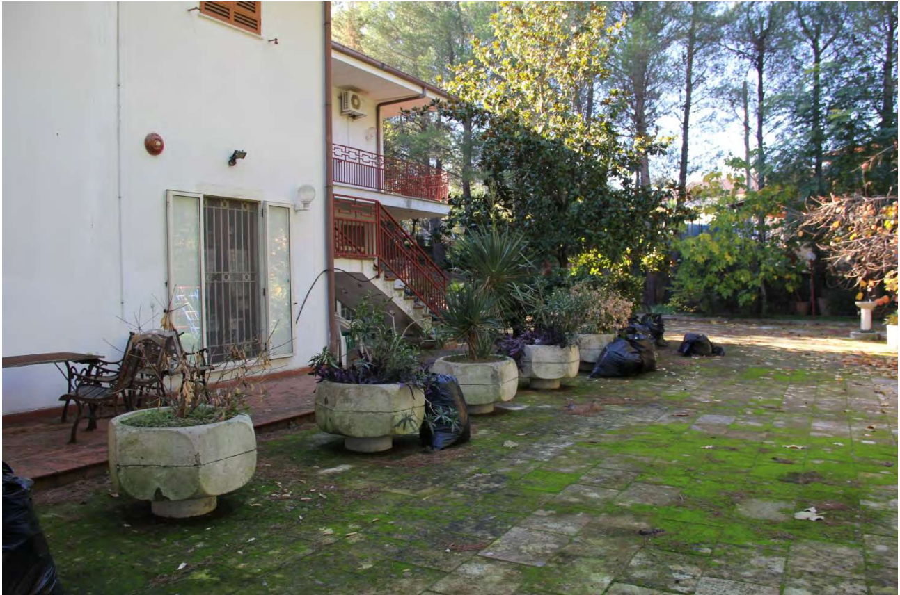
foto 14. finestra cucina e giardino condominiale sul lato nord
