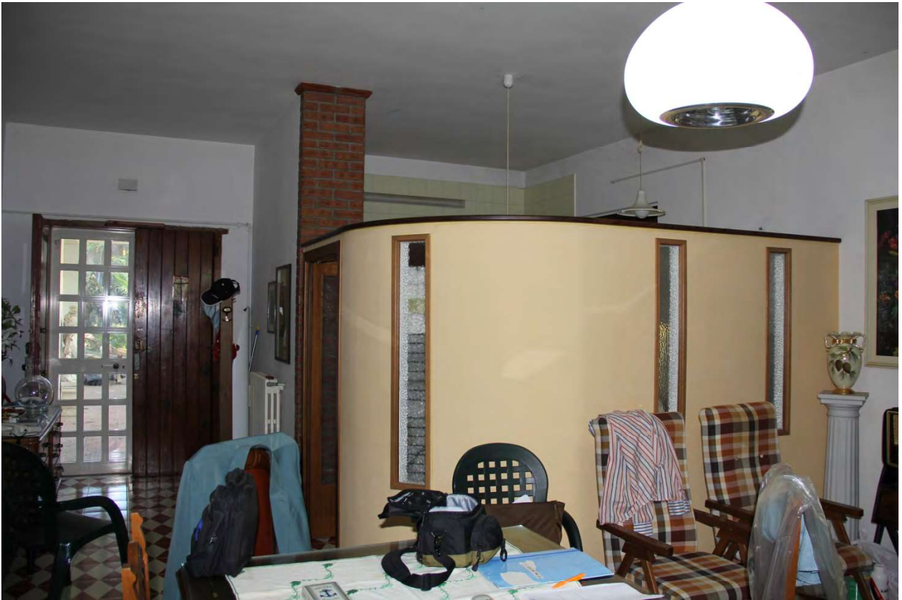
foto 2. ingresso e struttura in cartongesso della cucina
