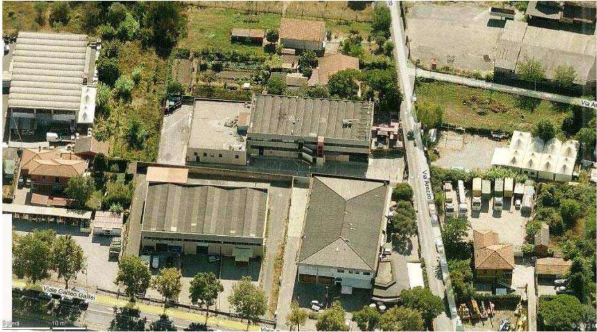
- Foto n° 3 – Ripresa Aerea - Prospetto lato Spezia.-
