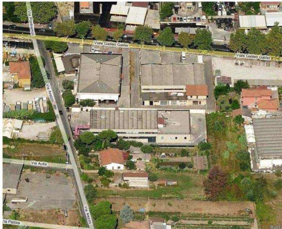
- Foto n° 5 – Ripresa Aerea - Prospetto lato Viareggio.-
