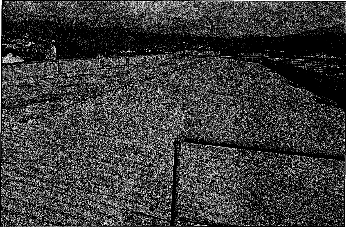
Figura 1. Veduta della copertura in Eternit del fabbricato distinto al mappale 1159
