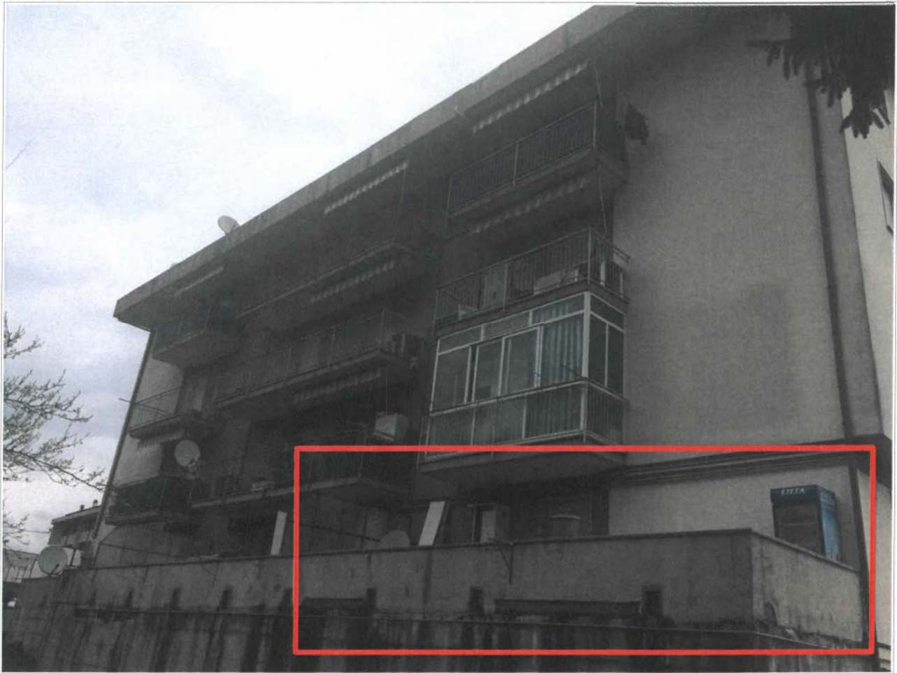
Vista dalla corte interna del fabbricato condominiale
