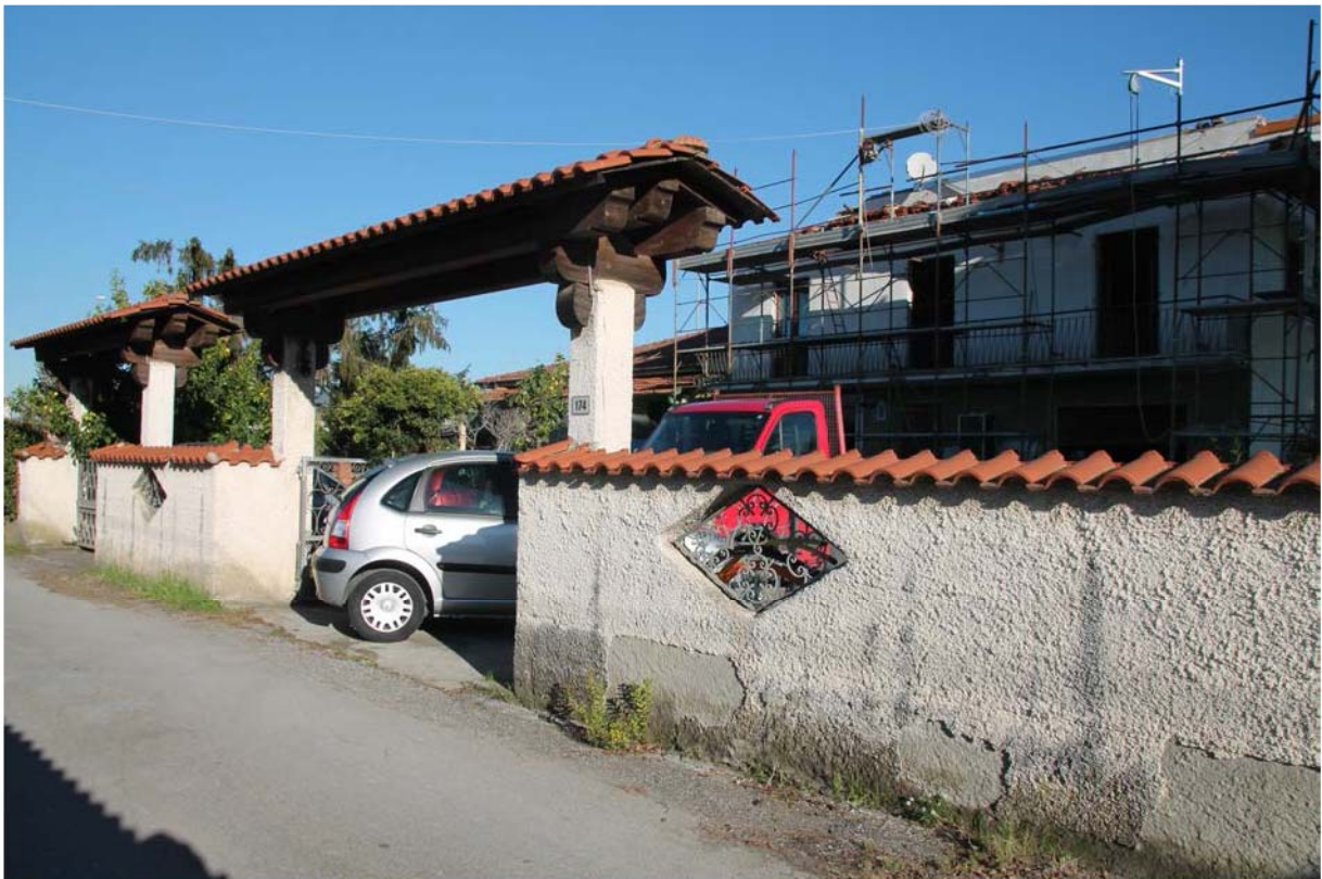
Foto 23. Ingresso carrabile e pedonale al sub.11
