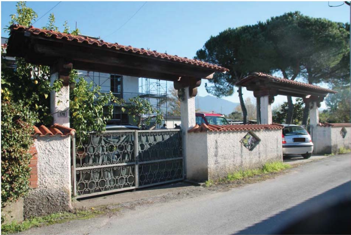
Foto 24. Ingresso carrabile e pedonale al sub.11
