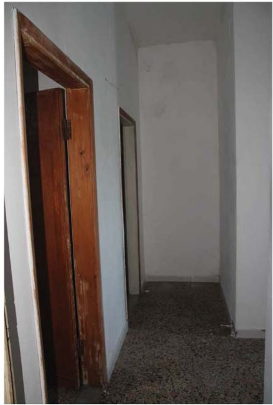
Foto 6. Disimpegno zona notte (Sub.8)
