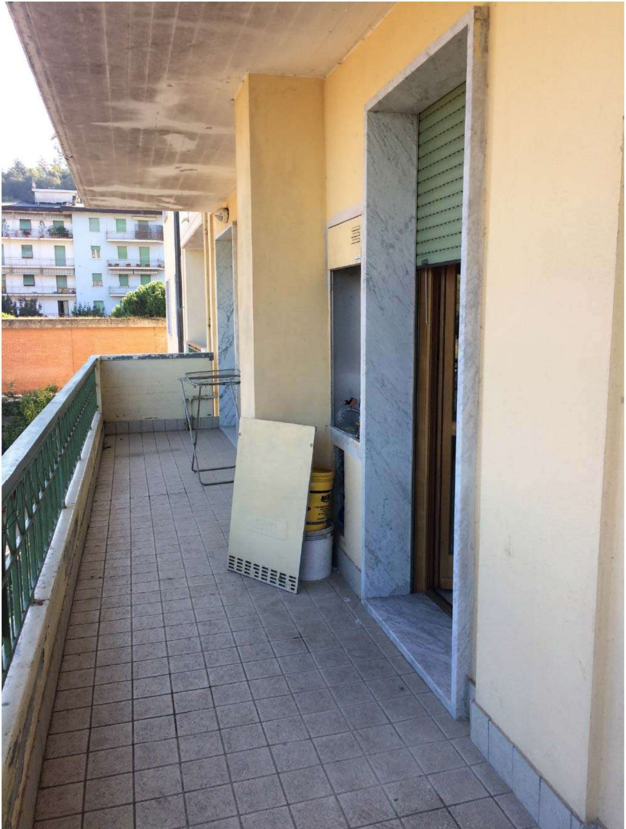
Foto 24 – Balcone (alloggio caldaia)
