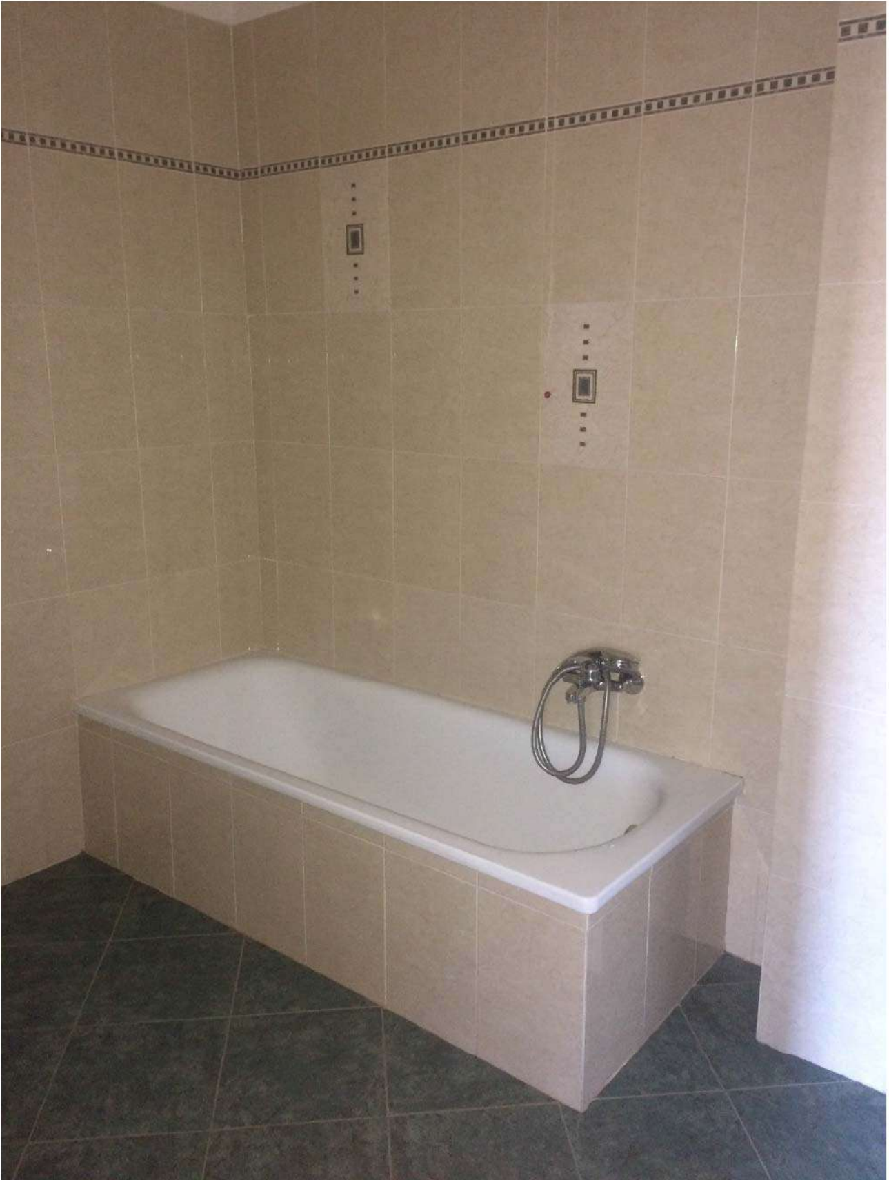
Foto 22 – Bagno con vasca
