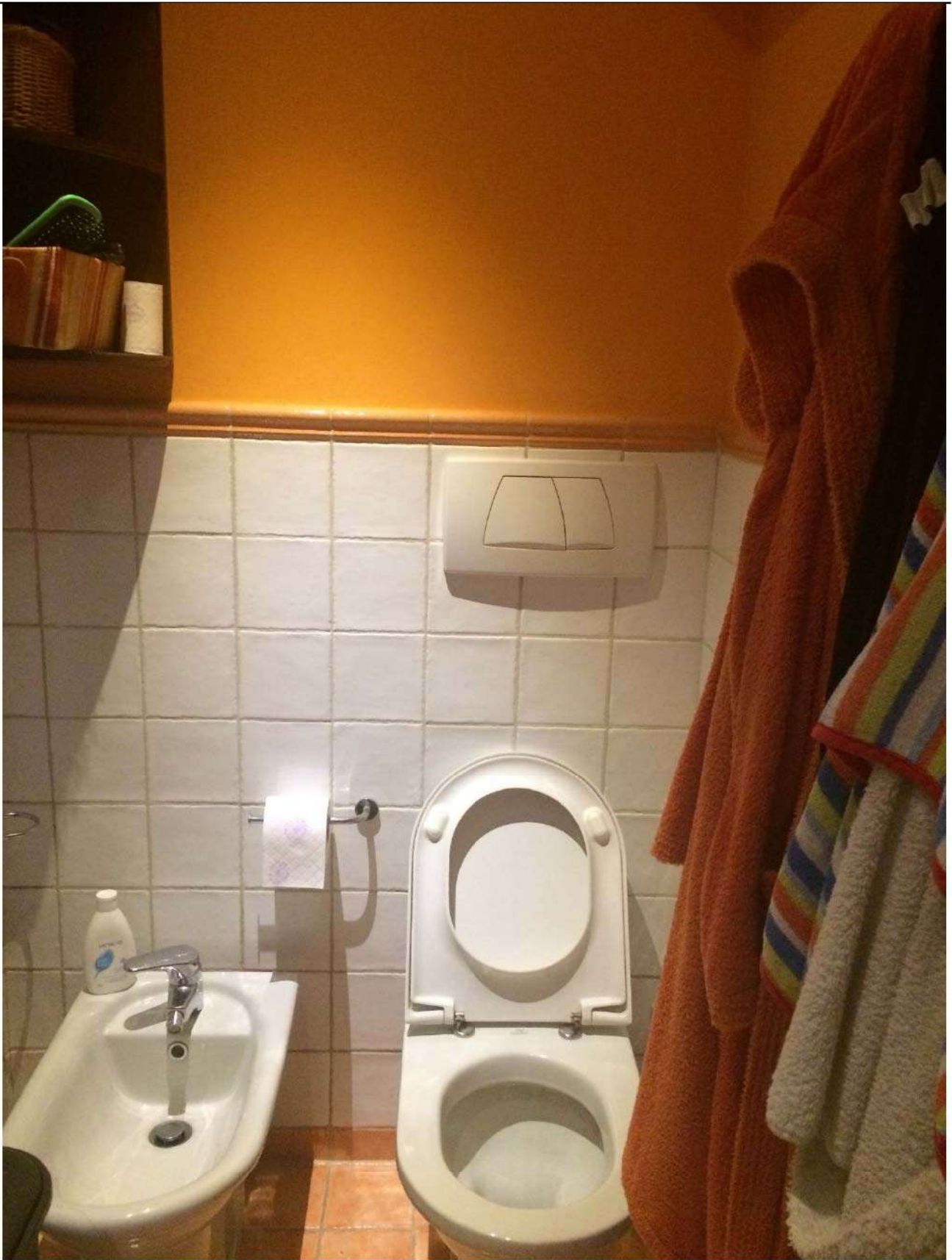
Foto 17 – Bagno con doccia piano primo (da demolire)
