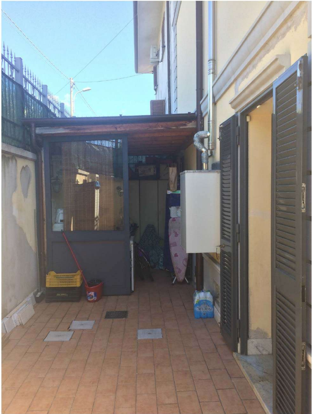
Foto 5 – Ripostiglio esterno da demolire
