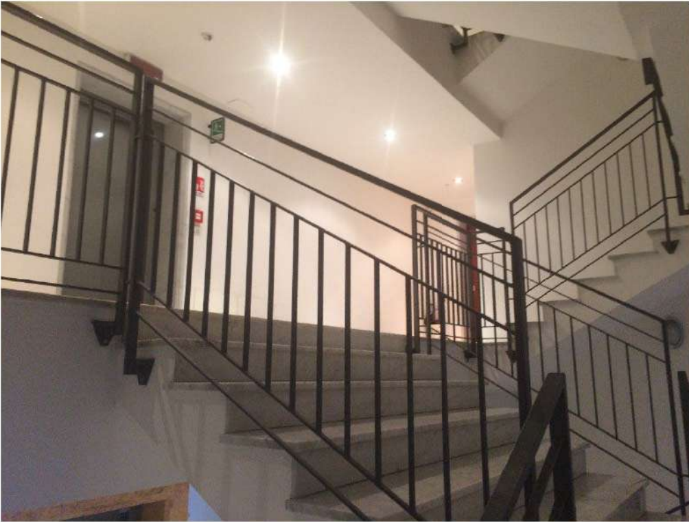
Foto 9 - Condominio “Residenza Margherita” – Rampa scale condominiali
