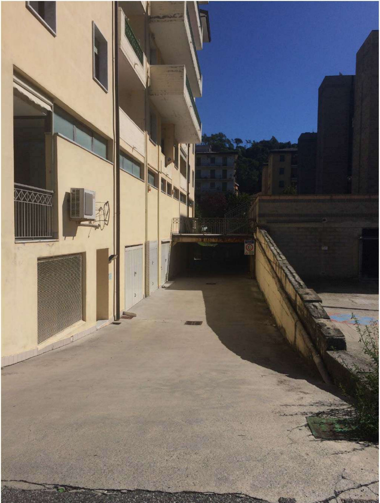
Foto 7 - Condominio “Residenza Margherita” – rampa accesso piano seminterrato
