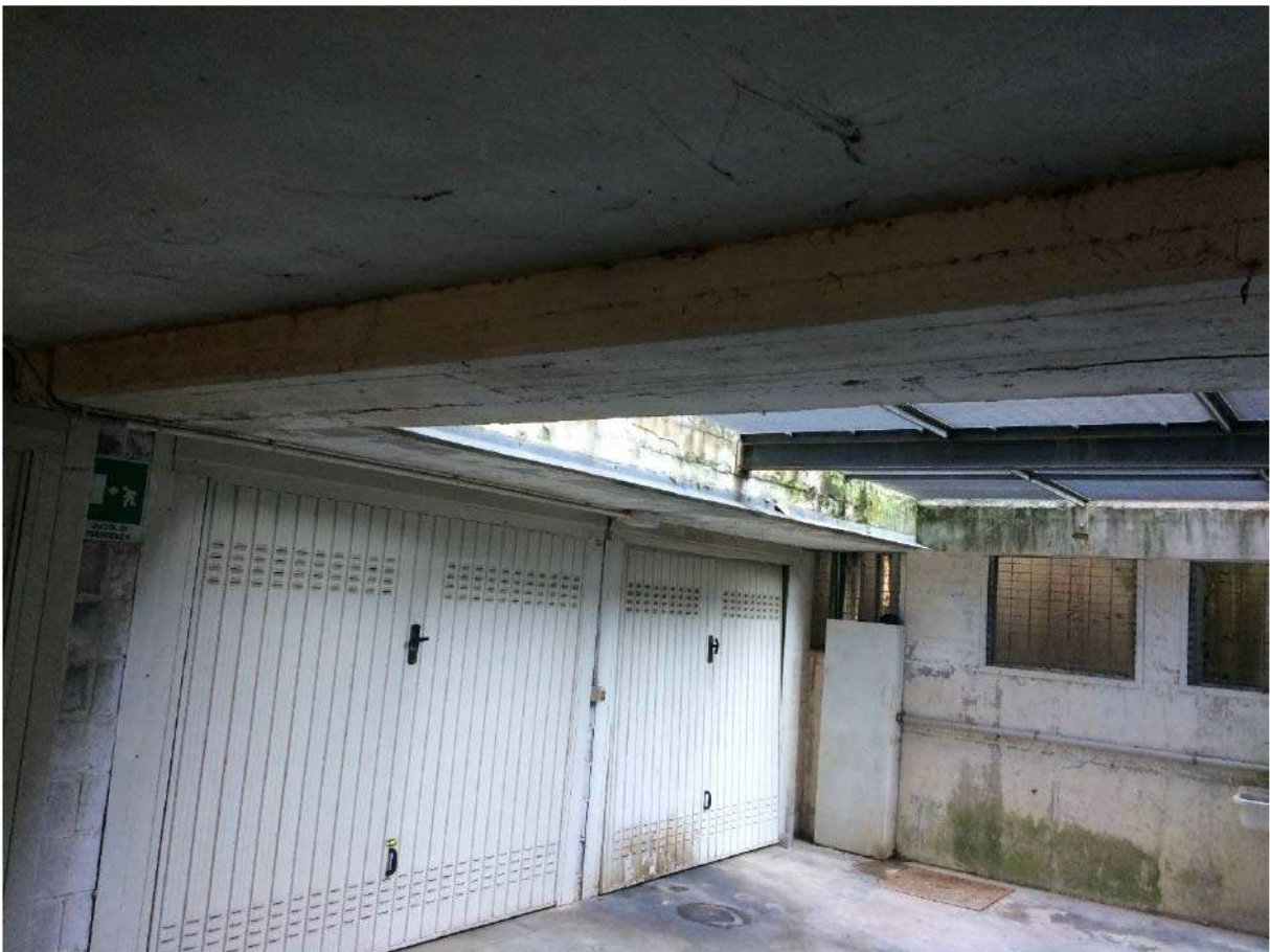
Foto 27 – Piano seminterrato autorimessa
