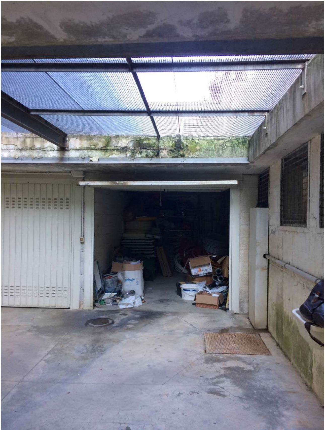
Foto 28 – Piano seminterrato autorimessa
