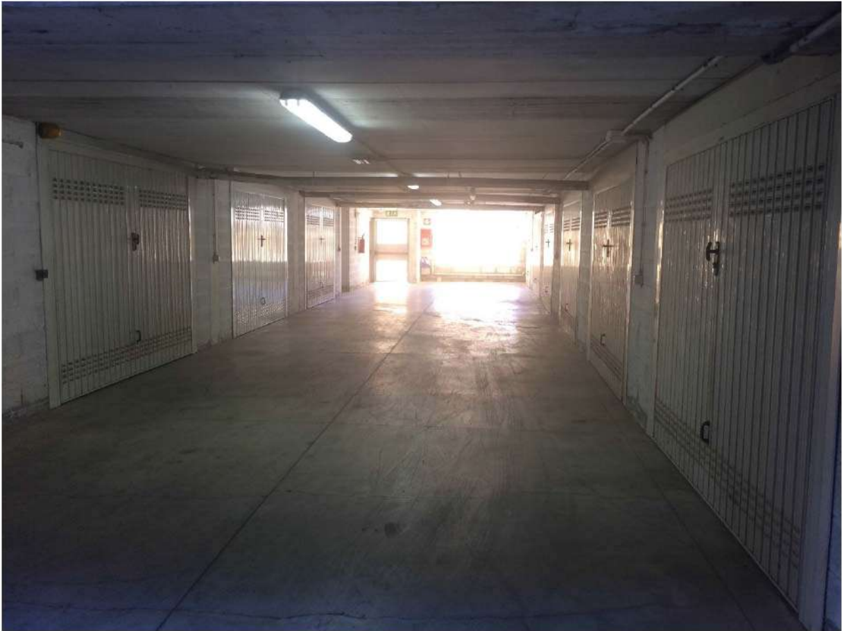
Foto 26 – Piano seminterrato autorimessa – (area di manovra)
