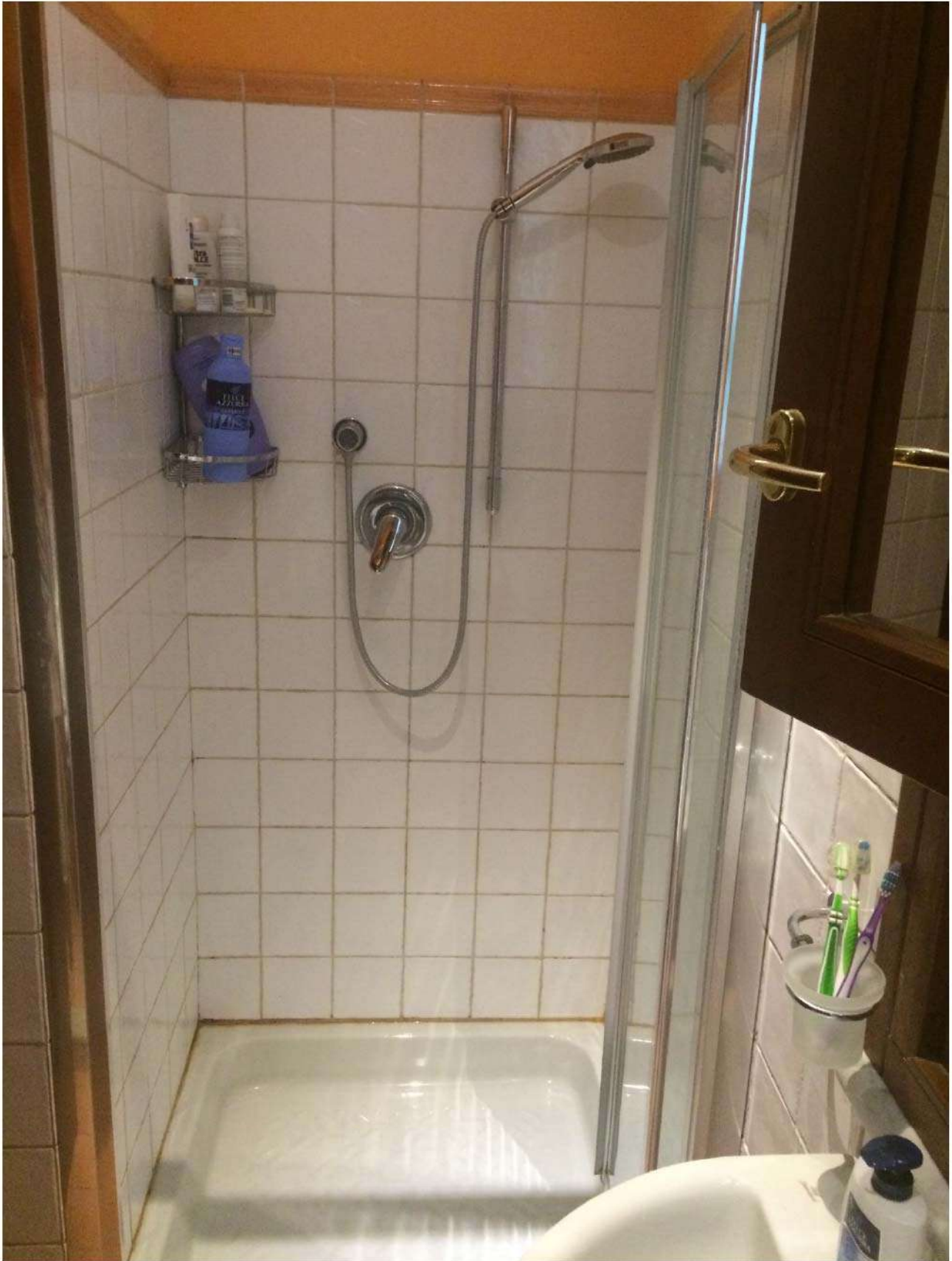
Foto 16 – Bagno con doccia piano primo (da demolire)
