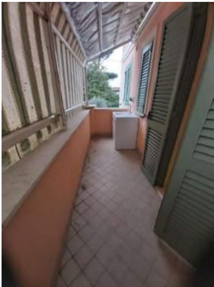
U.I.U. Mapp. 675 sub 8 Piano Primo Balcone lato Sud
