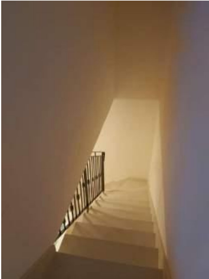
U.I.U. Mapp. 675 sub 8 Piano Primo Vista scala interna congiungimento piano primo - sottotetto
