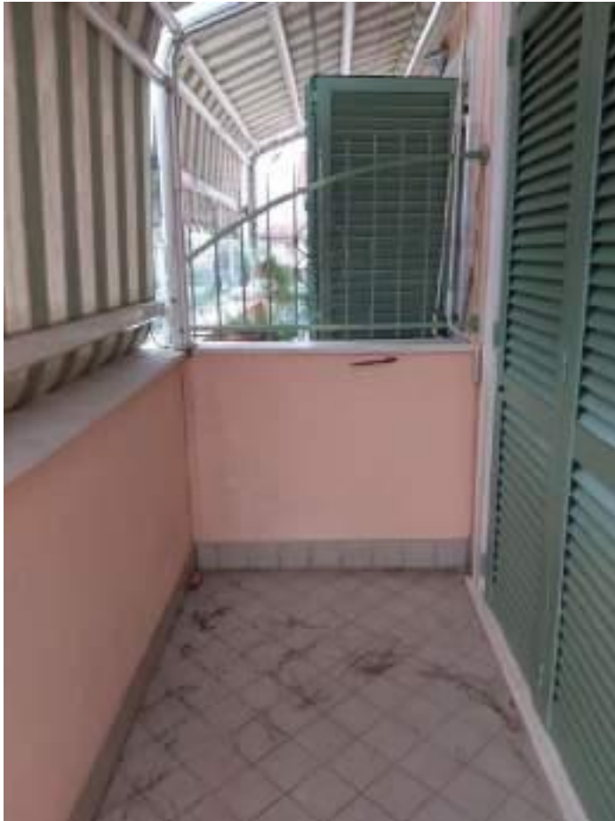
U.I.U. Mapp. 675 sub 8 Piano Primo Terrazza/Ingresso
