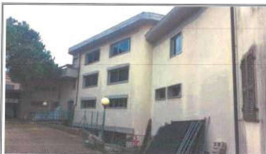
Foto n. 4 - Vista lato NORD del fabbricato
