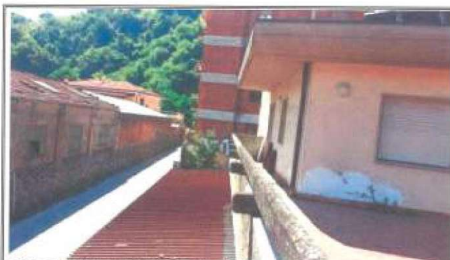
Foto n. 6 - Vista del fabbricato lato EST
