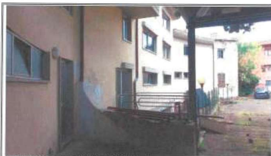
Foto n. 5 - Vista lato NORD del fabbricato
