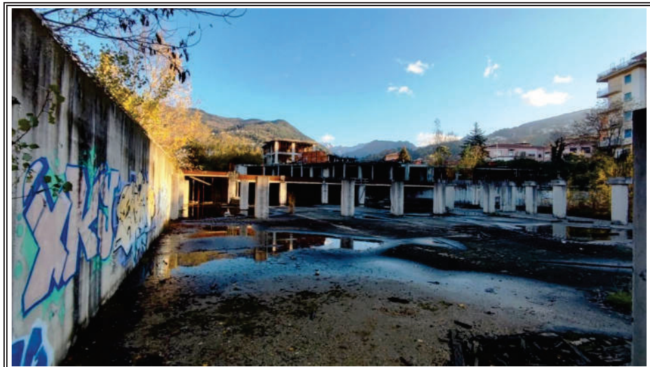
Foto n. 8 – Primo livello interrato
