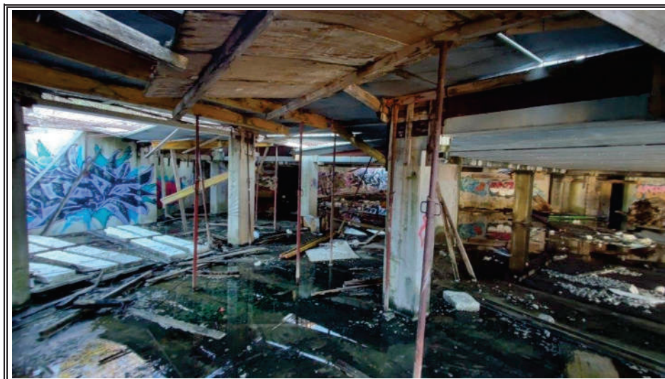
Foto n. 10 – Primo livello interrato
