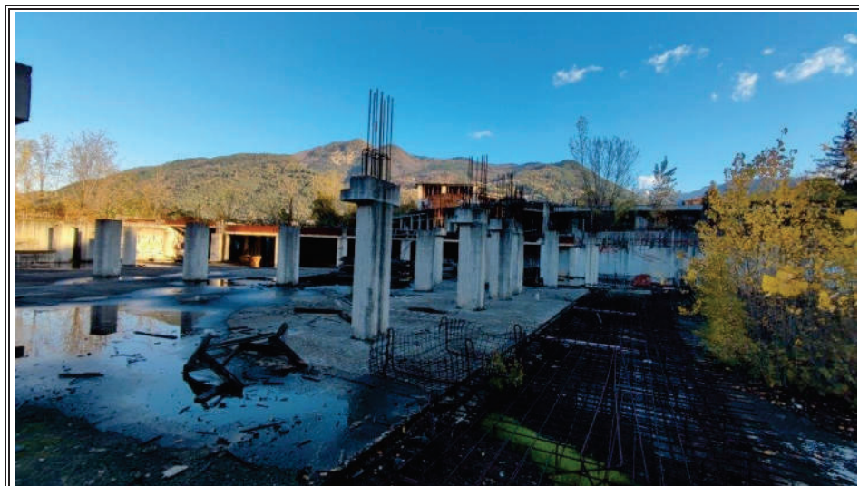
Foto n. 9 – Primo livello interrato
