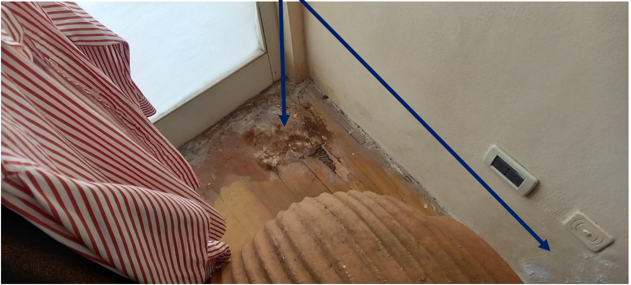
Foto 5 - Piano terra in prossimità infisso esterno
