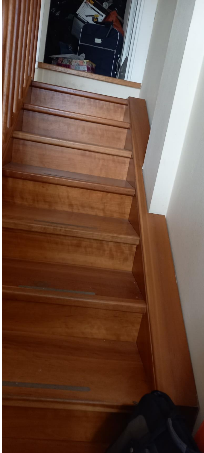
Foto 8 - Scala di accesso al mezzanino
