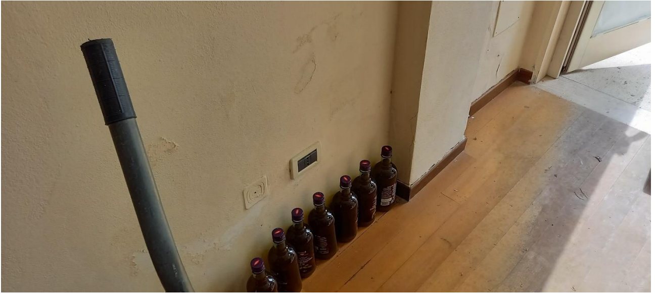
Foto 7 – Interno in prossimità ingresso
