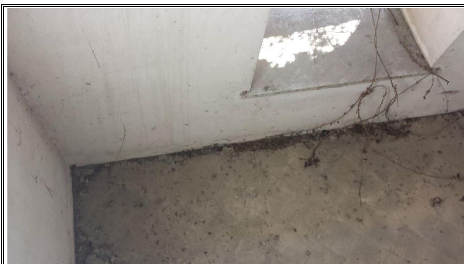
Foto n. 14 – Unità subalterno 3 - Piano interrato
