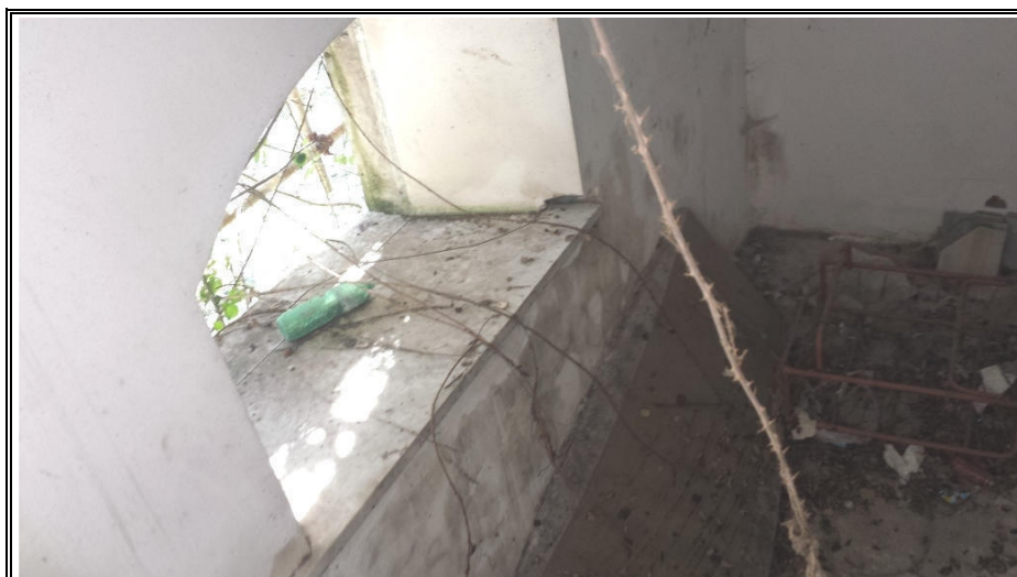
Foto n. 9 – Unità subalterno 4 - Piano Interrato
