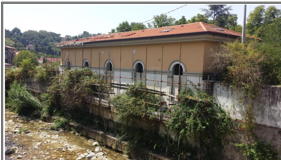
Foto n. 4 – Vista del fabbricato – Angolo NORD-EST
