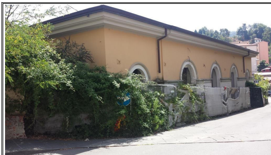
Foto n. 3 – Vista del fabbricato – Angolo NORD-OVEST
