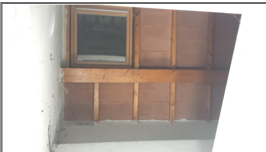
Foto n. 15 – Unità subalterno 3 - Vista solaio Piano sottotetto
