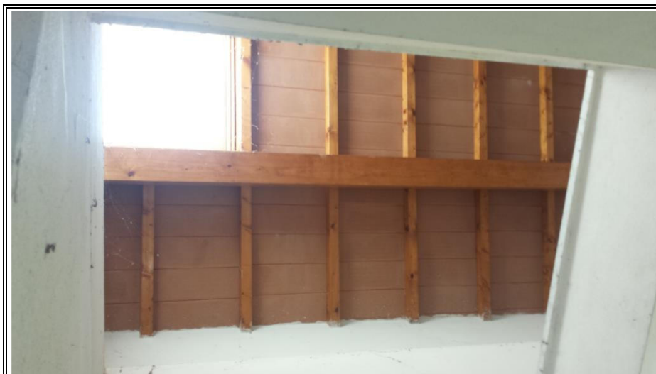
Foto n. 10 – Unità subalterno 4 - Vista solaio Piano sottotetto
