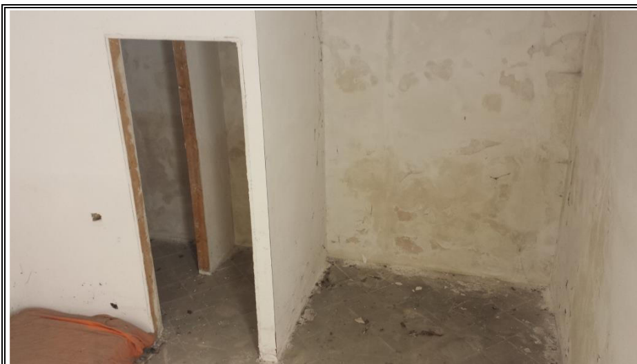
Foto n. 13 – Unità subalterno 3 - Piano interrato
