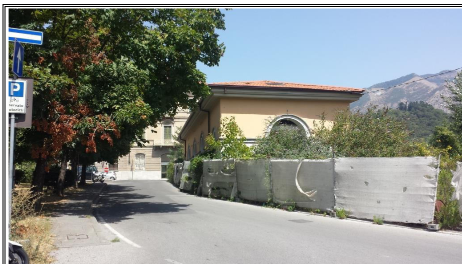
Foto n. 1 – Vista del fabbricato – Angolo SUD-OVEST
