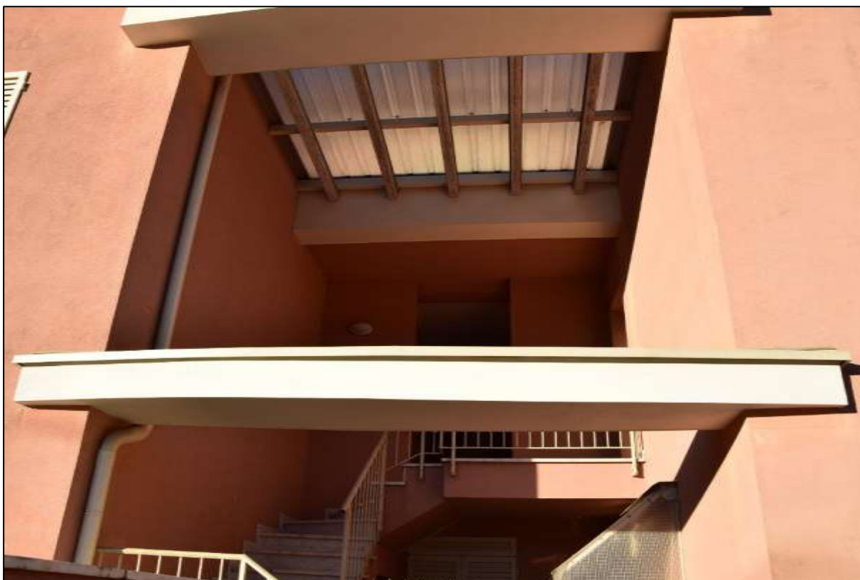
FOTO 5: SCALA CONDOMINIALE DI ACCESSO AL PIANO PRIMO
