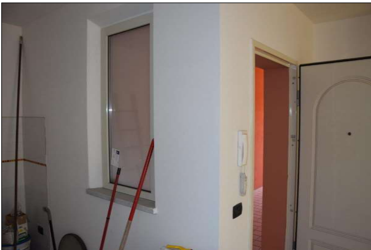
FOTO 11: PORTA DI ACCESSO E FINESTRA SU CORRIDOIO CONDOMINIALE
