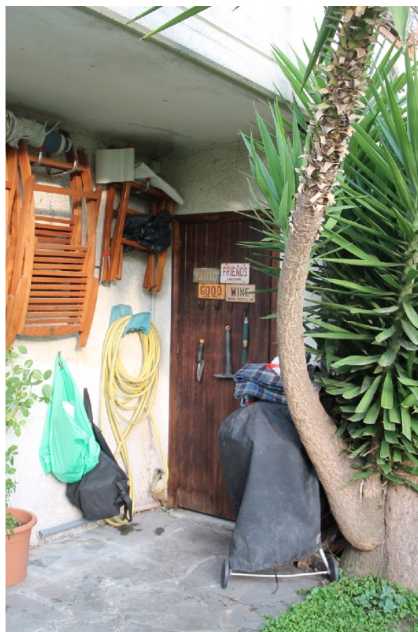
Foto 39. Locale tecnico lotto 1
