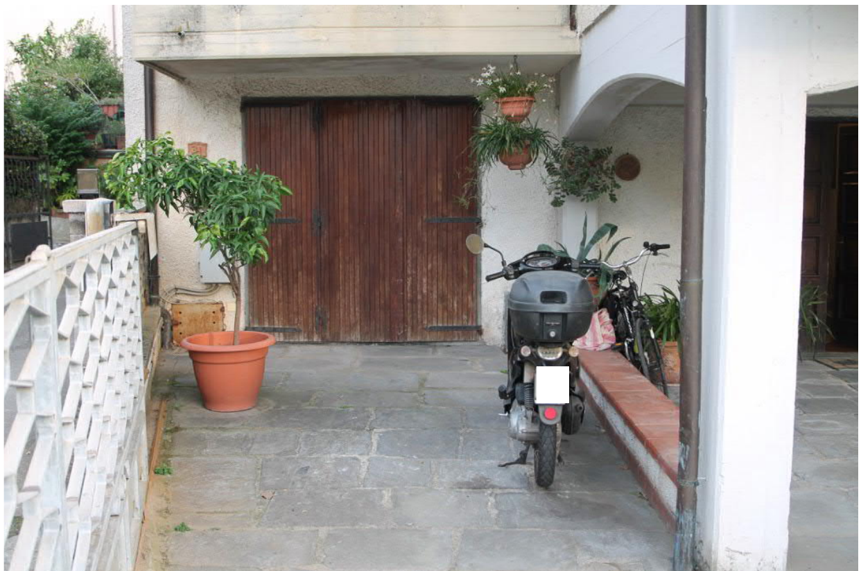
Foto 36. Prospetto lato Carrara piano terra lotto 1
