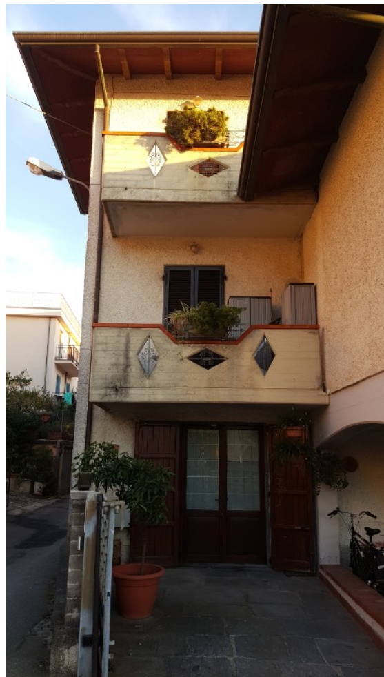
Foto 32. Prospetto lato Carrara lotto 1
