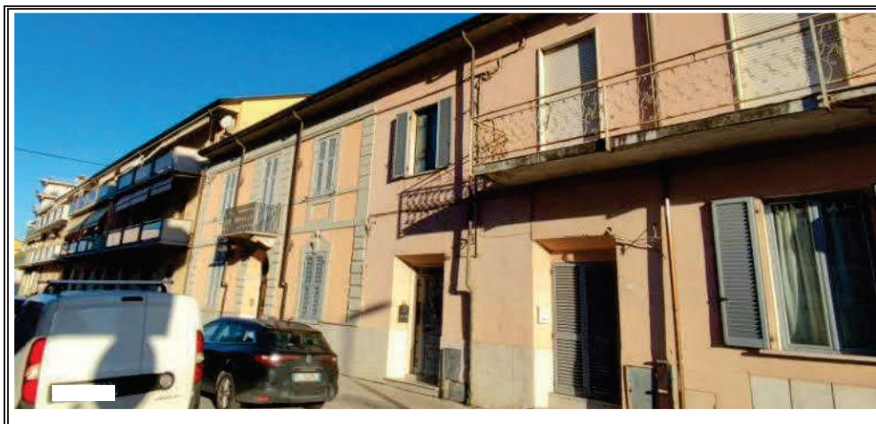
Foto n. 1 – Vista del fabbricato Via Alfio Maggiani angolo SUD
