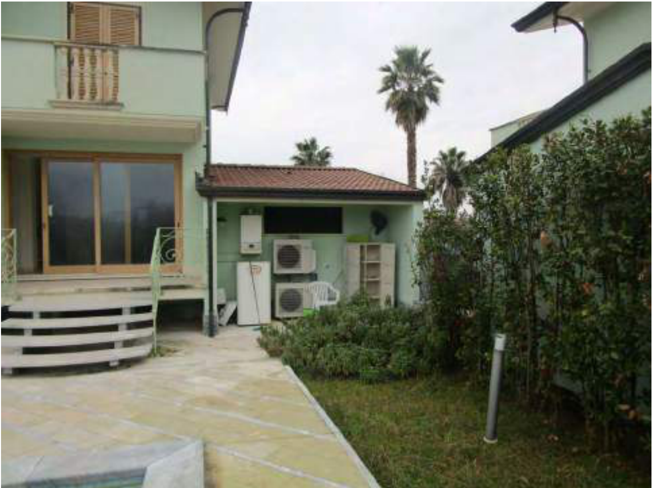
Vista esterna del FABBRICATO "B" FOTO N° 3-4
