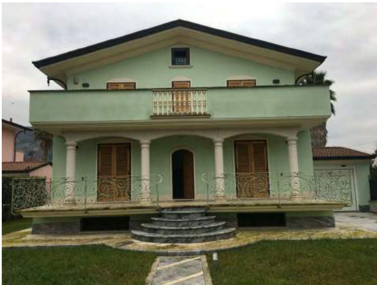
LOTTO 1 - Vista esterna del FABBRICATO "A" FOTO N° 1-2
