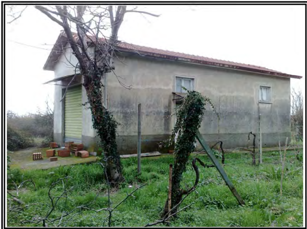
Foto n. 12 – Fabbricato rurale mappale 311
