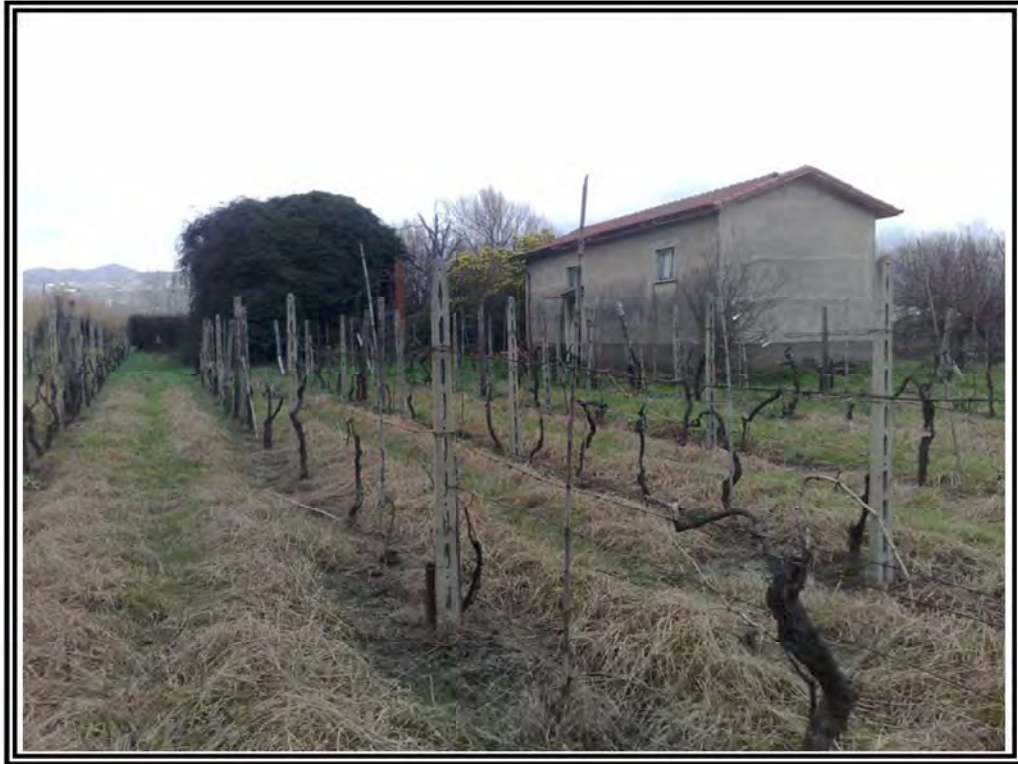
Foto n. 11 – Fabbricati rurali mappali 42 e 311
