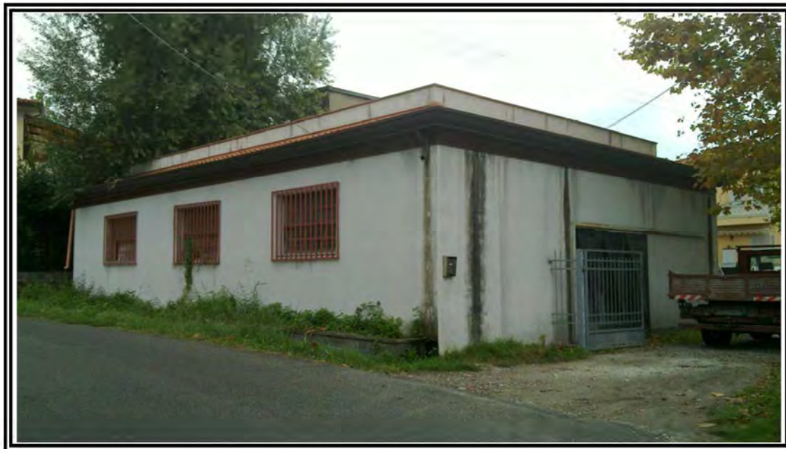
Foto n. 1 – Vista del fabbricato dalla strada
