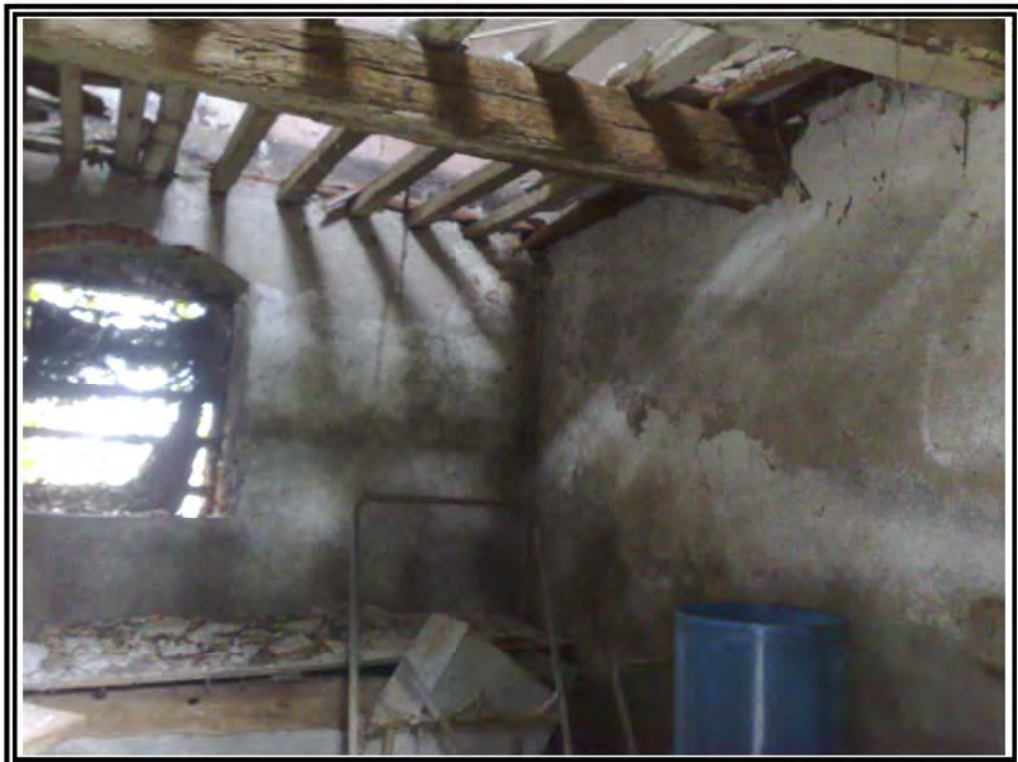
Foto n. 8 – Fabbricato rurale mappale 42 - ambienti interni
