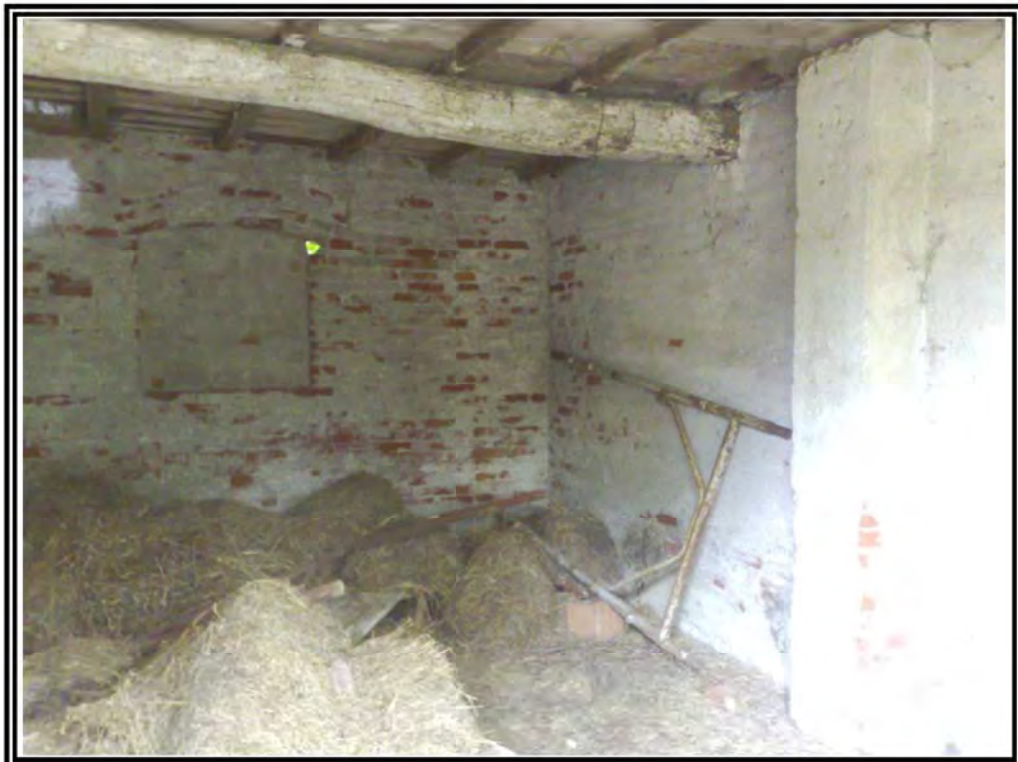
Foto n. 10 – Fabbricato rurale mappale 42 - ambienti interni
