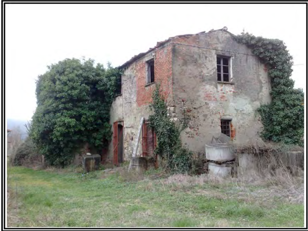
Foto n. 5 – Fabbricato rurale mappale 42
