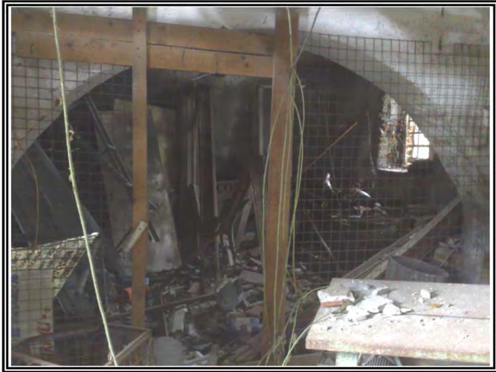
Foto n. 7 – Fabbricato rurale mappale 42 – ambienti interni
