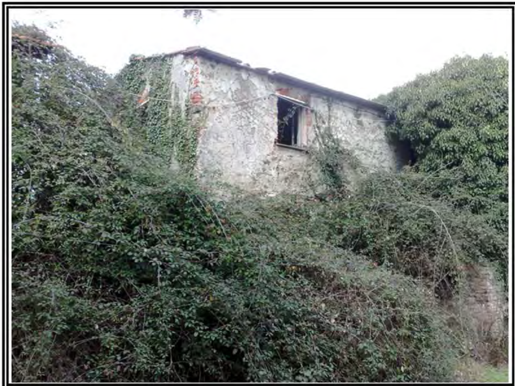
Foto n. 6 – Fabbricato rurale mappale 42
