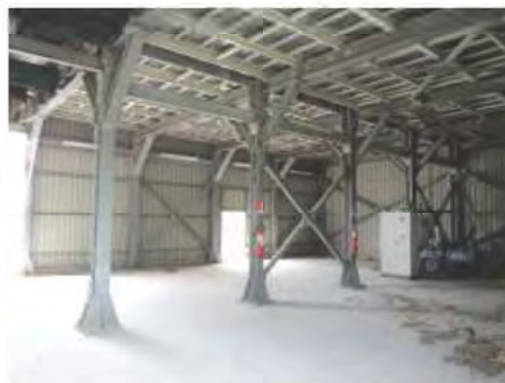
- Panoramica esterna ed interna dei silos e della tettoia
