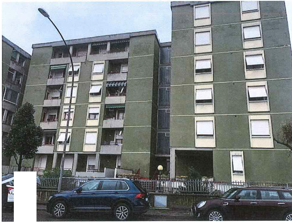
Vista del fabbricato condominiale di Via Castagnara 173 dalla viabilità e accesso pedonale
