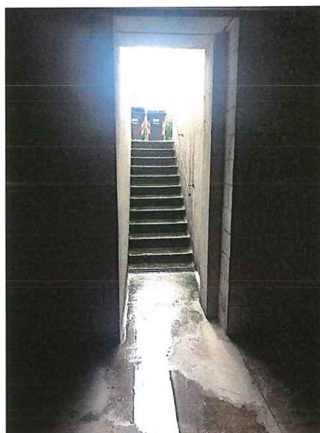
Scala di collegamento condominiale tra P.Terra e P.Seminterrato
