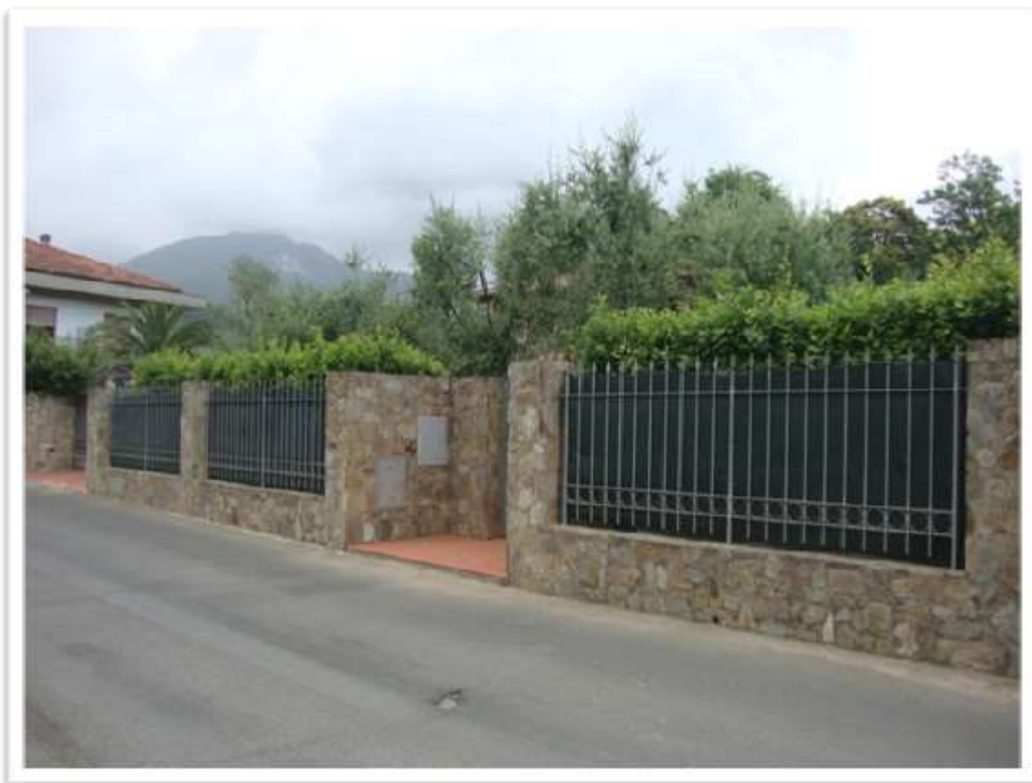
RECINZIONE LATO STRADA
