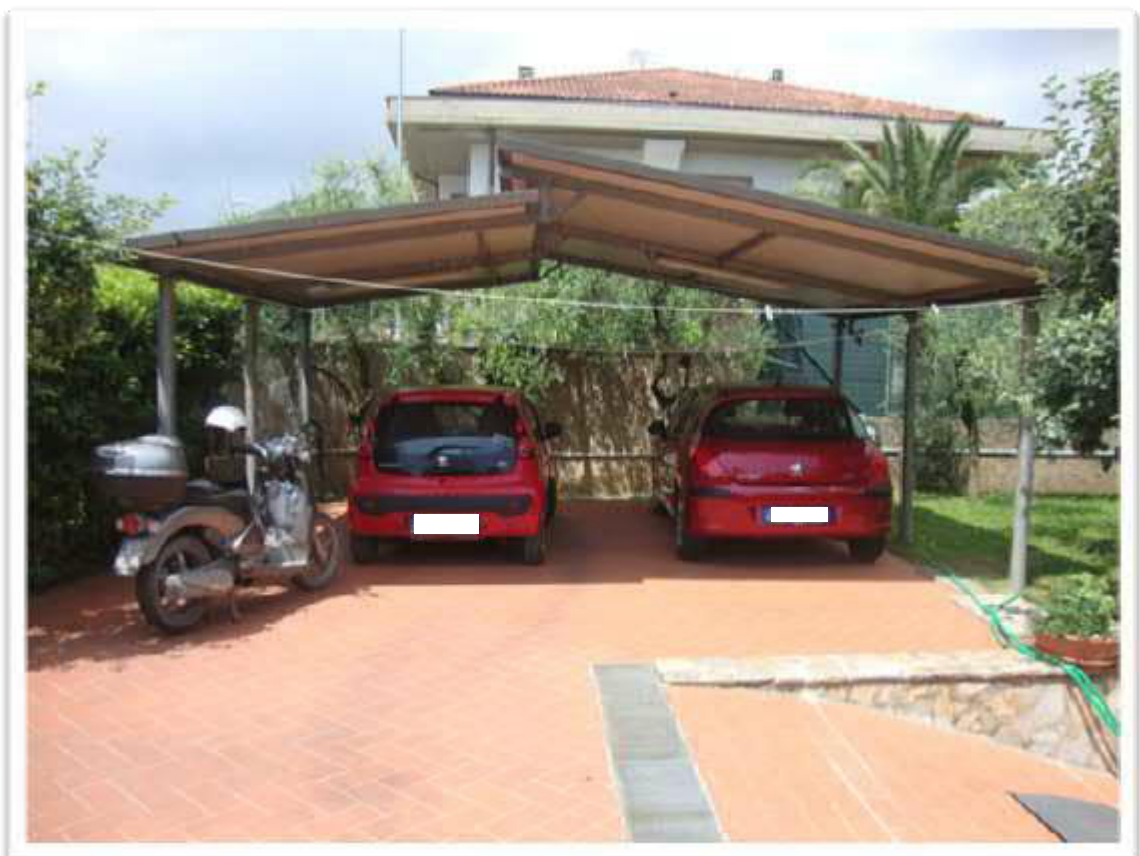
TETTOIA ADIBITA A POSTO AUTO
