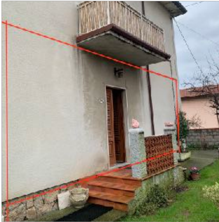
ESTERNO_ Fronte principale lato est
