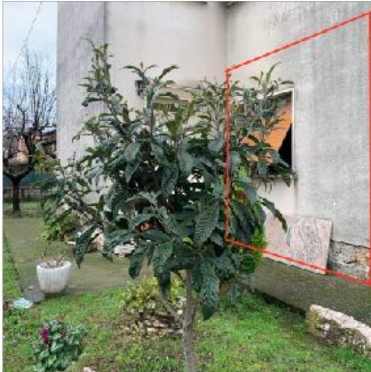
ESTERNO_ Fronte principale lato est
