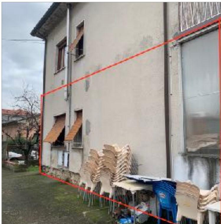
ESTERNO_ Fronte principale lato est
