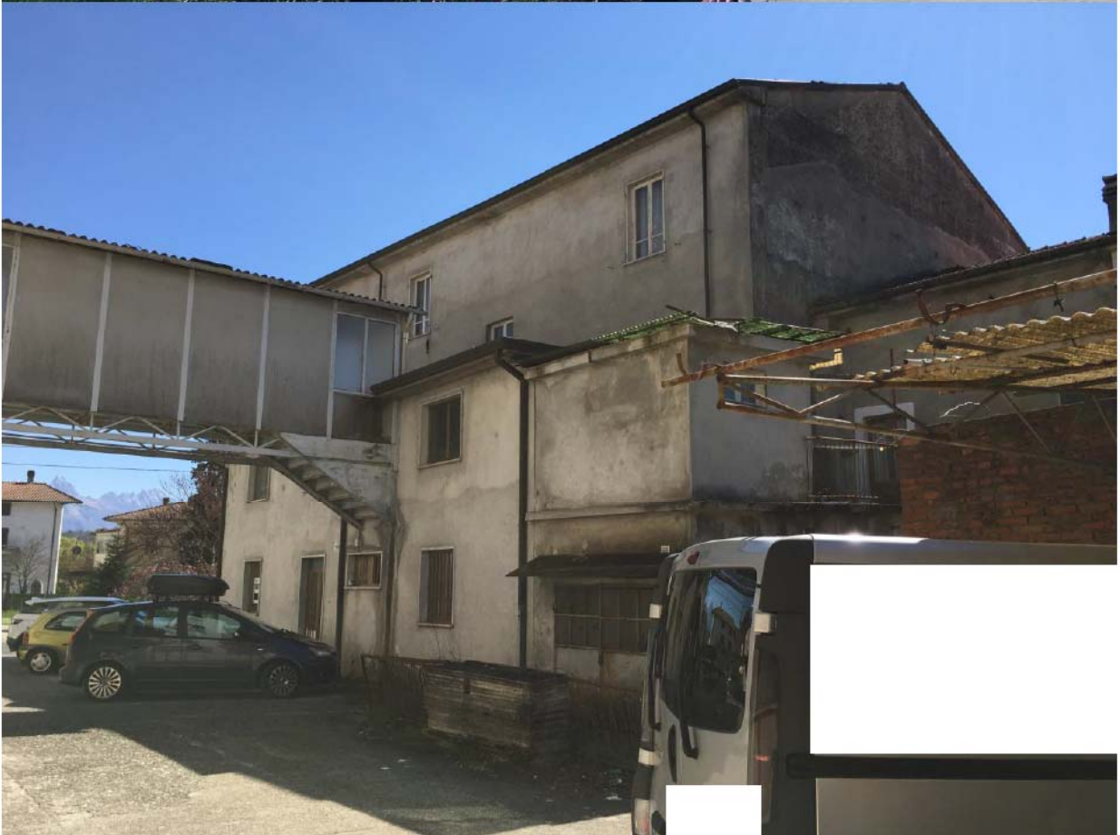
LOTTO 6 - ESTERNI FABBRICATO
