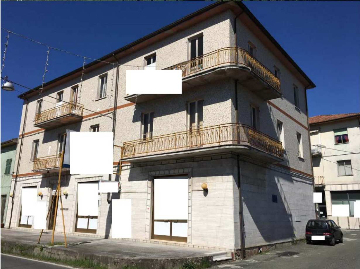
LOTTO 6 - ESTERNI FABBRICATO
