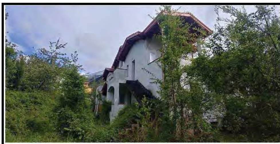
Foto n. 3 – Fabbricato angolo SUD
