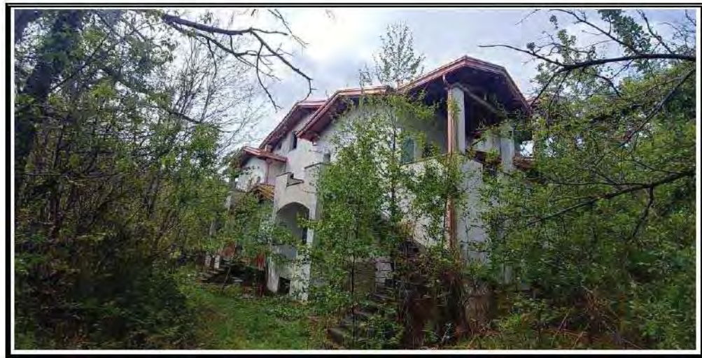
Foto n. 7 – Fabbricato angolo NORD
