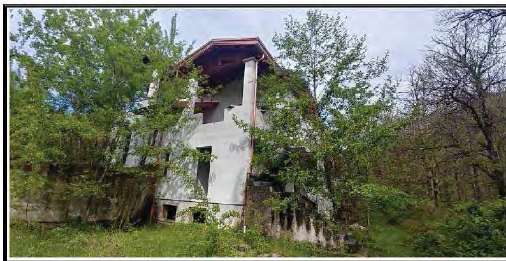
Foto n. 4 – Fabbricato angolo EST
