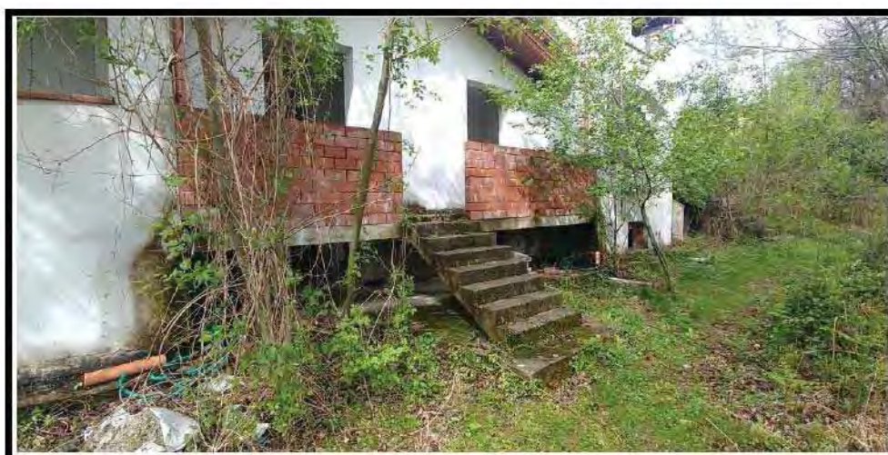
Foto n. 6 – Fabbricato facciata NORD/EST - particolare
