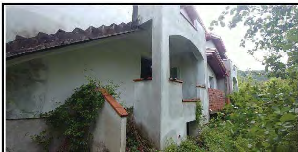
Foto n. 2 – Fabbricato angolo OVEST - particolare
