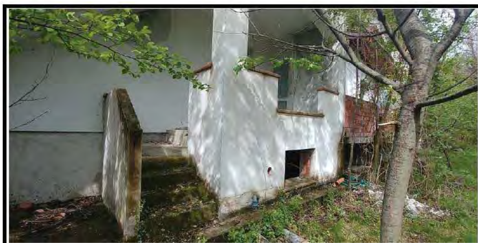
Foto n. 5 – Fabbricato facciata NORD/EST - particolare
