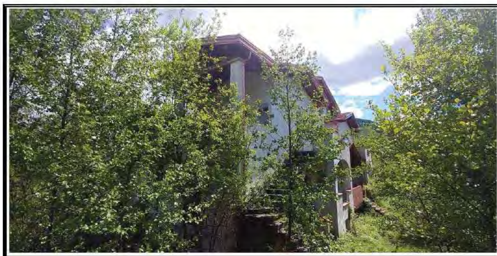
Foto n. 1 – Fabbricato angolo OVEST
