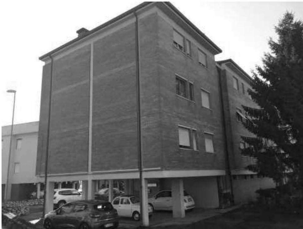
SCATTO 3 – PANORAMICA ESTERNA LATO MONTE - PONENTE
