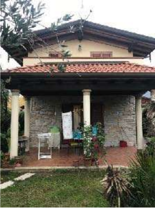
Porticato da demolire
