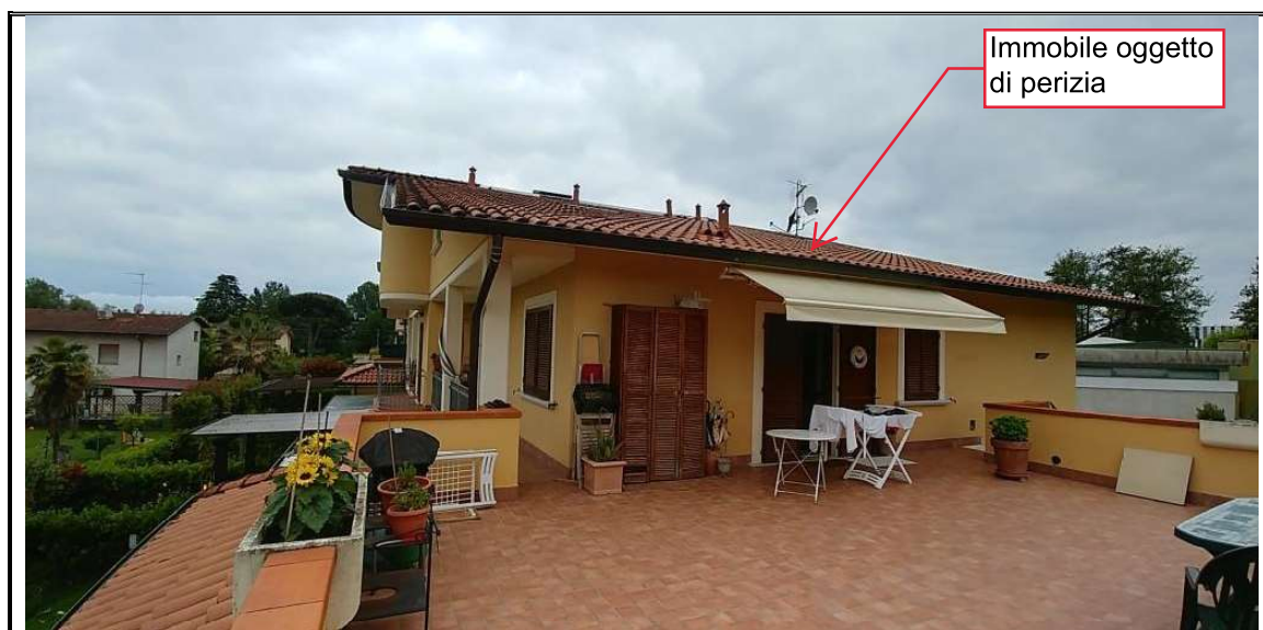
Foto n.6– Vista del bene immobile oggetto di stima– Angolo EST
