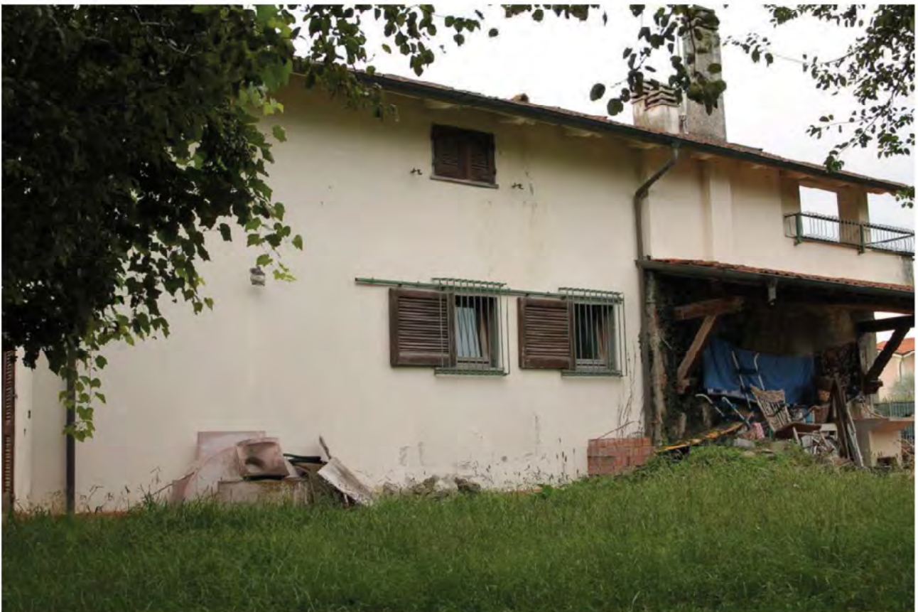
Foto 59. Esterno lato Carrara
