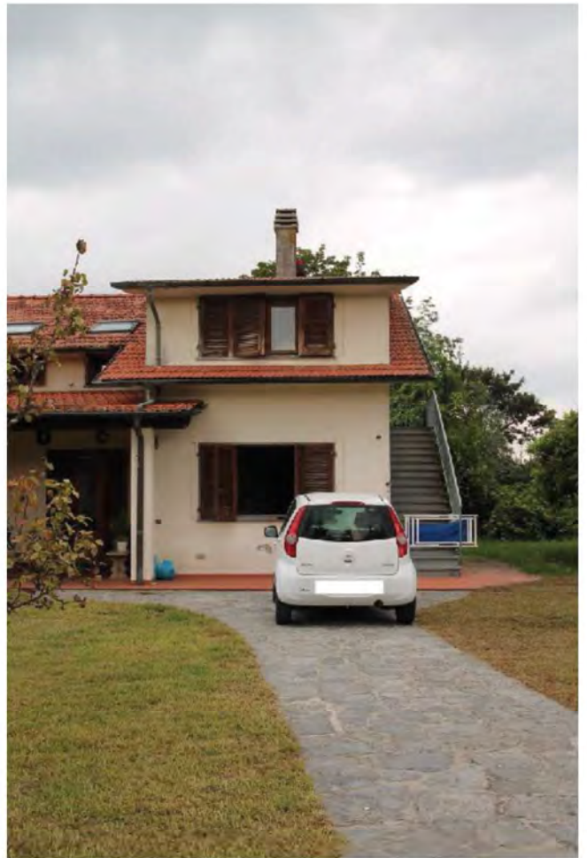
Foto 52. Prospetto lato Viareggio (P1°)
