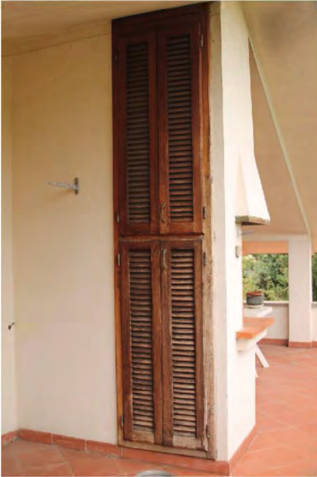
Foto 41 e 42. Terrazza lato mare (P1°)
