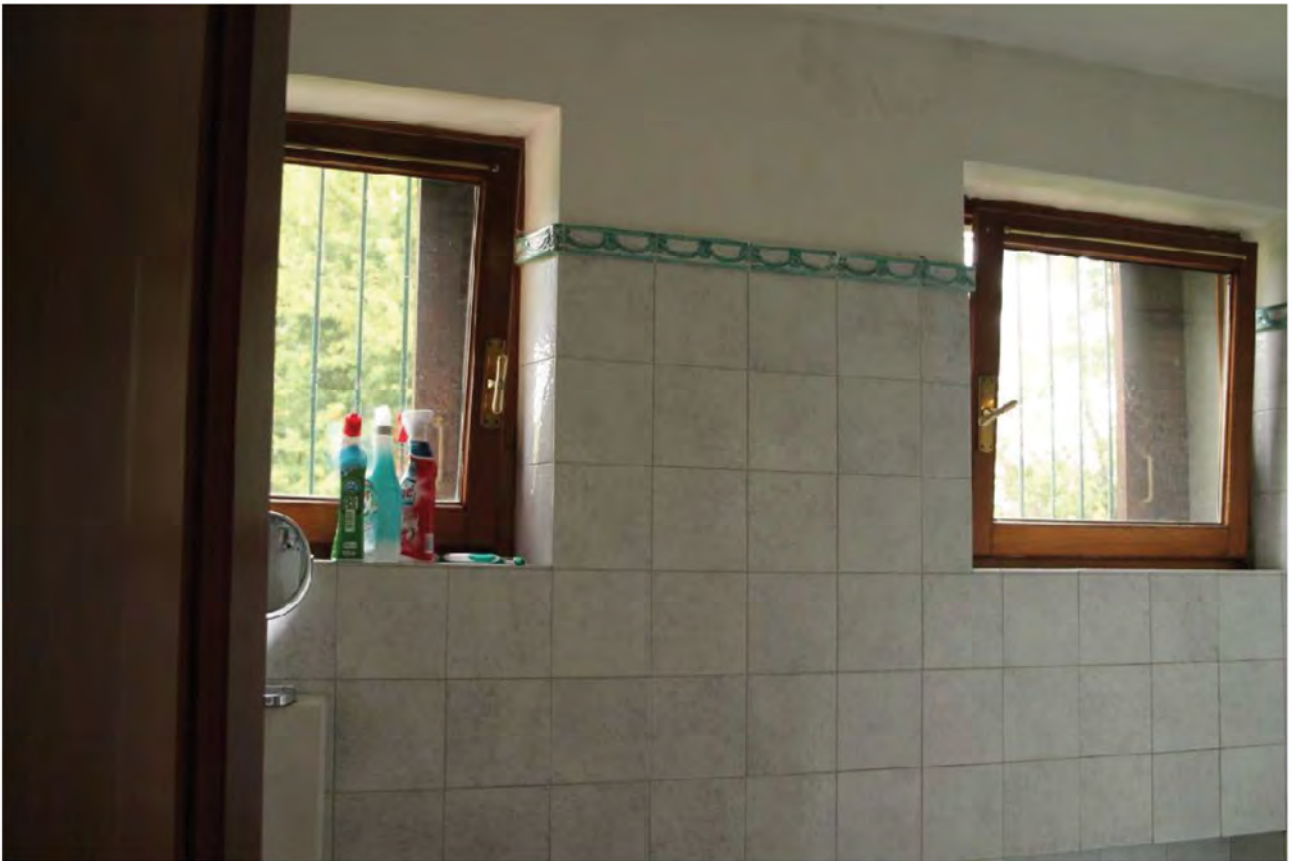
Foto 25. Finestre bagno (PT)
