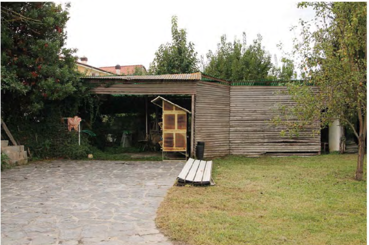
Foto 63. Tettoia abusiva da smantellare
