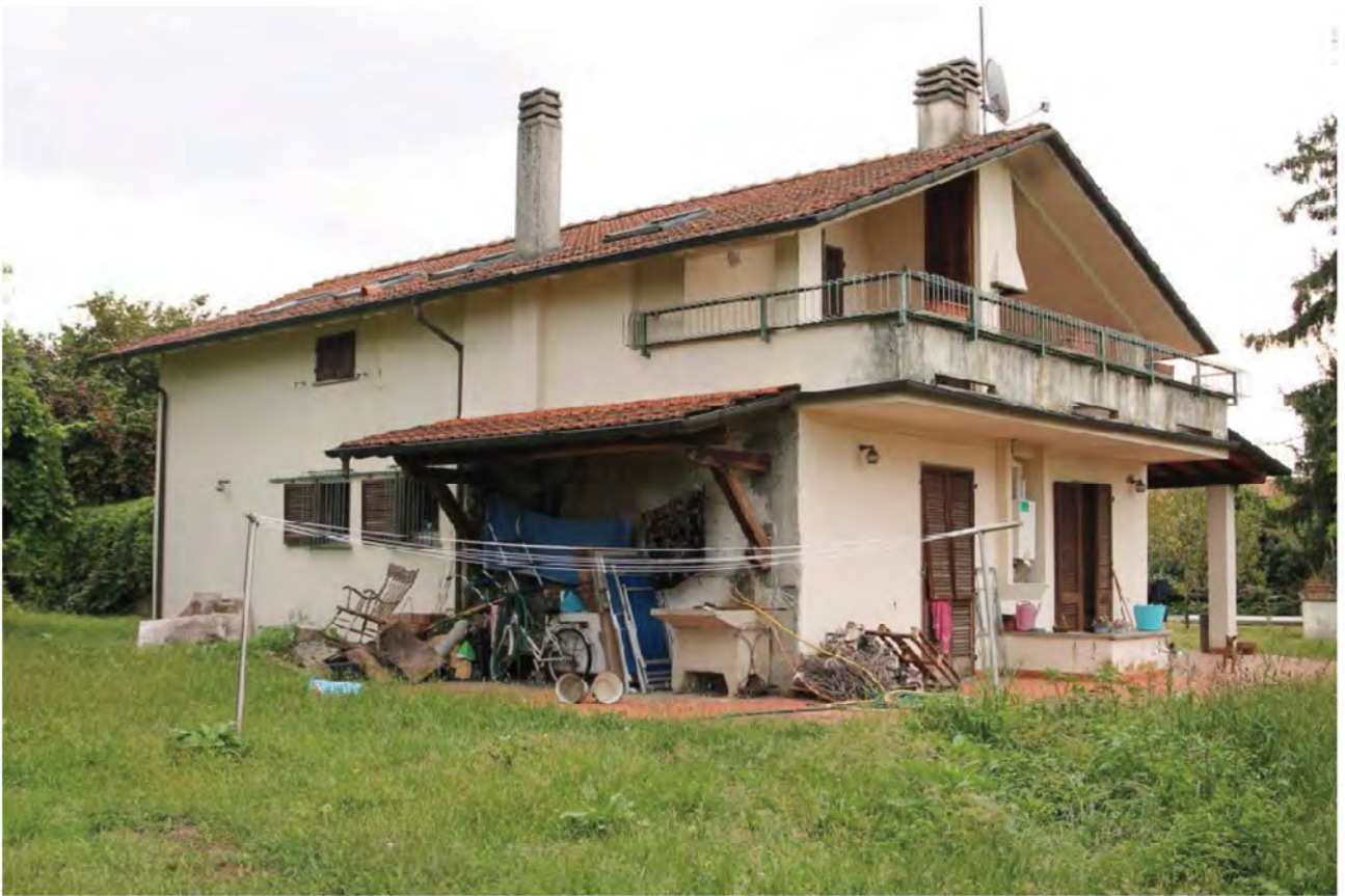
Foto 60. Esterno lato Carrara
