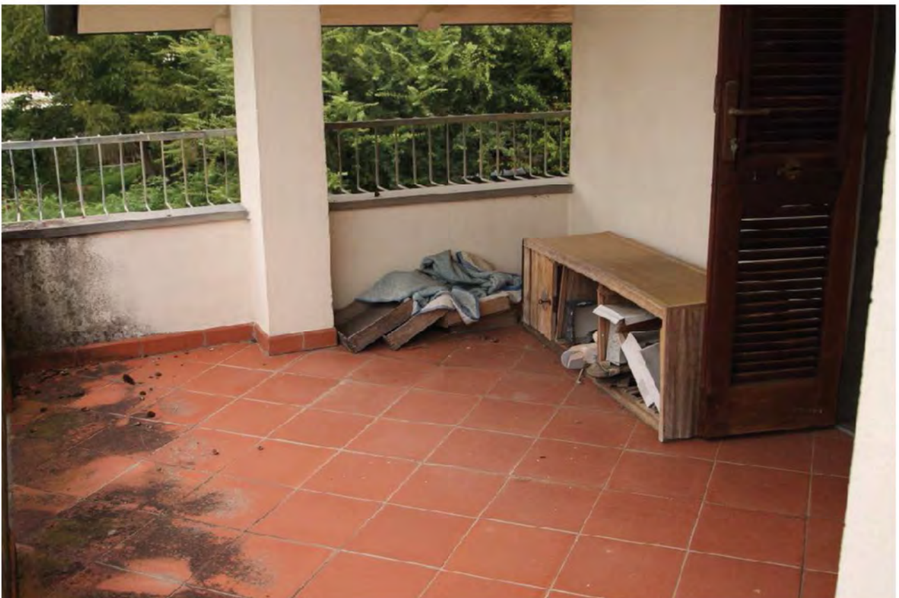
Foto 53. Terrazza lato Viareggio (P1°)
