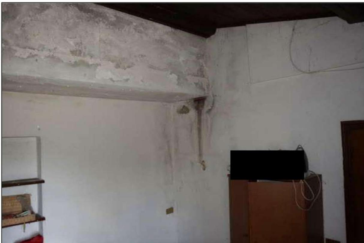
FOTO 21: PARTICOLARE DELL'INFILTRAZIONE IMPUTABILE ALLA ROTTURA DI ALCUNI TEGOLI DEL MANTO DI COPERTURA A FALDA
