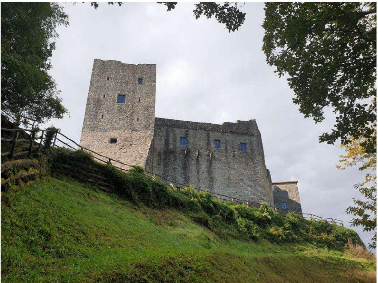
Foto 213. Castello prospetto nord
