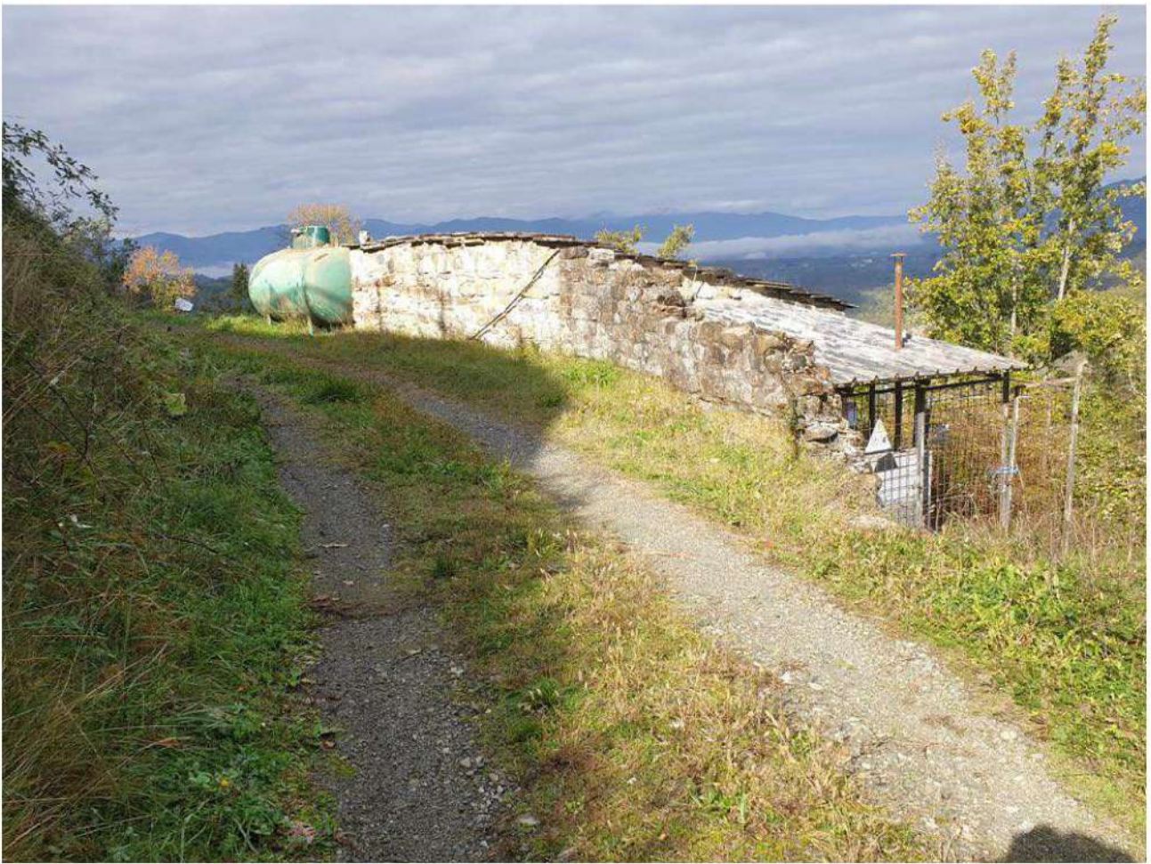
Foto 214. Locale tecnico esterno al castello
