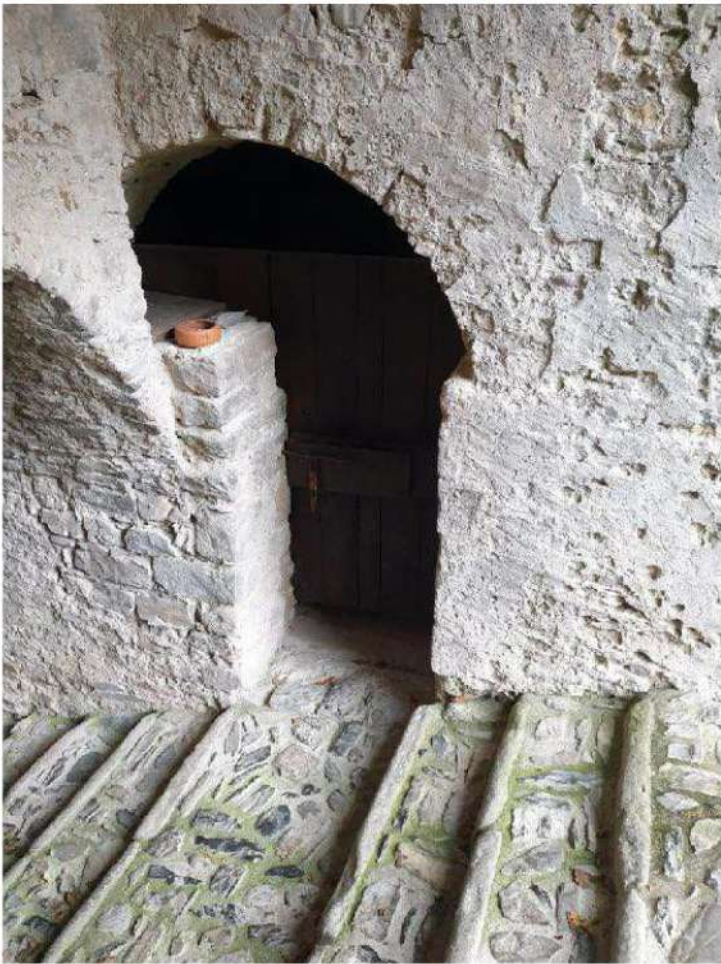
Foto 17. Ingresso a bagno seminterrato ala sud
