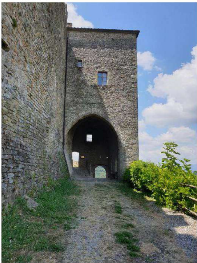
Foto 206. Ingresso a castello castello
