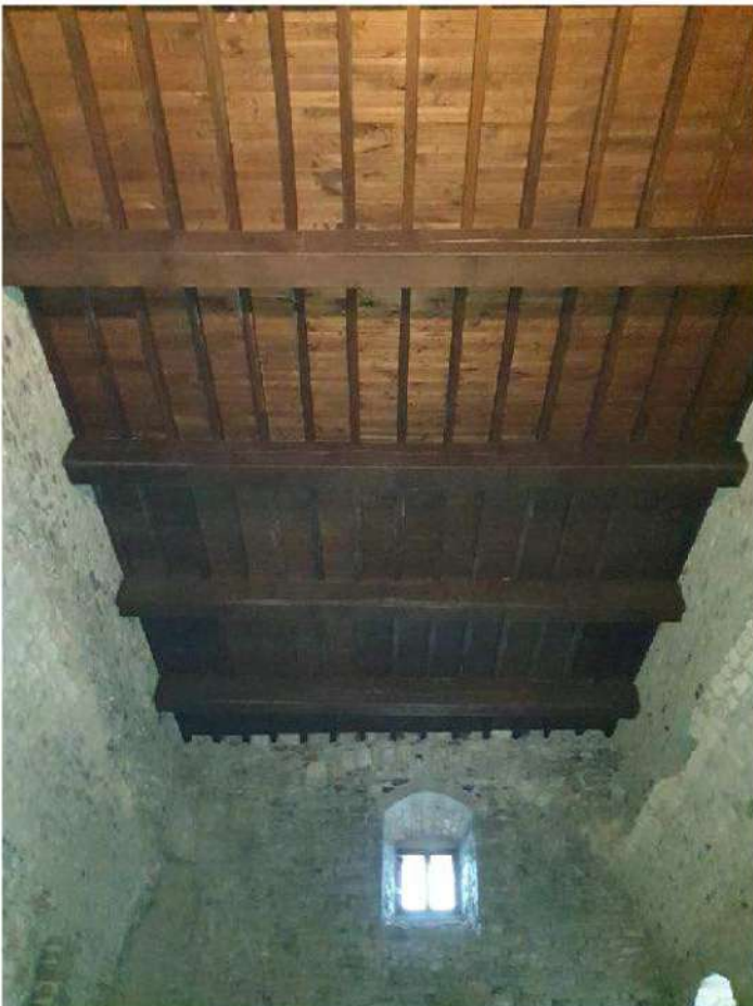
Foto 44. Sala torre piano terra
