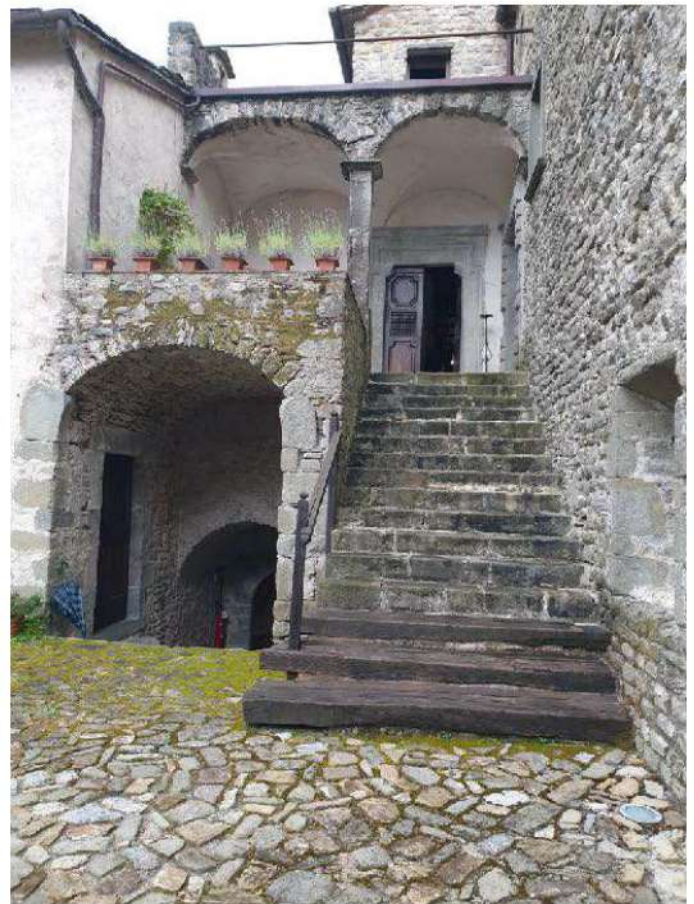
Foto 6. Scala accesso a manica sud e ovest
