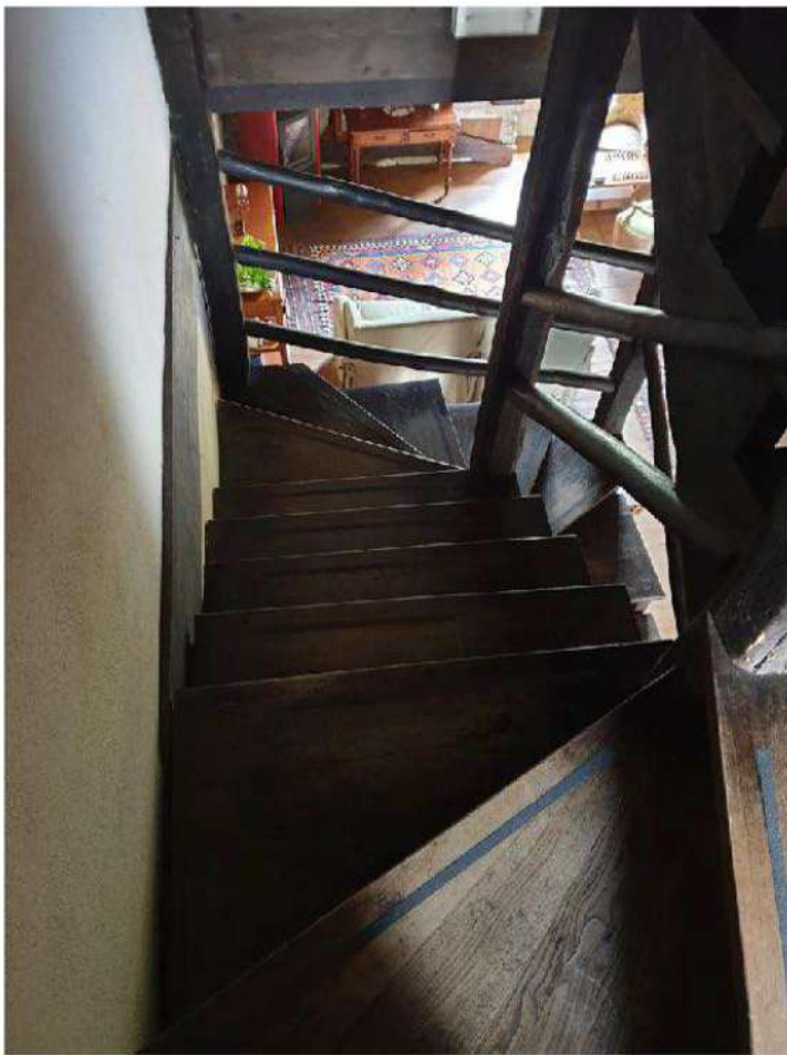
Foto 135. Scale di collegamento grande torre
