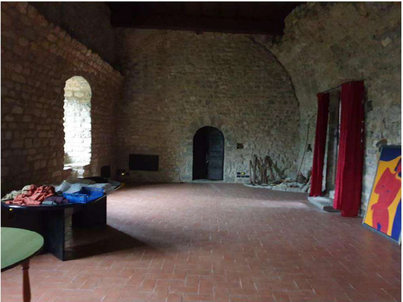
Foto 20. Sala seminterrata ala sud
