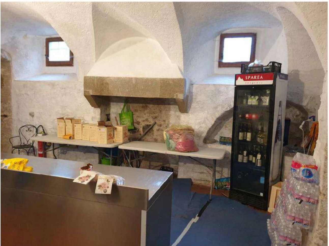
Foto 15-16. Cucina seminterrata ala sud
