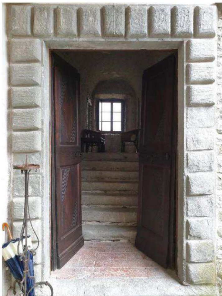
Foto 70. Ingresso a disimpegno manica ovest
