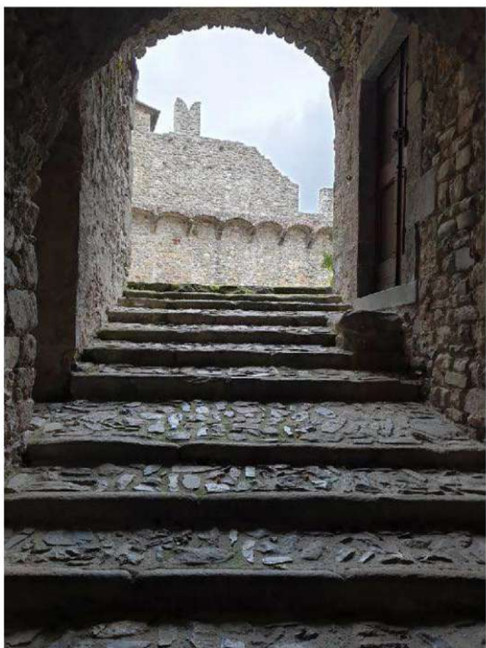
Foto 27. Scala accesso a ambienti seminterrati ala sud
