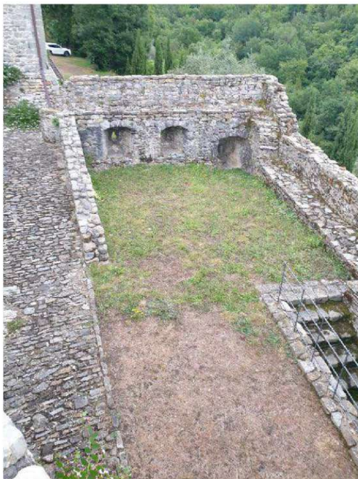
Foto 191. Area prospiciente accesso a polveriera
