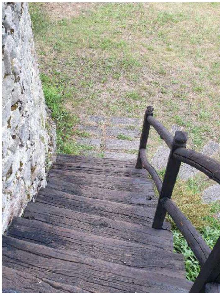
Foto 189. Scala d'accesso a castello
