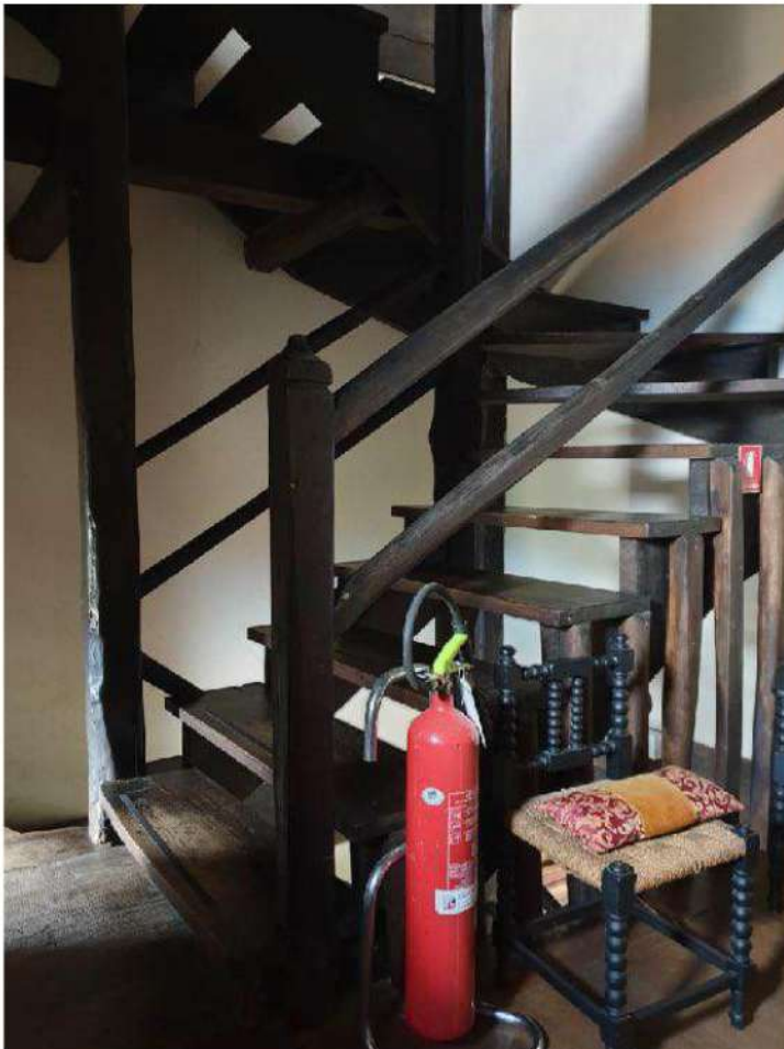
Foto 133. Scale di collegamento grande torre
