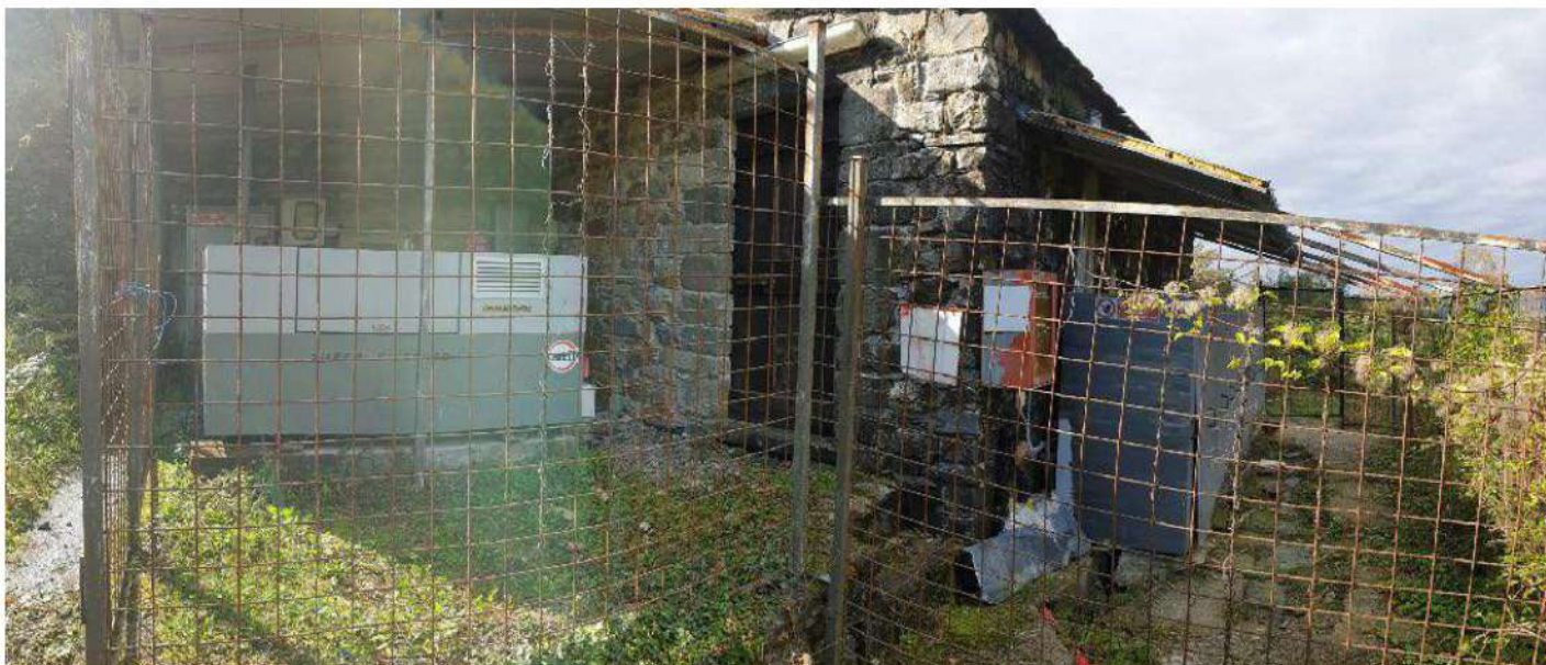
Foto 217. Locale tecnico esterno al castello
